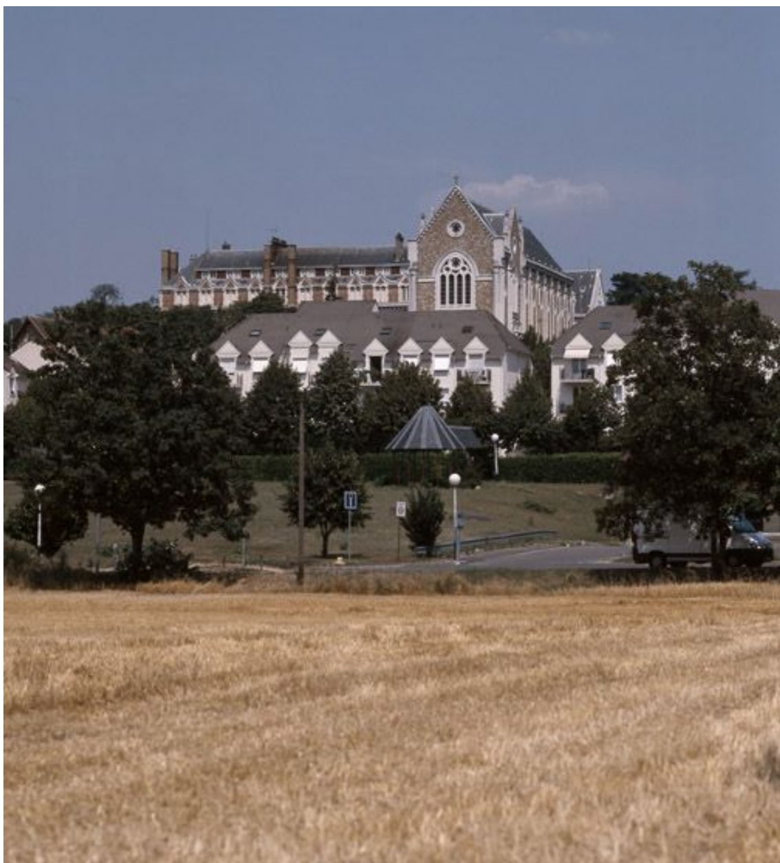
Le préventorium vu des bords la Seine avec au premier plan le lotissement des Coteaux de Champrosay.
