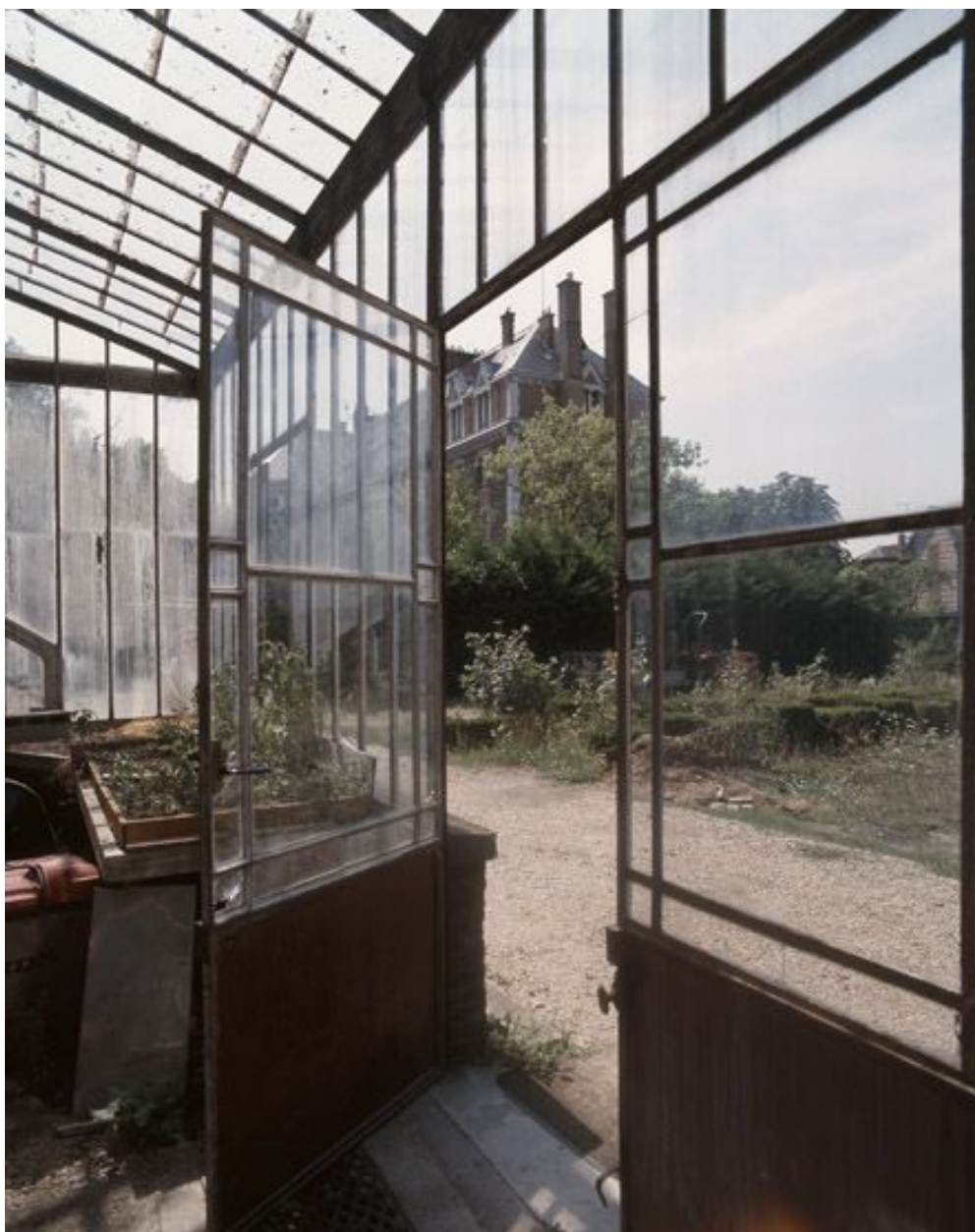
Vue du bâtiment de la communauté prise de l'intérieur de la serre.
