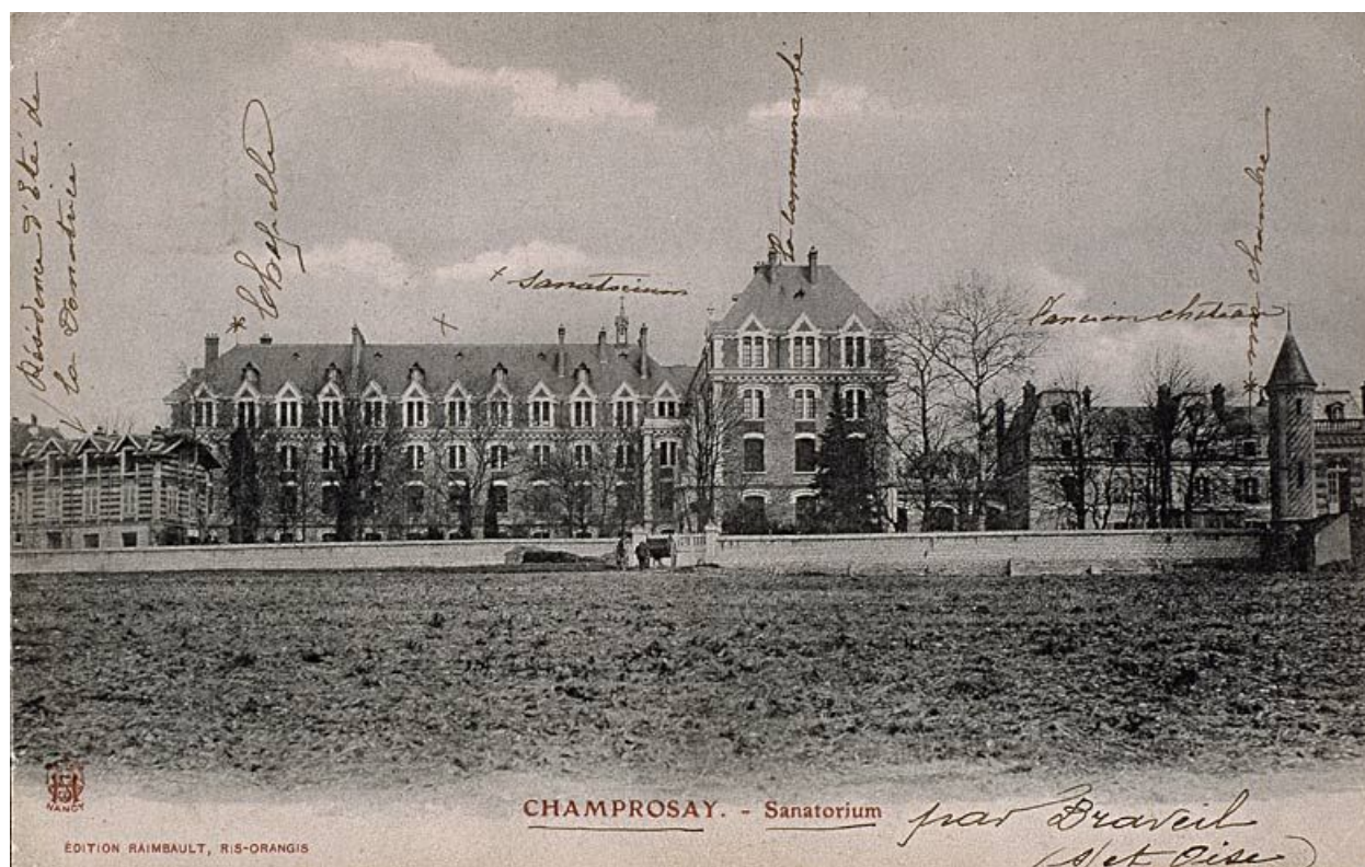
Vue d'ensemble ; de gauche à droite, le chalet Béthanie (résidence d'été de la fondatrice), le bâtiment de la communauté ou pavillon Saint-Michel, le ""pavillon de tête"" situé à l'avant de la chapelle, la galerie de liaison et l'ancien château dit pavillon Saint-Gabriel. Carte postale, vers 1910. (AD Essonne, 2 Fi 63)
