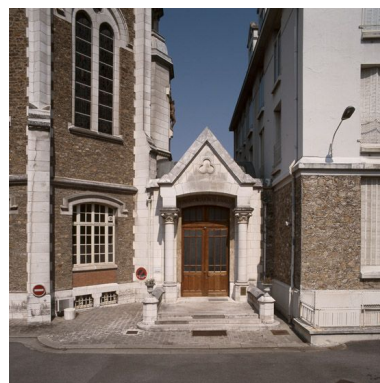
Entrée principale du préventorium, entre le chevet de la chapelle et le bâtiment de cure Saint-Raphaël. Phot. Philippe Ayrault IVR11_20069100584XA
