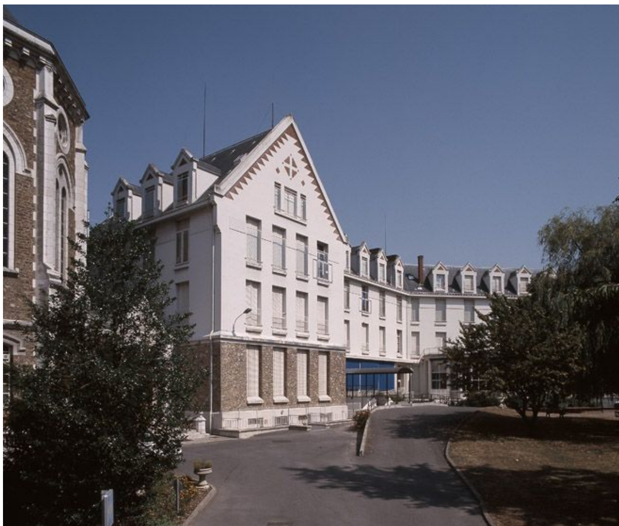
Le pavillon des malades Saint-Raphaël prolongé par le bâtiment de cure incurvé.
