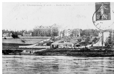
Vue d'ensemble du Préventorium sur le coteau de Champrosay, face à la Seine ; de gauche à droite,
