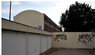
Poissy, usine, actuellement atelier Miroiterie de Poissy et supermarché Franprix, angle 16 boulevard Devaux et 2 rue Paul Codos. Halle en béton armé, couverte d'un toit bombé en voile de béton.
