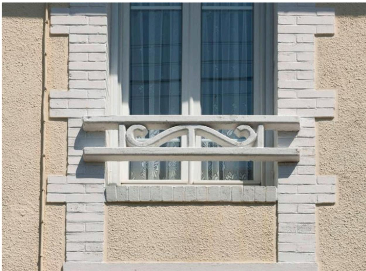
Les Mureaux. Logements ouvriers, rue du Pont-de-Claix. Détail d'un garde-corps en ciment.
