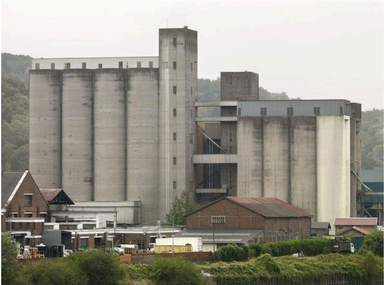
Bonnières-sur-Seine, silos de la Société anonyme des silos de Bonnières, quai de Seine. Les deux silos en béton armé, à cellules cylindriques apparentes, flanqués de leurs tours de travail.
