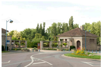
Vue de l'entrée du cimetière. Le pavillon du gardien. Phot. Laurent Kruszyk IVR11_20177800915NUC4A
