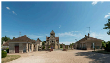
Vue de l'entrée du cimetière encadrée par deux pavillons. Phot. Laurent Kruszyk IVR11_20177800916NUC4A
