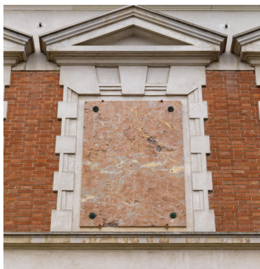
Plaque funéraire, sur la façade est de l'Hôtel de Ville, au premier étage. Phot. Asseline Stéphane IVR11_20259100241NUC4A
