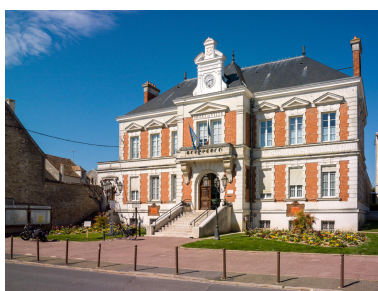
Vue de l'angle sud-ouest de la façade principale de l'Hôtel de Ville de Milly-la-Forêt (orientée sud). Phot. Asseline Stéphane IVR11_20259100128NUC4A
