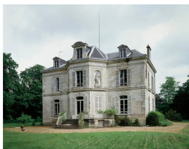
Vue d'ensemble de la façade postérieure. Phot. Vialles Jean-Bernard IVR11_19997800605VA
