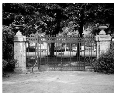
Vue d'ensemble du portail, prise depuis l'intérieur du parc. Phot. Vialles Jean-Bernard IVR11_19907800286X
