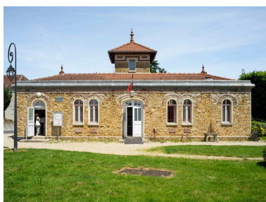
Façade antérieure des bains-douches. Phot. Augustin Dupuid IVR11_20217700197NUC4A
