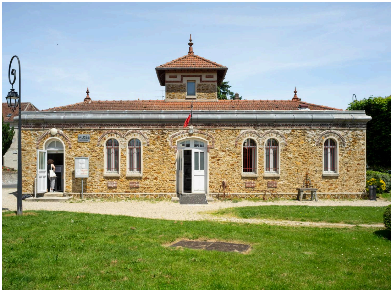
Façade antérieure des bains-douches.
