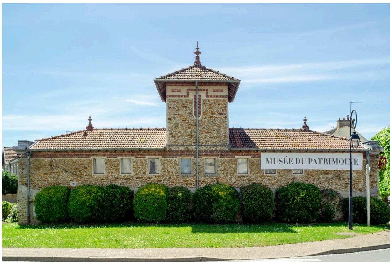
Façade postérieure des bains-douches.
