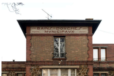
Détail de l'inscription "Bains-douches municipaux" et de la surélévation construite sur l'aile de bains-douches des femmes.
