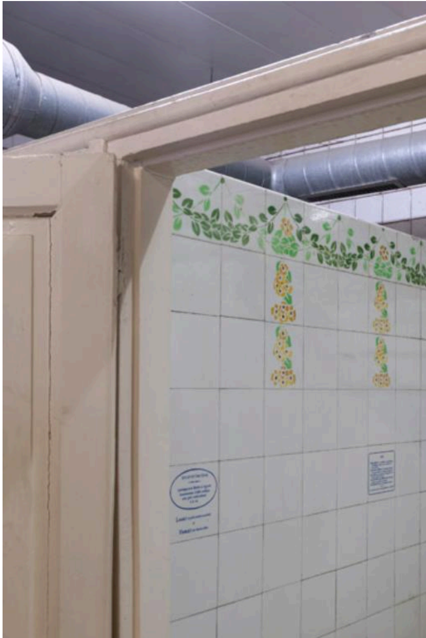
Détail des parois murales d'un déshabilleur côté hommes.
