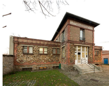
Vue générale de l'aile des bains-douches réservée aux hommes. Phot. Laurent Kruszyk IVR11_20179300023NUC4A
