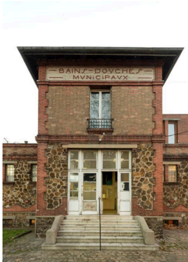
Détail de l'avant-corps central abritant la salle d'attente, au rez-de-chaussée et à l'étage, le logement du gardien. Phot. Laurent Kruszyk IVR11_20179300022NUC4A
