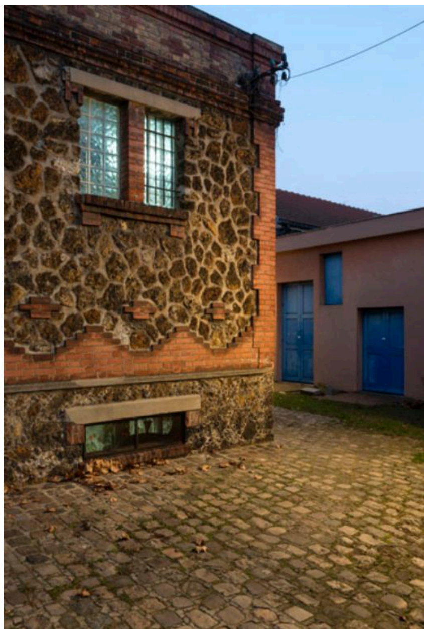
Détail de l'aile des femmes, avec l'appareil de pierre meulière.
