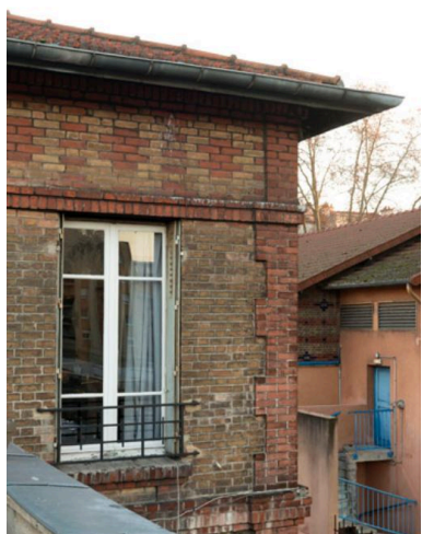
Détail de l'une des fenêtres du logement du gardien, au 1er étage.
