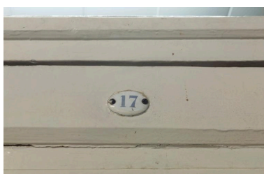
Une plaque ronde en faïence portant le numéro de l'une des cabines. Phot. Laurent Kruszyk IVR11_20179300006NUC4A
