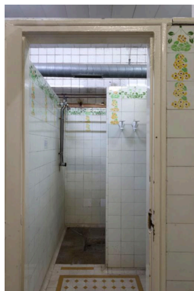
Une cabine de bain-douche côté hommes, avec son déshabilleur et sa douche proprement dite, équipée d'un sol en ciment et d'un système de trop-plein.
