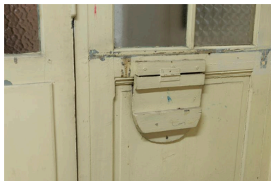
Détail d'une petite tablette en bois pivotante, sur l'un des guichets de caisse. Phot. Laurent Kruszyk IVR11_20179300039NUC4A
