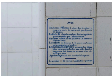
Carreau de faïence blanche portant un extrait du règlement intérieur, dans l'une des cabines munie d'une baignoire. Phot. Laurent Kruszyk IVR11_20179300012NUC4A
