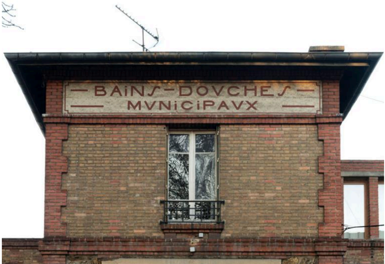
Détail de l'inscription "Bains-douches municipaux" en mosaïque de grès cérame, couronnant l'établissement.
