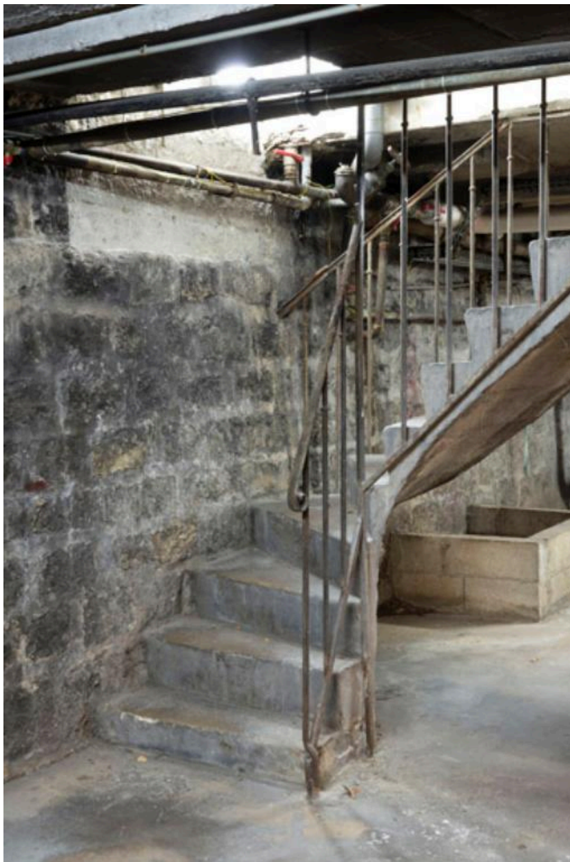
Détail de l'escalier conduisant à la chaufferie et à la salle des machines, situées au sous-sol.
