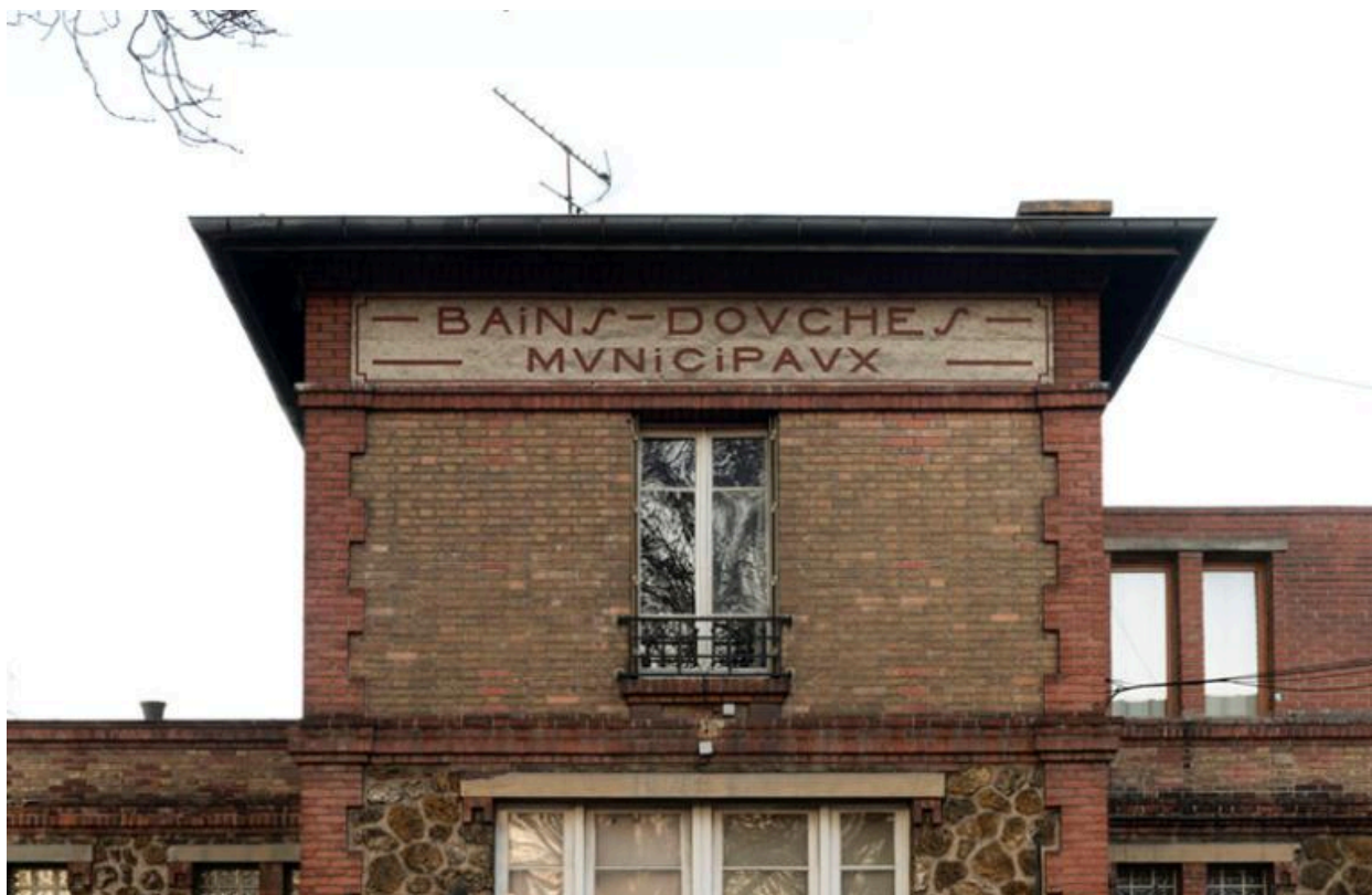
Détail de l'inscription "Bains-douches municipaux" et de la surélévation construite sur l'aile de bains-douches des femmes.
