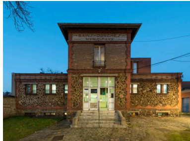
Vue générale des bains-douches municipaux de Pantin, à la tombée de la nuit. Phot. Laurent Kruszyk IVR11_20179300021NUC4A
