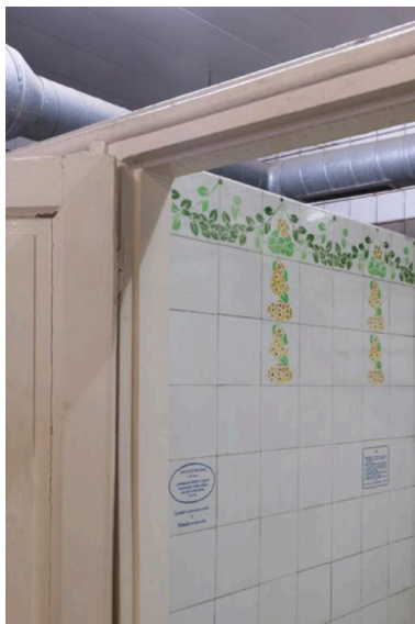
Détail des parois murales d'un déshabilleur côté hommes. Phot. Laurent Kruszyk IVR11_20179300003NUC4A
