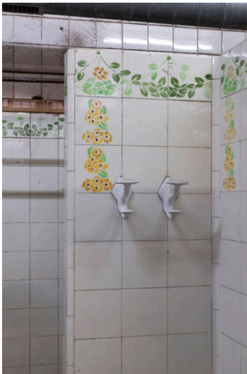
Les parois d'un déshabilleur, avec deux patères.
