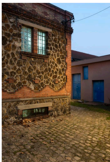
Détail de l'aile des femmes, avec l'appareil de pierre meulière. Phot. Laurent Kruszyk IVR11_20179300027NUC4A
