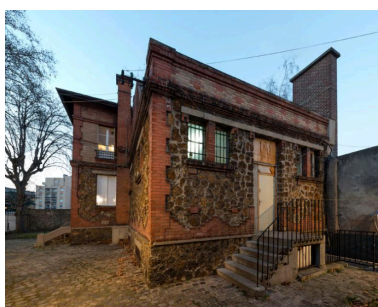
Vue générale de l'aile réservée aux cabines des femmes, à la tombée de la nuit. Phot. Laurent Kruszyk IVR11_20179300028NUC4A
