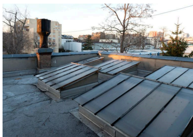
Détail du toit-terrasse de l'établissement et des lanternes éclairant le couloir distribuant les cabines.
