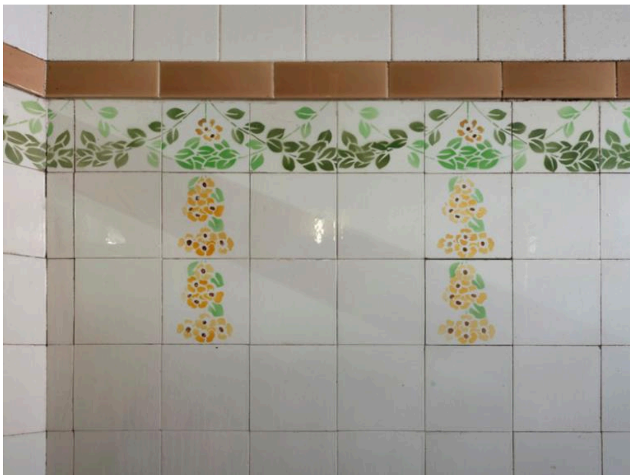
Les carreaux de faïence blanche à motifs floraux des murs d'un déshabilleur.
