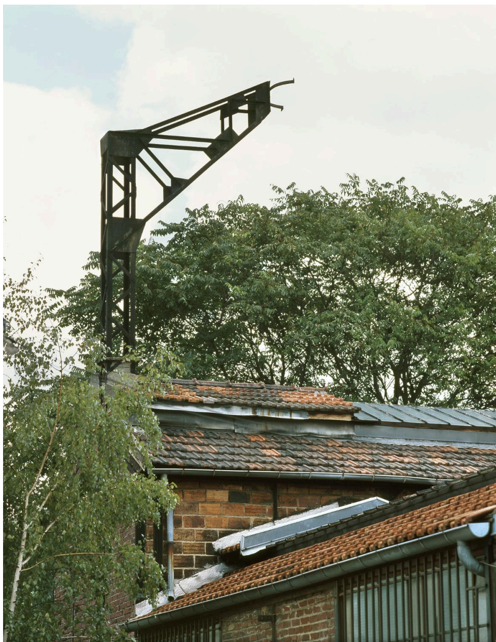
Vue de la potence de la halle de fonderie, initialement destinée à maintenir la cheminée des fours.
