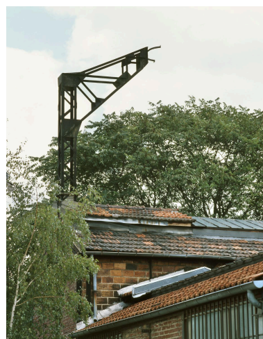
Vue de la potence de la halle de fonderie, initialement destinée à maintenir la cheminée des fours. Phot. Laurent Kruszyk IVR11_20049300447XA
