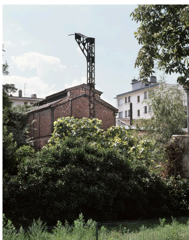
Vue, depuis le nord, du pignon de la halle de fonderie abritant les cubilots avant leur démantèlement vers 1970. La potence maintenait la cheminée des fours. Phot. Laurent Kruszyk IVR11_20049300446XA
