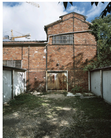
Pignon sud de la halle abritant initialement l'étuve, dans le prolongement de la halle de fonderie abritant les cubilots. Un appentis, aujourd'hui démoli, était adossé au pignon pour abriter diverses matières premières. Phot. Laurent Kruszyk IVR11_20049300450XA
