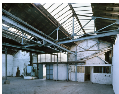
L'intérieur de l'usine, depuis l'emplacement des anciens fours. A droite, l'emplacement de l'atelier d'ébarbage ; au milieu, l'aire de coulée ; à gauche, le long du mur, étaient entreposés, par tailles, les châssis des moules. IVR11_20059300160VA
