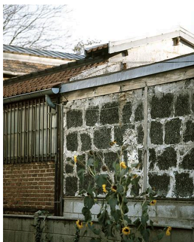
De droite à gauche : mur extérieur du magasin aux modèles, en parpaings de mâchefer (1er quart XXe siècle) ; mur de la halle de sablage, en brique pleine (1947-1949). IVR11_20059300126XA
