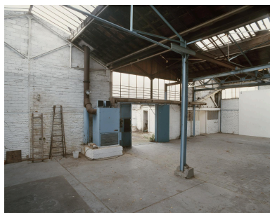
L'intérieur de l'usine, vu depuis l'ancien établi de préparation des moules. A gauche, à la place de l'actuelle chaudière, étaient installée la petite étuve pour les noyaux de moules, à proximité de l'établi de préparation des noyaux ; au milieu, l'aire de coulée ; à droite, l'emplacement de l'atelier d'ébarbage. IVR11_20059300162XA
