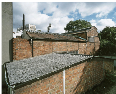
Vue du flanc sud de l'usine. Phot. Laurent Kruszyk IVR11_20049300448XA
