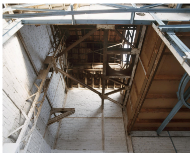
Support de l'ancienne cheminée métallique, au dessus de l'emplacement des fours. IVR11_20059300164XA
