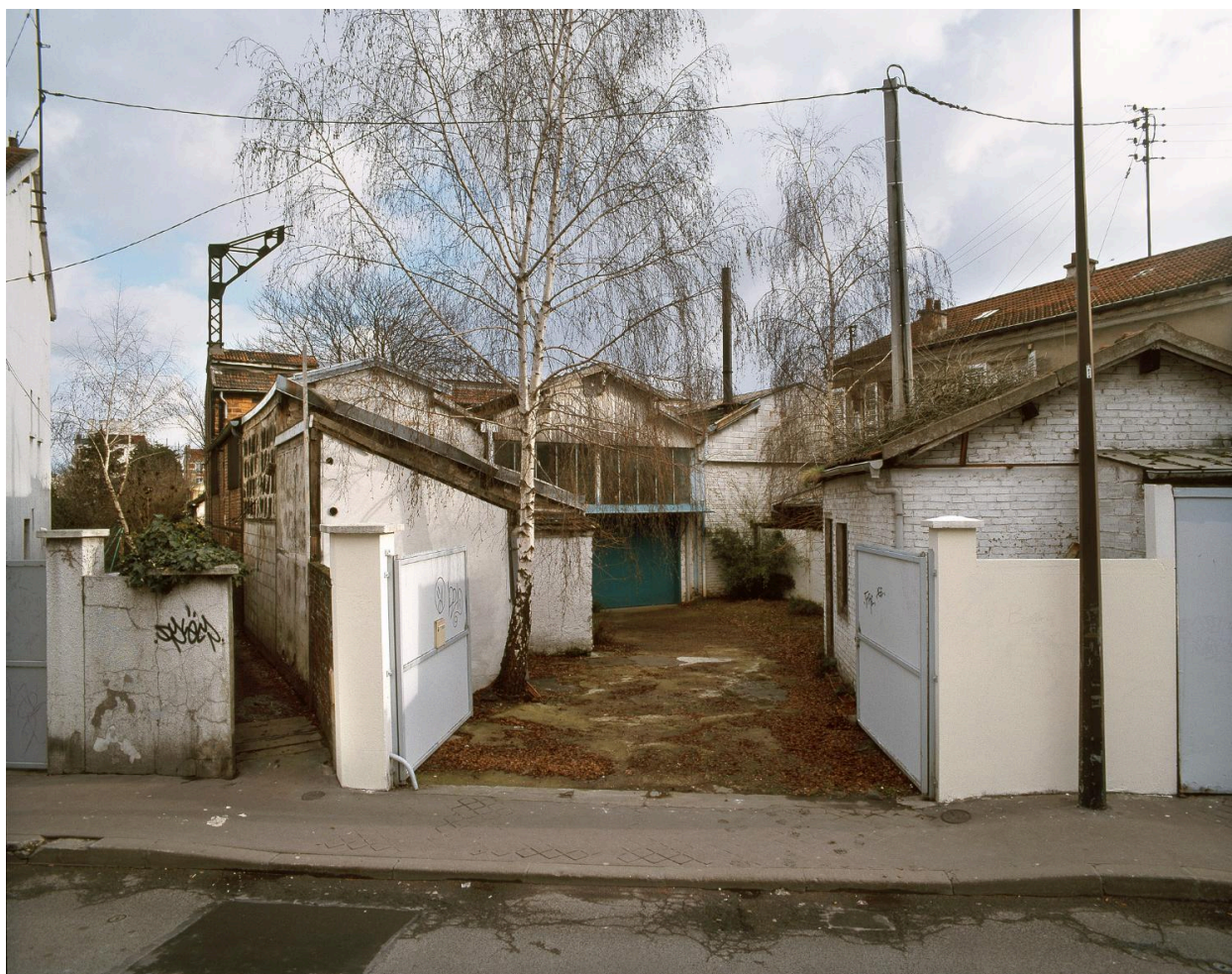
Vue générale depuis l'entrée.
