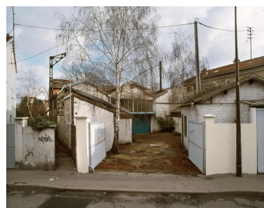
Vue générale depuis l'entrée. IVR11_20059300154XA
