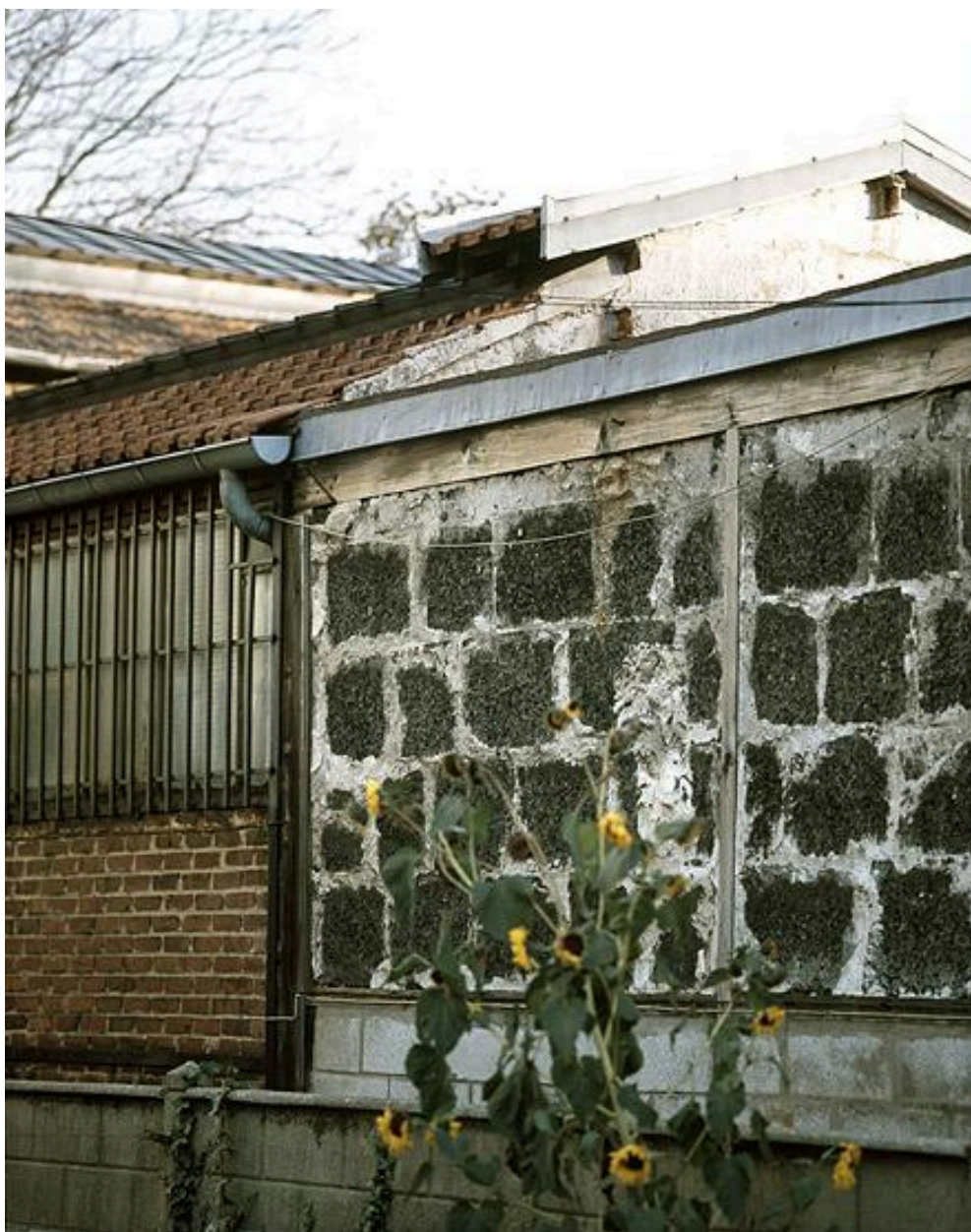
De droite à gauche : mur extérieur du magasin aux modèles, en parpaings de mâchefer (1er quart XXe siècle) ; mur de la halle de sablage, en brique pleine (1947-1949).
