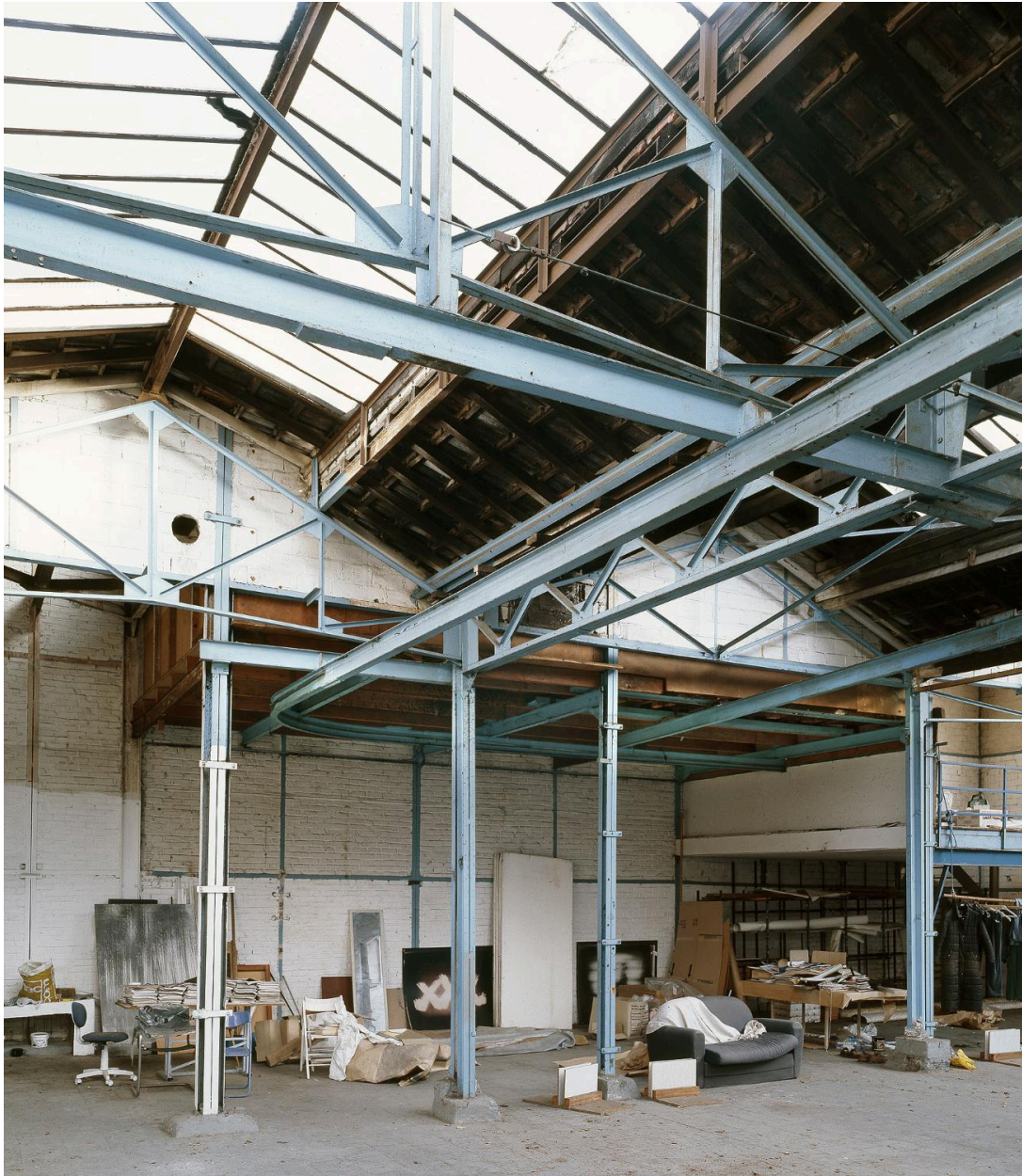
Vue du rail de soutien et de guidage des poches de 300 kg.
