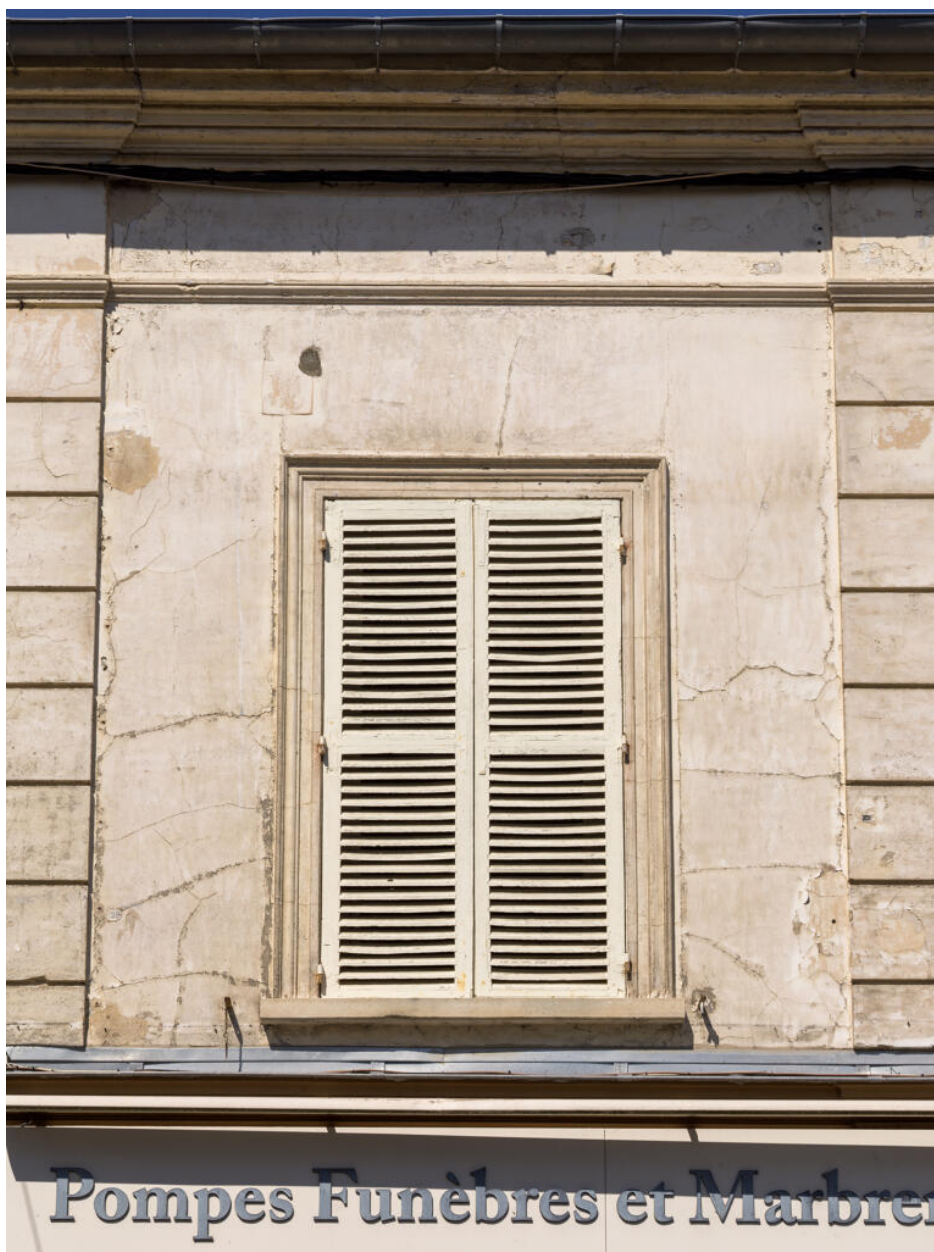
Détail d'une baie de l'étage.
