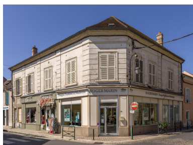
Vue générale depuis le nord-est. Phot. Asseline Stéphane IVR11_20259100502NUC4A
