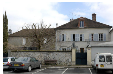
Vue générale de l'ancienne usine de serrurerie.
