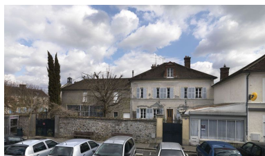
Vue générale de l'ancienne usine de serrurerie.
