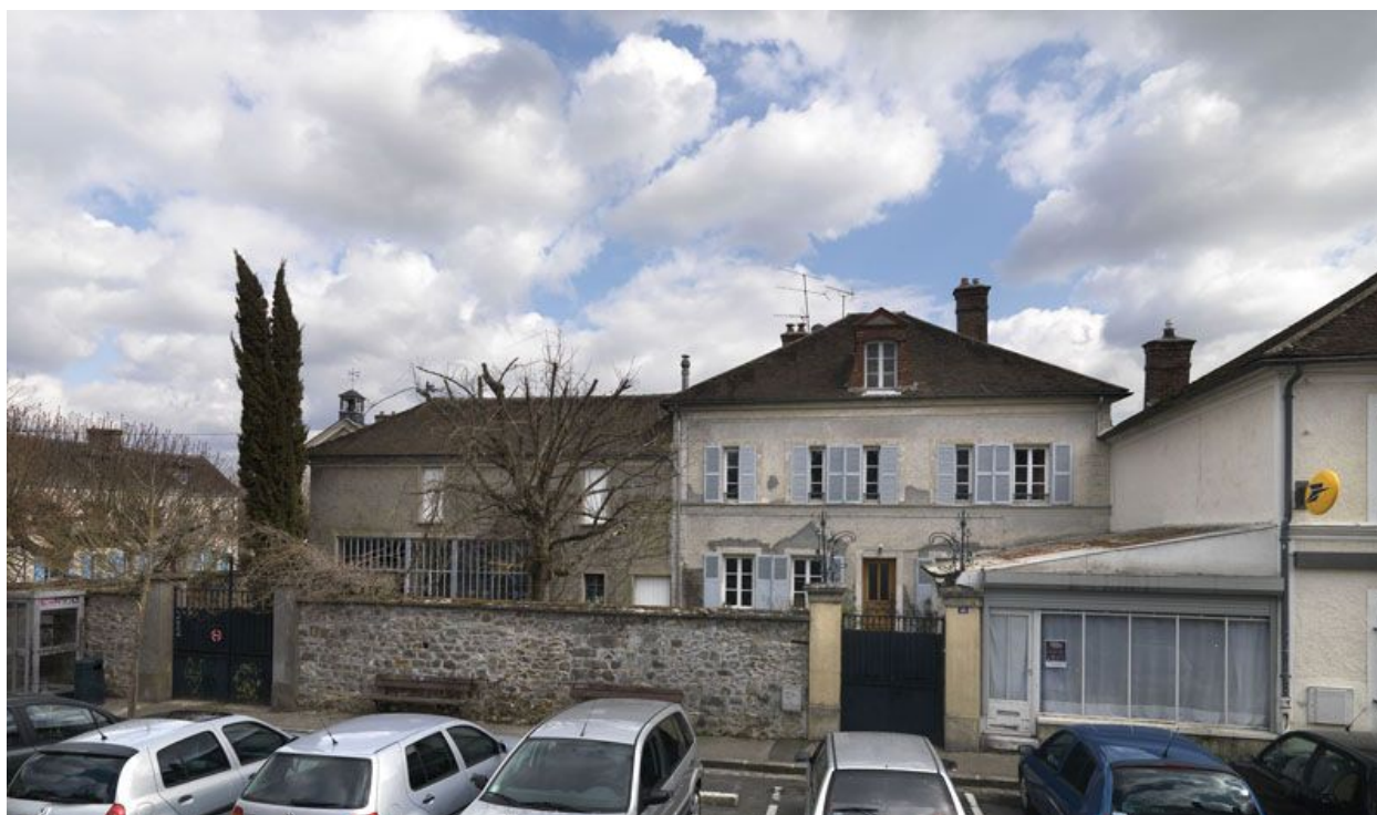
Vue générale de l'ancienne usine de serrurerie.
