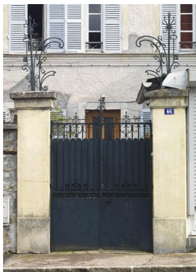
Ancienne serrurerie Oudiou, portail d'entrée. Phot. Chloé Bazaud IVR11_20097700052NUC4A
