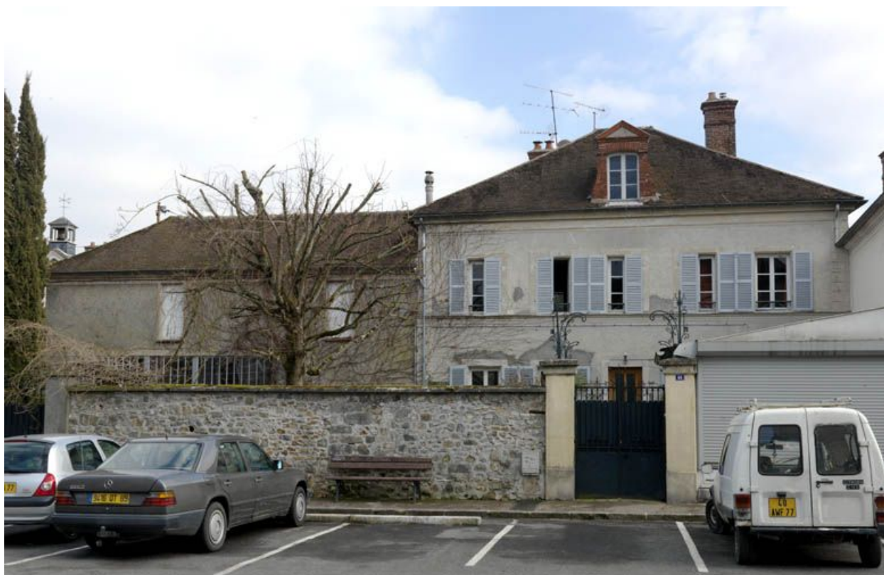
Vue générale de l'ancienne usine de serrurerie.
