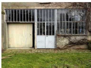
Ancien atelier du serrurier, verrière. Phot. Chloé Bazaud IVR11_20097700060NUC4A
