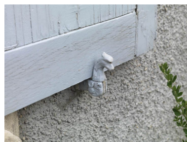
Maison d'habitation, arrêt de volet. Phot. Chloé Bazaud IVR11_20097700056NUC4A
