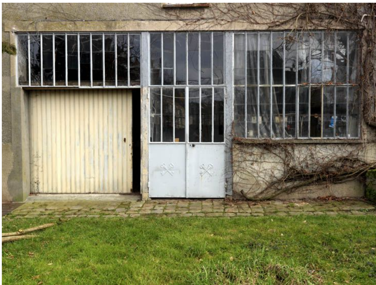
Ancien atelier du serrurier, verrière.
