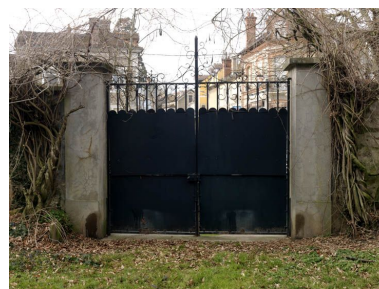
Ancienne serrurerie Oudiou, portail d'accès pour véhicules. Phot. Chloé Bazaud IVR11_20097700058NUC4A
