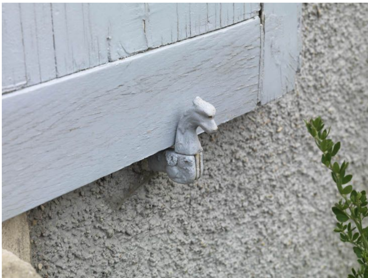
Maison d'habitation, arrêt de volet.
