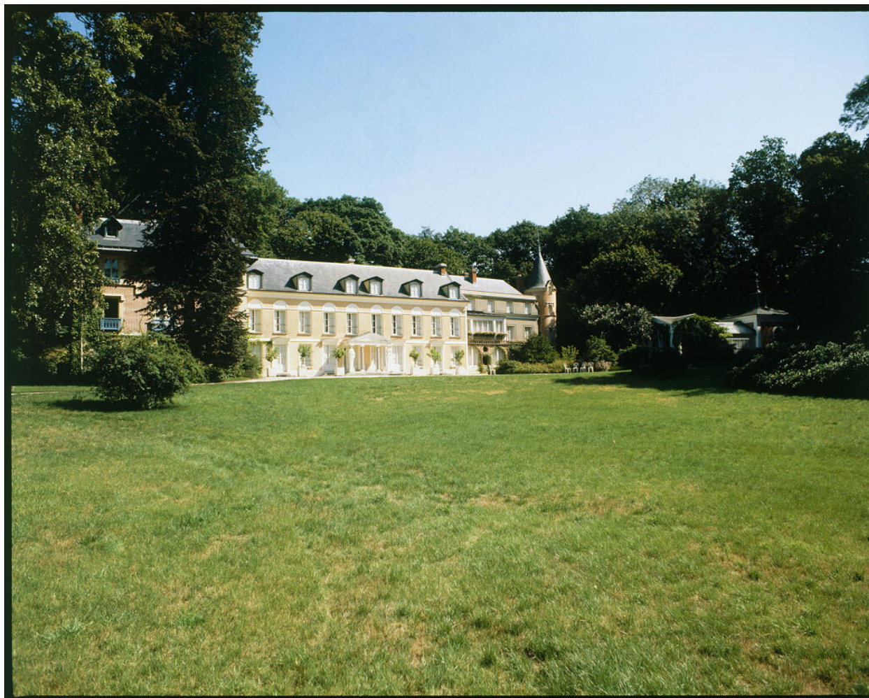
Façade sud. Vue d'ensemble depuis le parc.
