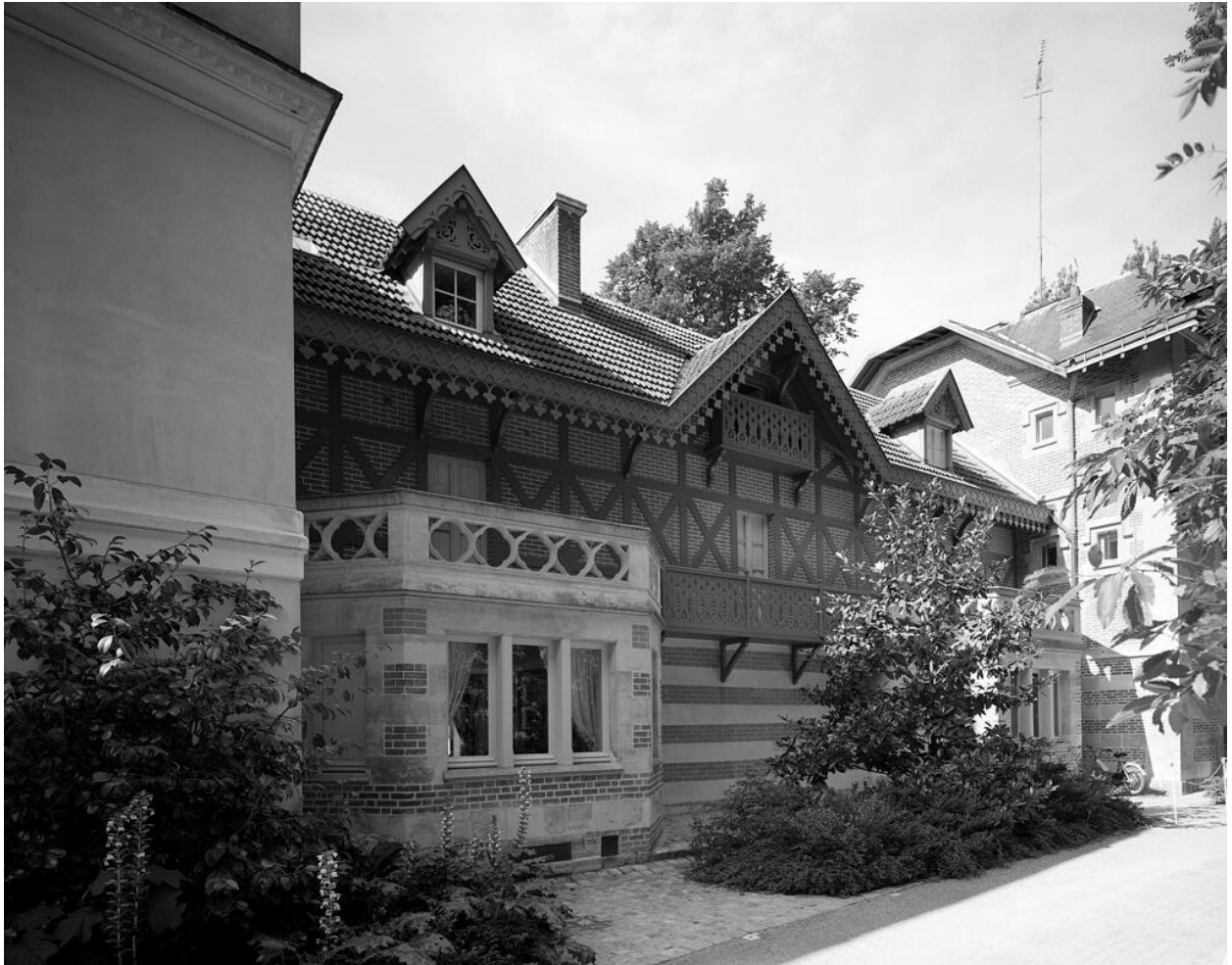
Au centre, la façade postérieure du corps de logis initial, agrémenté d'un bow window à terrasse et garde-corps sculpté. Sur la gauche on aperçoit l'arrière de l'aile est Montmorency. A droite, c'est l'aile La Rochefoucault.
