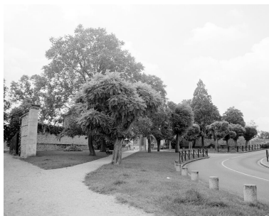
Mur en demi-lune de l'entrée du château donnant sur le village. Phot. Ayrault Philippe IVR11_19979100590X
