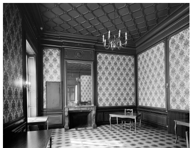
Une des pièces du rez-de-chaussée, vraisemblablement la salle à manger. Phot. Ayrault Philippe IVR11_19979100164V
