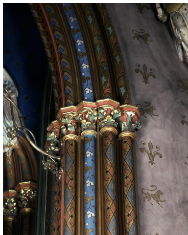
Chapelle néogothique : détail des chapiteaux de l'arc triomphal. Phot. Ayrault Philippe IVR11_19979100878XA
