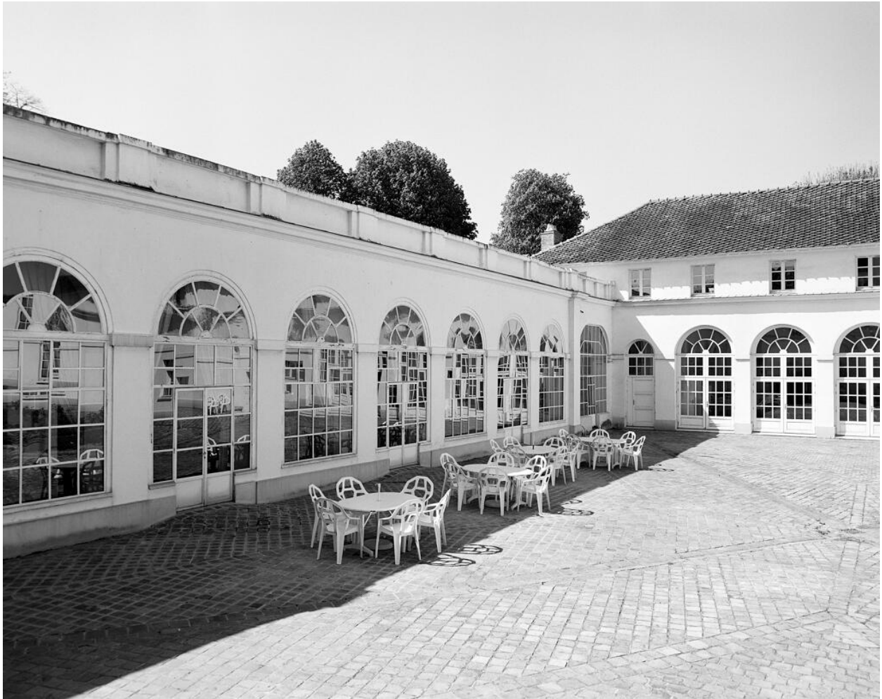
La façade de l'orangerie sur la cour des écuries.
