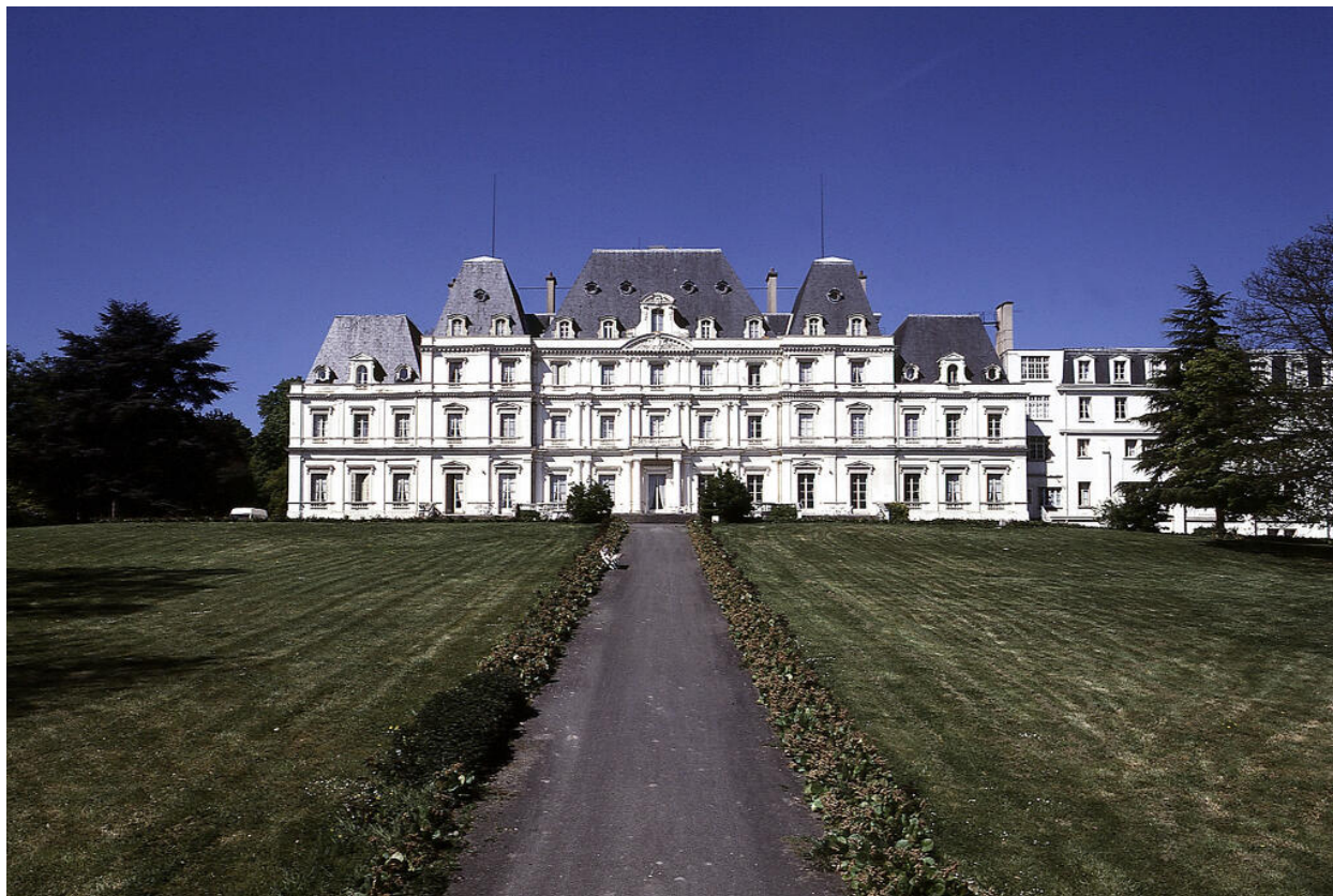
Façade sur le parc.
