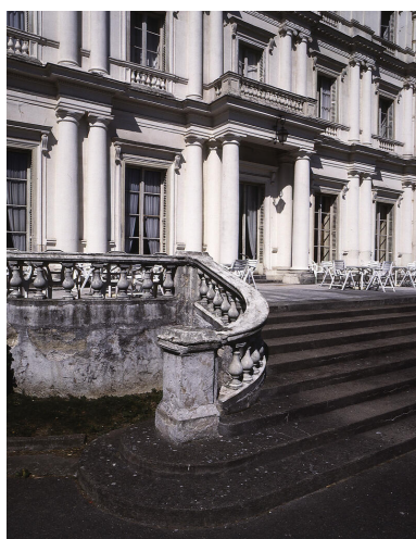
La façade sur le parc : détail du perron donnant accès au château. Phot. Ayrault Philippe IVR11_19979100167XA
