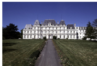
Façade sur le parc. Phot. Ayrault Philippe IVR11_19979100159XA
