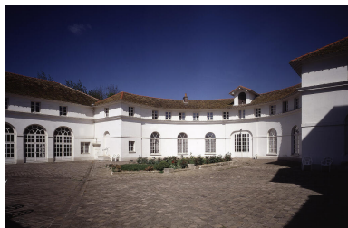
Vue des écuries sur la cour. Au centre, l'ancien bain des chevaux transformé en parterre. Phot. Ayrault Philippe IVR11_19979100183VA
