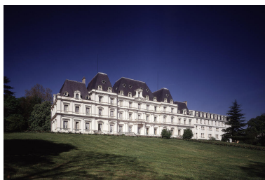
La façade sur le parc. A droite, la chapelle des Assomptionnistes convertie en chambres. Phot. Ayrault Philippe IVR11_19979100162VA
