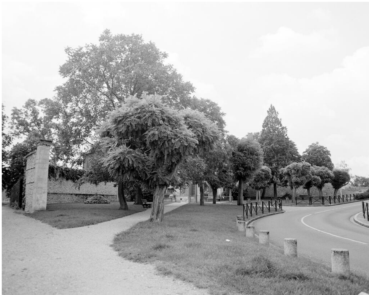
Mur en demi-lune de l'entrée du château donnant sur le village.
