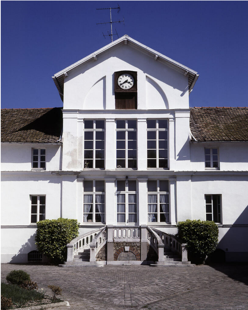
La partie centrale de la façade des communs.
