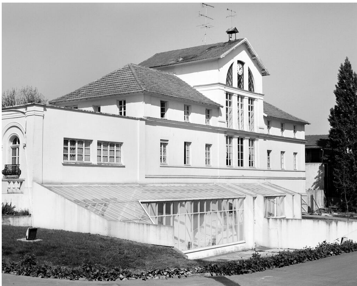
Les communs : vue d'ensemble du bâtiment contigu à l'orangerie.
