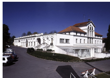
Vue d'ensemble des communs de style néoclassique. Phot. Ayrault Philippe IVR11_19979100170XA
