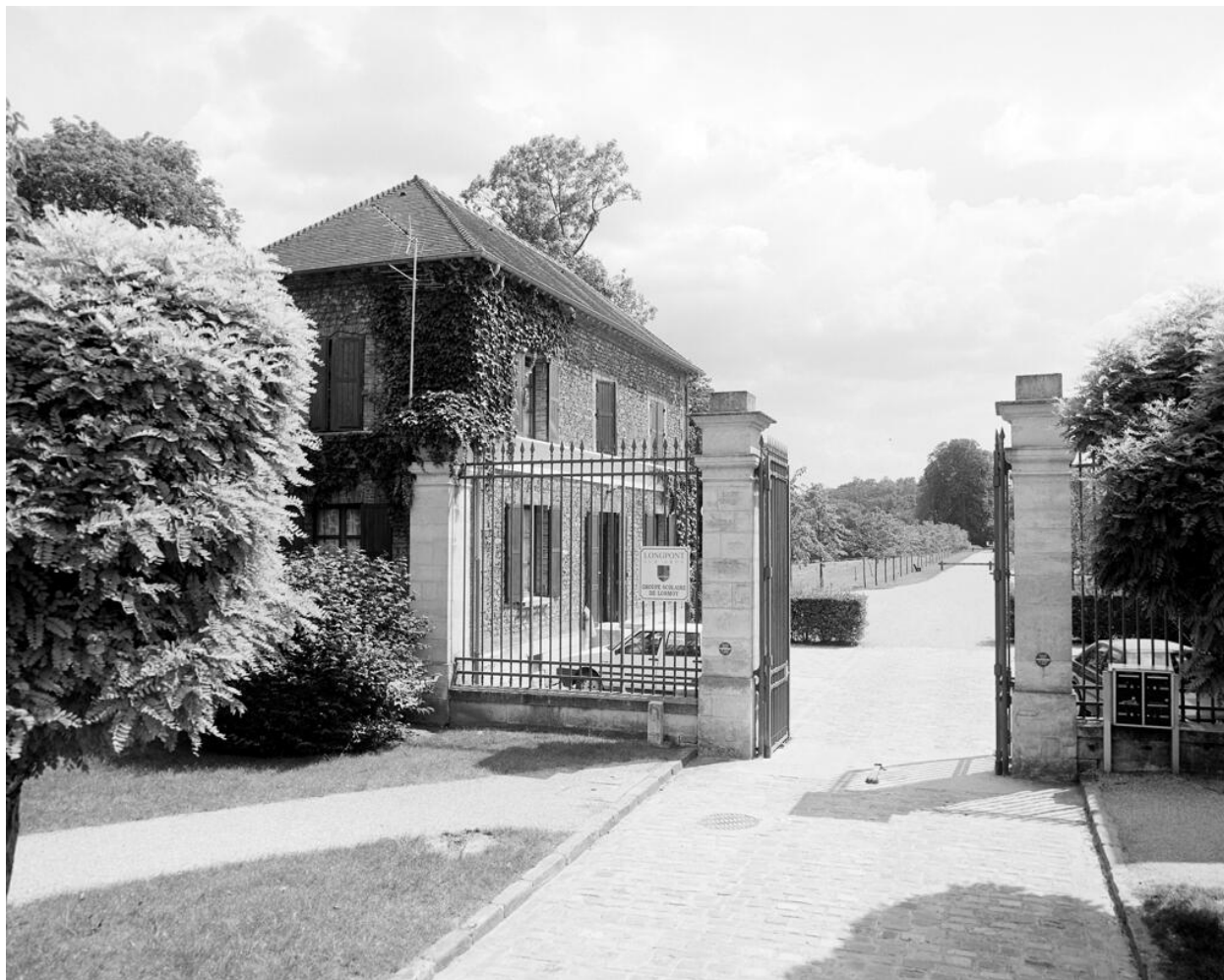
Le portail de l'entrée du château sur la rue de Lormoy et l'un des deux pavillons qui le flanquent.
