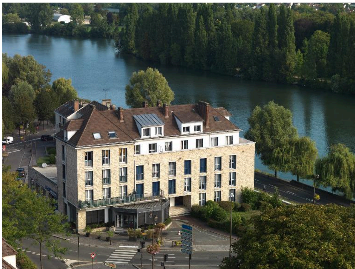
Vue de l'immeuble de l'îlot B, le dernier reconstruit.
