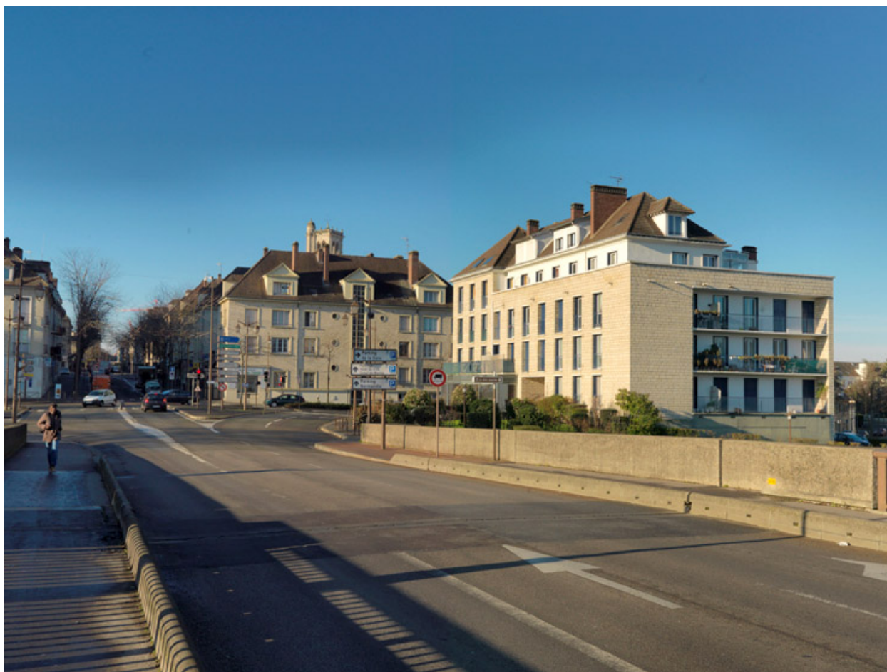
La façade de l'immeuble de l'îlot B vue depuis le pont.
