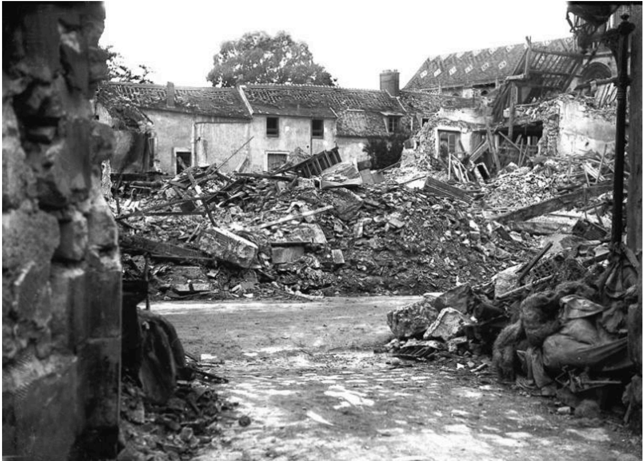
Destructions près du pont. (Fonds Bertin).
