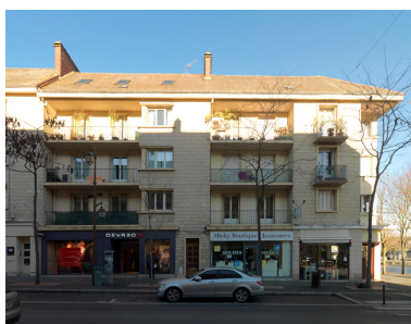
Façade de l'îlot G le long de la Rue Nationale. les façades sont animées de balcons et de balcons en loggia. Les toits sont peu pentus. Phot. Laurent Kruszyk IVR11_20167800068NUC4A
