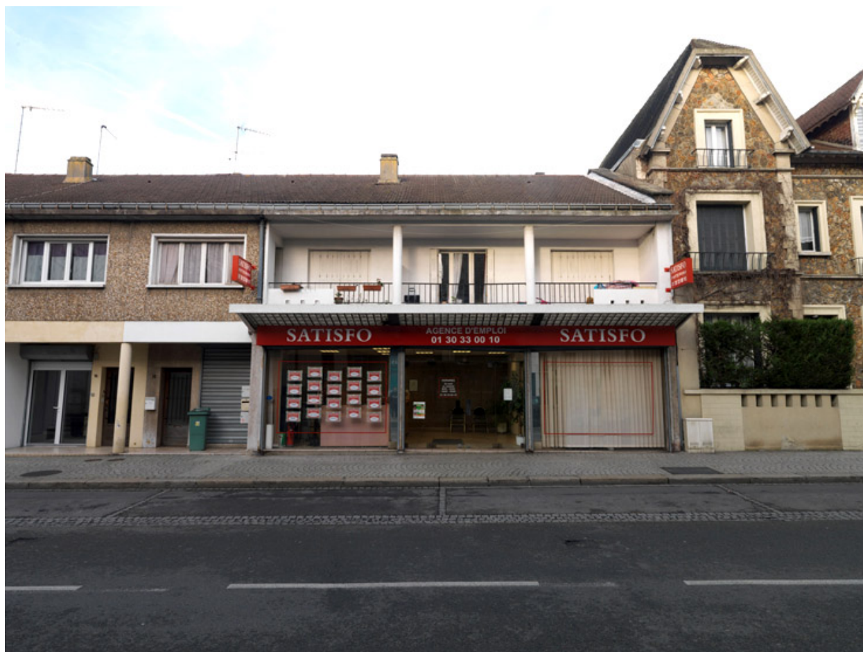
Maisons rue d'Alsace, en face du marché.
