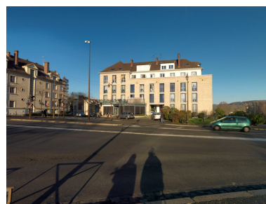
La façade principale de l'îlot B, 2, rue Conrad Killian. Phot. Laurent Kruszyk IVR11_20167800050NUC4A
