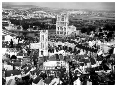
Vue du quartier autour de Saint- Maclou. (Cliché Henrard). Phot. Roger Henrard IVR11_19857800167N
