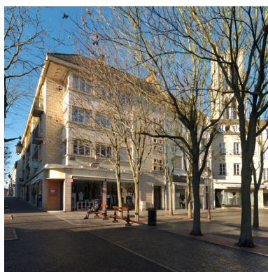
L'îlot G est situé dans le prolongement des bâtiments plus anciens de la place Saint-Maclou. Phot. Laurent Kruszyk IVR11_20167800059NUC4A
