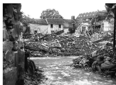
Destructions près du pont. (Fonds Bertin).
