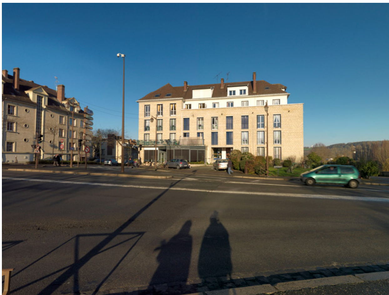
La façade principale de l'îlot B, 2, rue Conrad Killian.
