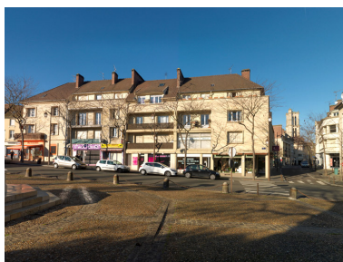
Façade sur la rue Thiers des immeubles de l'îlot E. Ils sont animés par des balcons en loggia. Phot. Laurent Kruszyk IVR11_20167800037NUC4A
