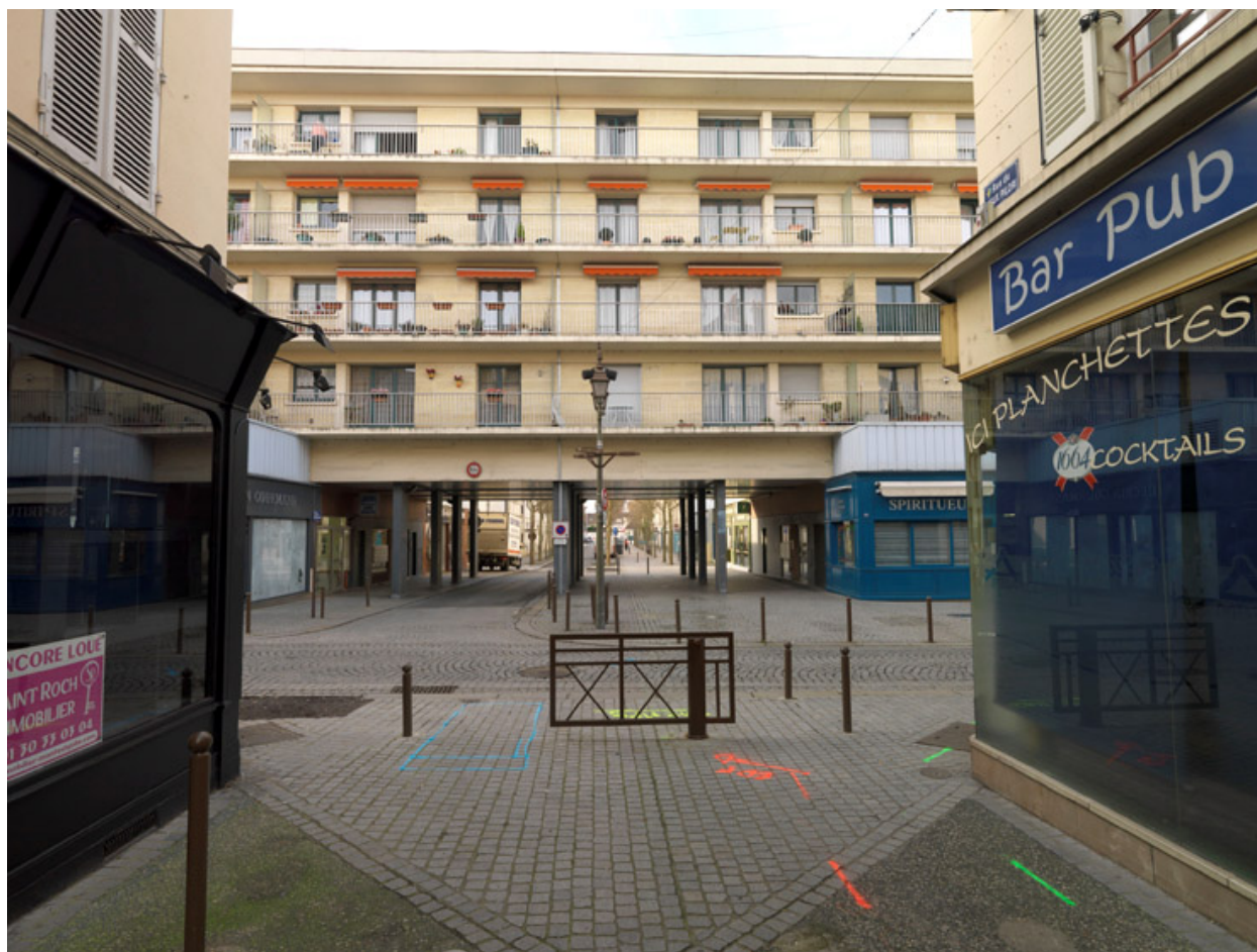
La rue du Vieux Piloni passant sous l'immeuble de la rue de Chanzy.
