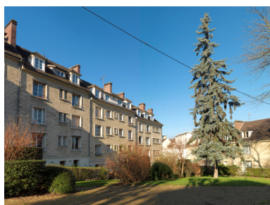
La façade sur le square de la paix des immeubles de l'îlot A, 1-11 rue Famille Salomon. Phot. Laurent Kruszyk IVR11_20167800090NUC4A
