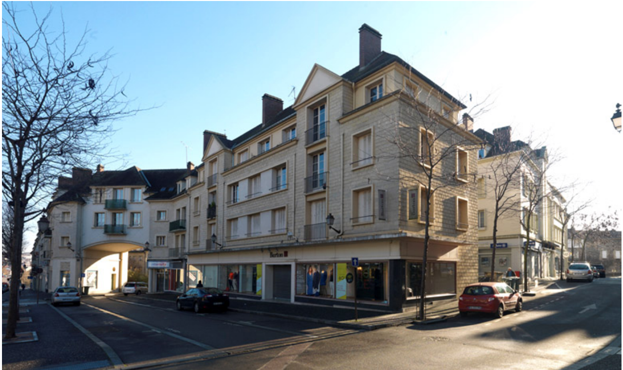
Immeuble de l'îlot C donnant sur la rue Nationale.
