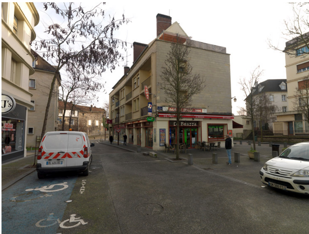
La façade sur la rue Marie et Robert Dubois de l'îlot E. On notera à nouveau les nombreux balcons en loggia.
