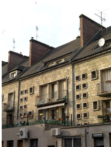
Les immeubles de l'îlot F sur la rue Nationale ont un façade arrière avec balcons. Les cages d'escaliers sont signalées par les petites ouvertures carrées. Phot. Laurent Kruszyk IVR11_20167800106NUC4A
