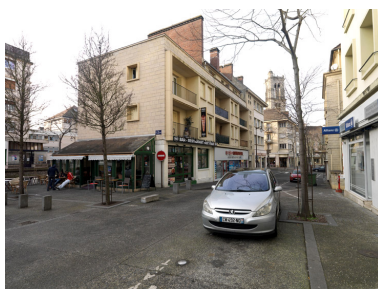
La façade de l'îlot F sur la rue Marie et Robert Dubois. Les deux premiers immeubles ont eux aussi des balcons en loggia. Phot. Laurent Kruszyk IVR11_20167800108NUC4A
