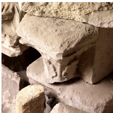
Pièce A 5 : bloc comprenant un chapiteau à feuilles d'acanthé stylisées. Le tailloir est abîmé. Cette pièce provient de l'arcature basse du choeur de la fin du 12e siècle. Phot. Stéphane Asseline IVR11_20087700686NUC4A
