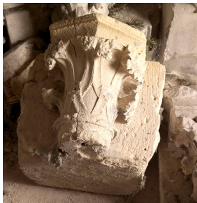
Pièce C 1 : chapiteau à deux rangs de feuillage et tailloir hexagonal. Cette pièce provient de la 2e chapelle rayonnante côté sud, elle ornait une colonnette médiane de l'arcature. 1er tiers 14e siècle. Phot. Stéphane Asseline IVR11_20087700674NUC4A
