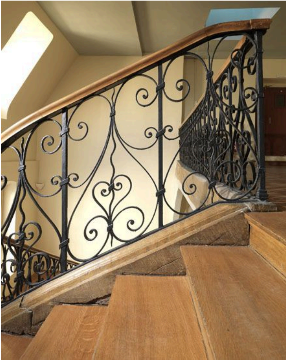
Détail des balustres.
