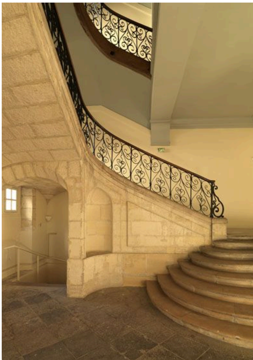
La rampe de la première volée : balustres compartimentés.
