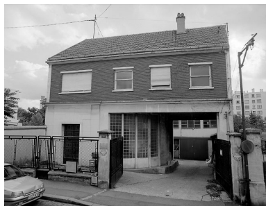
vue de la façade.
