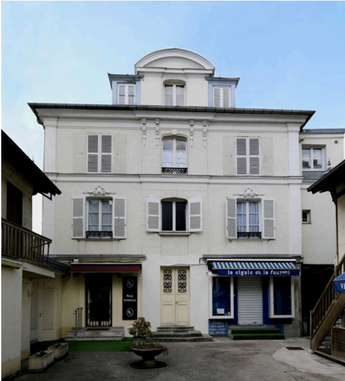
Vue d'ensemble de la façade depuis la cour.
