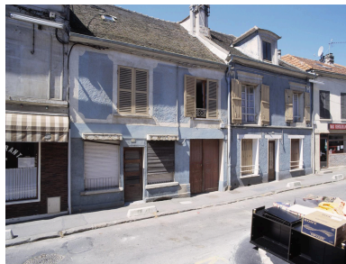
Vue d'ensemble. Phot. Philippe Ayrault IVR11_20049100429XA
