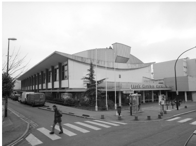
Façade principale : vue d'ensemble. Phot. Jean-Bernard Vialles IVR11_20039301393X
