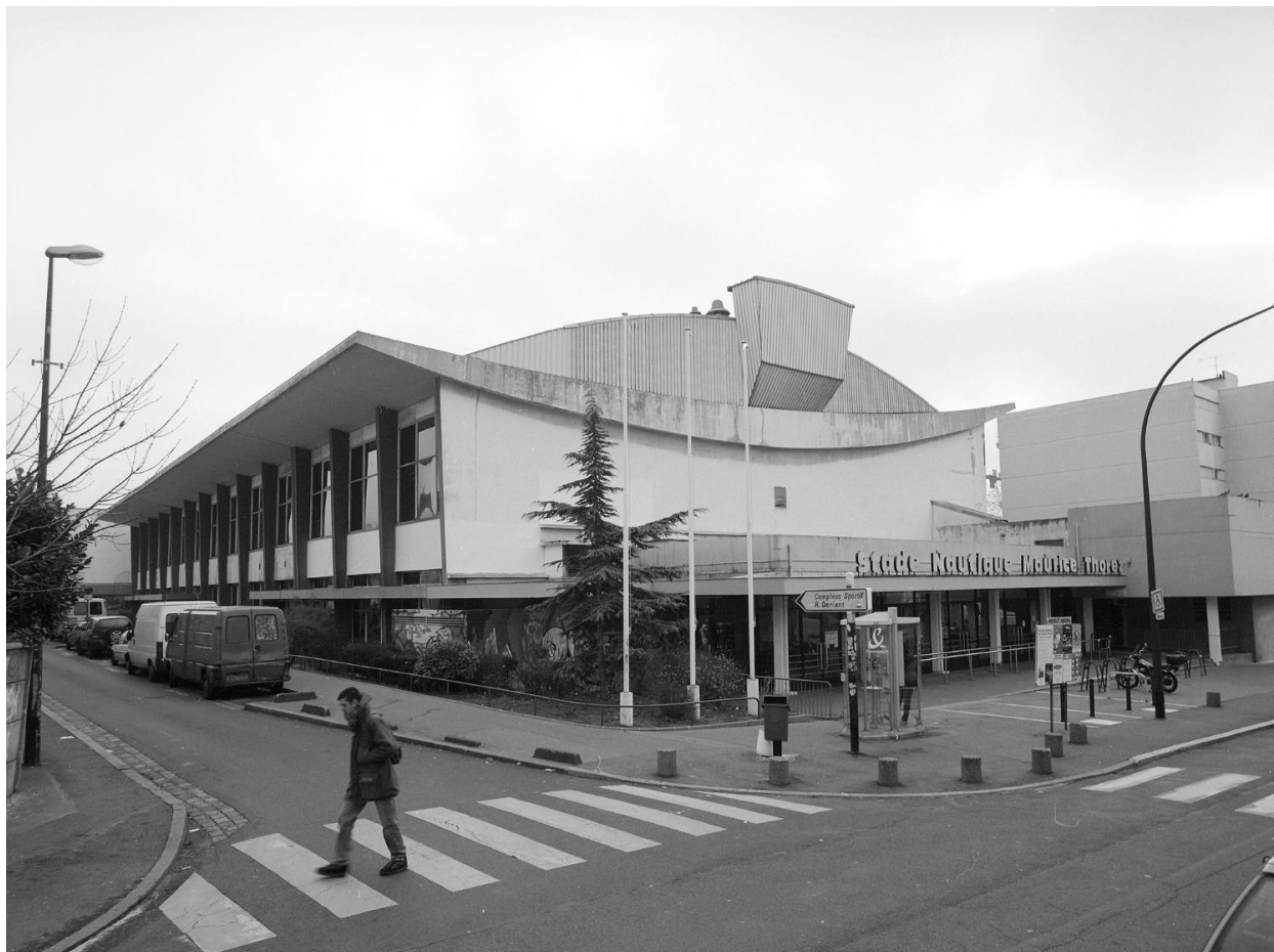
Façade principale : vue d'ensemble.
