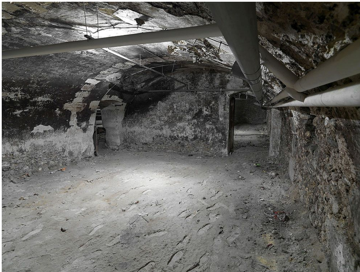
La cave régnant sous l'ancien cloître du couvent des Ursulines (aile orientale, le long de la rue des Ursulines) : vue d'une des salles voûtées en berceau. L'accès à gauche donne sur le couloir qui dessert l'ensemble de ces caves.
