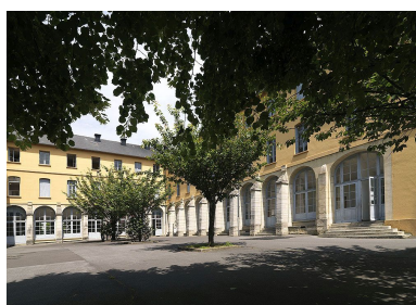
L'ancien cloître du couvent des Ursulines, vu du sud-ouest. Phot. Jean-Bernard Vialles IVR11_20137700120NUC4A
