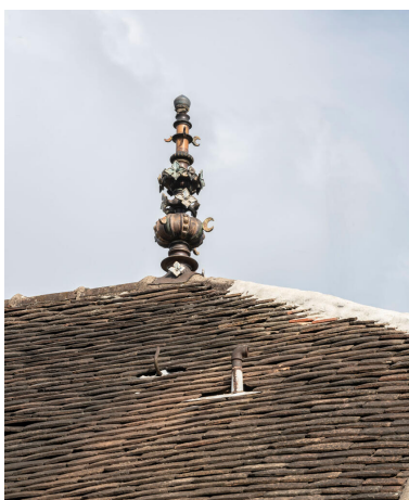
Epi de faitage émaillé Phot. Kruszyk Laurent IVR11_20249200552NUC4A
