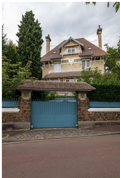
Villa en brique sur le coteau de Saint-Cloud Phot. Kruszyk Laurent IVR11_20249200492NUC4A
