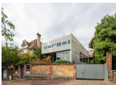
Villa dall'Ava, construite par l'architecte Rem Koolhaas entre 1989 et 1991 : façade orientale Phot. Kruszyk Laurent IVR11_20249200490NUC4A
