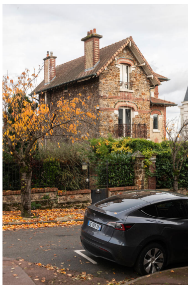
Villa en meulière. Architecte : Lucien Larlat. Phot. Kruszyk Laurent IVR11_20249200974NUC4A
