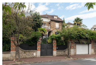
Villa sur le coteau de Saint-Cloud Phot. Kruszyk Laurent IVR11_20249200470NUC4A
