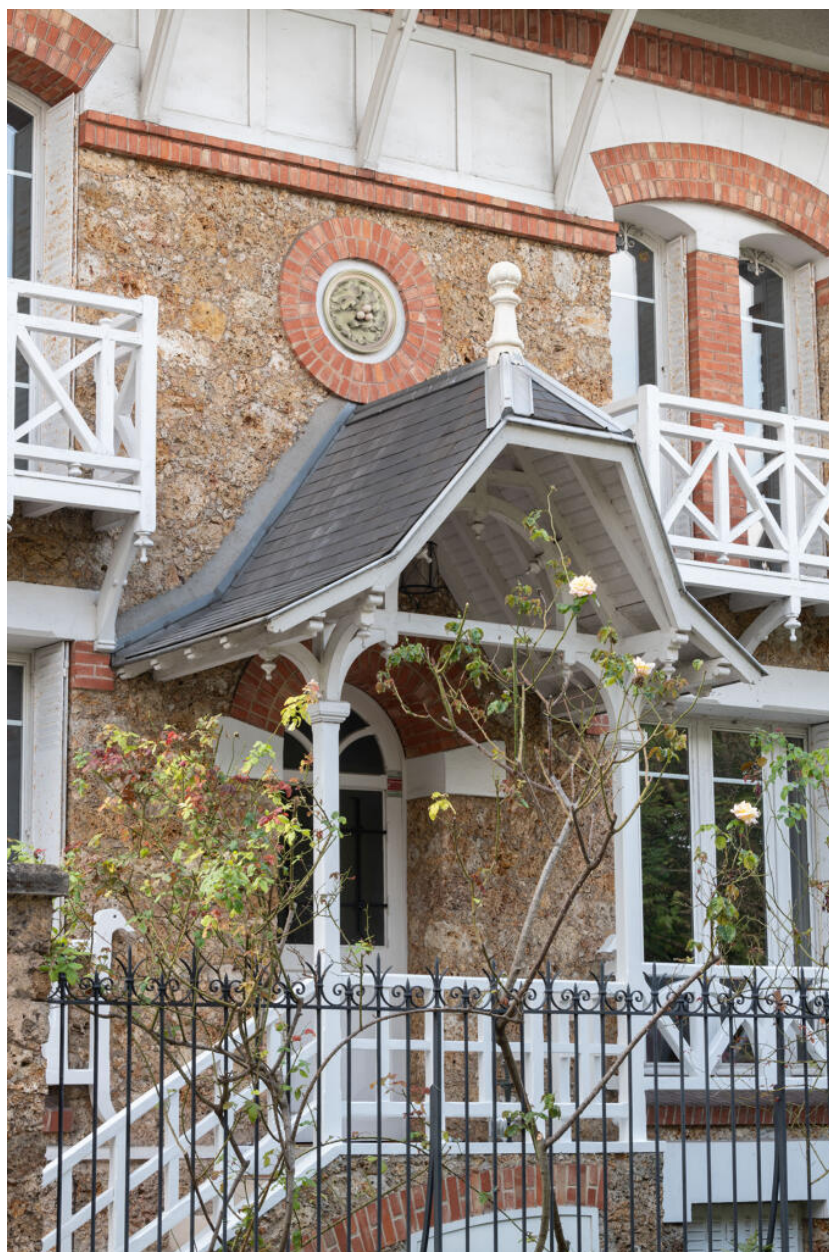
Auvent charpenté d'un pavillon du coteau de Saint-Cloud
