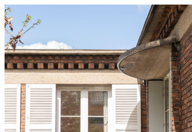
Détail de la marquise au-dessus de l'entrée et de la corniche formée par le jeu des briques. IVR11_20249200008NUC4A
