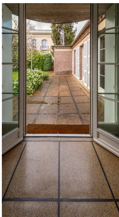
Vue depuis l'entrée, la terrasse qui longe les portes-fenêtres des chambres d'enfant. IVR11_20249200010NUC4A
