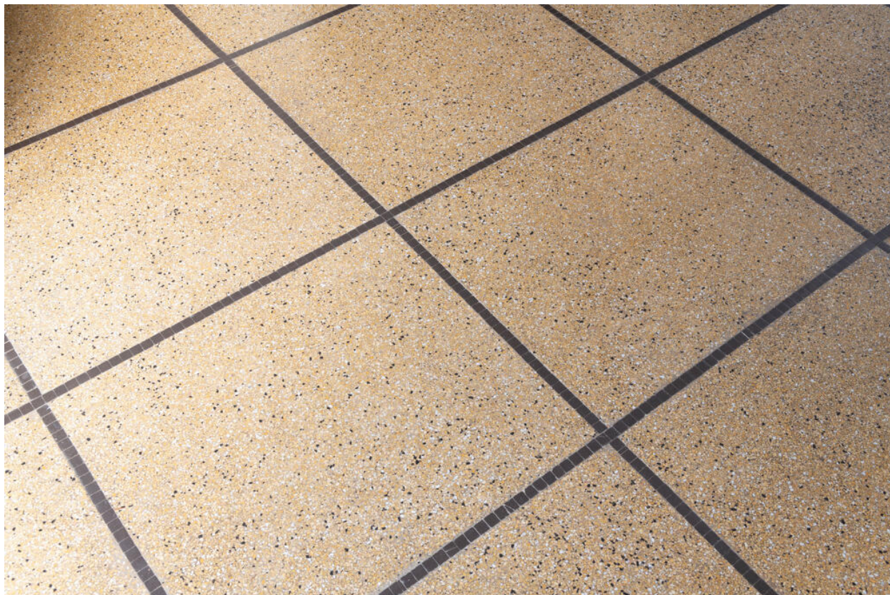
Détail du sol d'origine, constitué de dalles carrées de terrazzo, bordées de tesselles de pierre noire (basalte ?)
