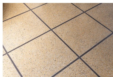
Détail du sol d'origine, constitué de dalles carrées de terrazzo, bordées de tesselles de pierre noire (basalte ?) IVR11_20249200011NUC4A
