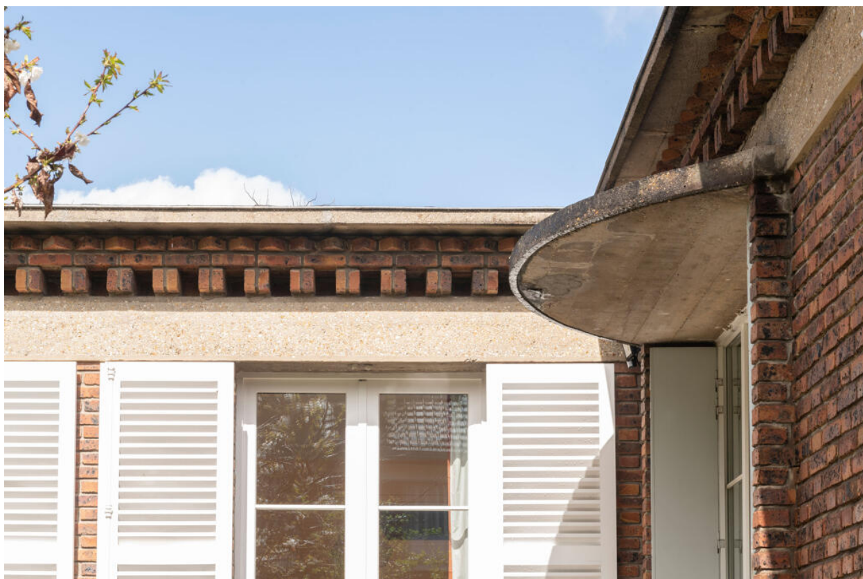
Détail de la marquise au-dessus de l'entrée et de la corniche formée par le jeu des briques.
