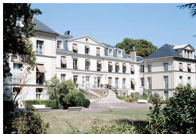
Vue rapprochée depuis le jardin. Phot. Stéphane Asseline IVR11_20049400450XA
