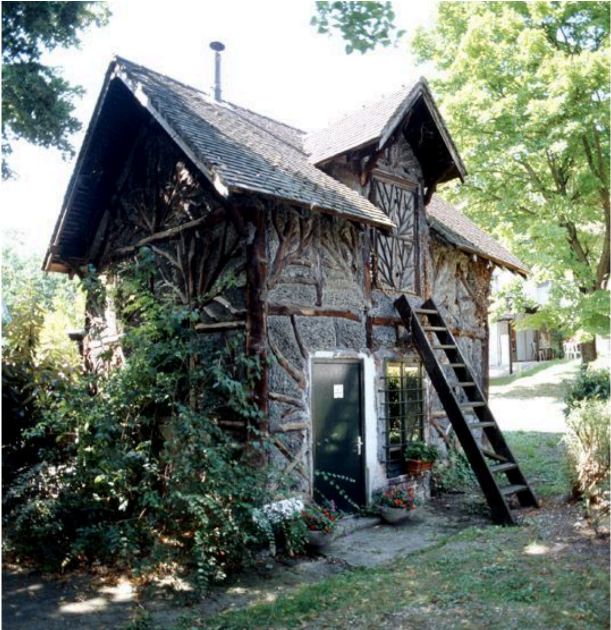
Fabrique de jardin dans le parc en pan de bois rustique.
