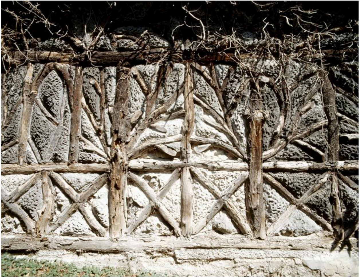
Détail du pan de bois de la fabrique de jardin dans le parc.
