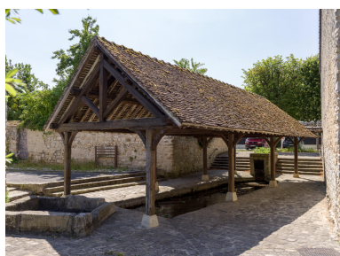
Vue générale depuis l'angle nord-est. Phot. Asseline Stéphane IVR11_20259100537NUC4A
