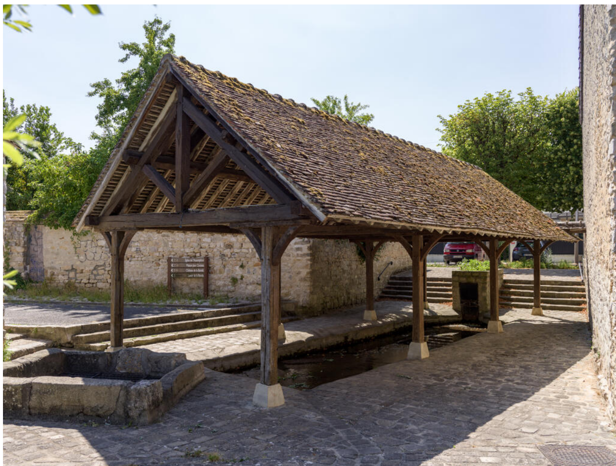
Vue générale depuis l'angle nord-est.
