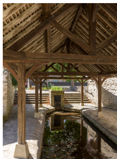
Vue de la charpente traditionnelle depuis l'est. Phot. Asseline Stéphane IVR11_20259100538NUC4A
