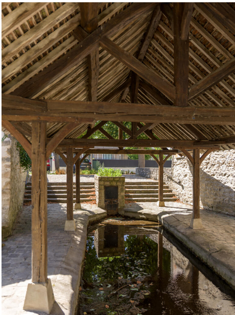
Vue de la charpente traditionnelle depuis l'est.
