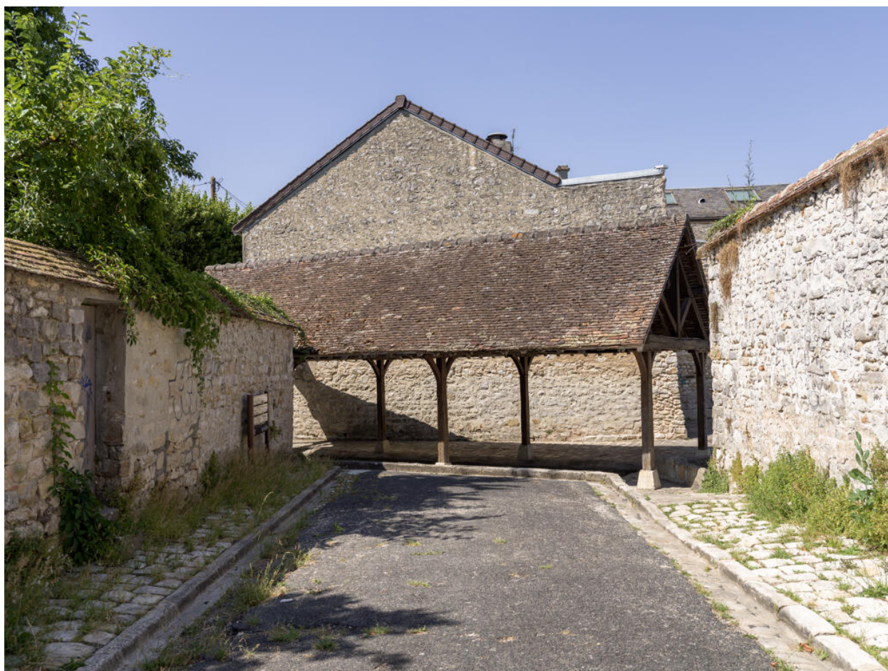
Vue de situation depuis la rue Notre-Dame (depuis le sud).
