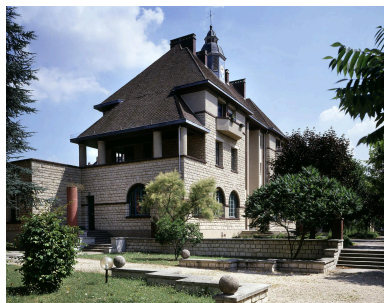
Vue de trois quarts de l'ancienne école maternelle. Phot. Stéphane Asseline
