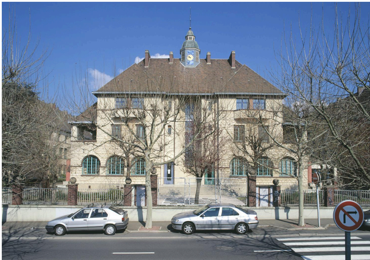
Vue de la façade sur l'avenue Foch de l'ancienne école maternelle.
