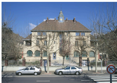
Vue de la façade sur l'avenue Foch de l'ancienne école maternelle. Phot. Stéphane Asseline IVR11_20047800313XA
