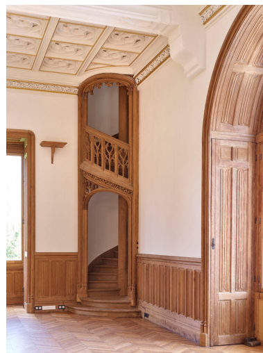
Pièce principale de la maison, le hall à l'anglaise, a reçu un décor néo-gothique : lambris à plis de serviette et gâbles à mouchettes sur l'escalier et les caissons du plafond. Phot. Asseline Stéphane IVR11_20247800160NUC4A
