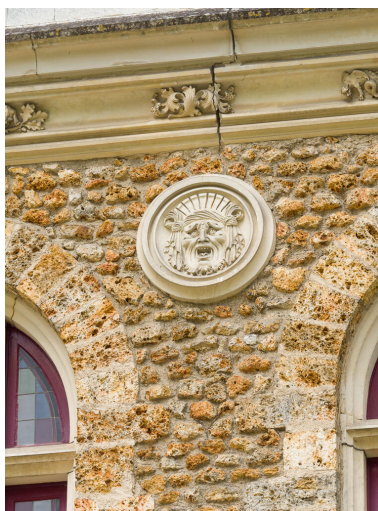
Mascaron sur la façade antérieure et détail de la corniche à chou frisé. Phot. Asseline Stéphane IVR11_20247800174NUC4A
