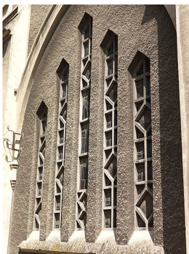
Baie côté sud de la nouvelle chapelle.
