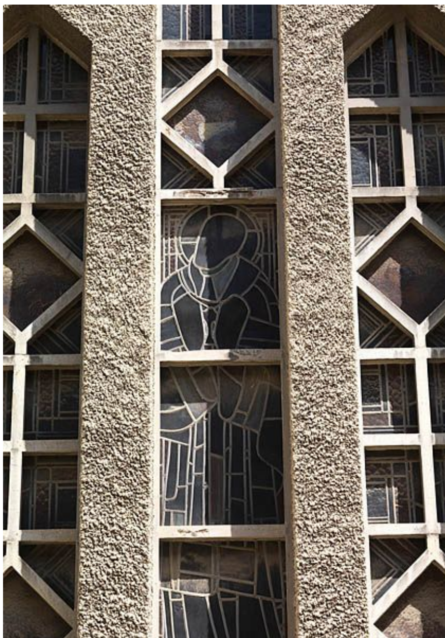
Détail de la mise en oeuvre et du vitrail d'une baie côté sud de la nouvelle chapelle.
