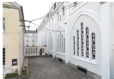
Couloir reliant l'ancienne chapelle à la nouvelle. Phot. Stéphane Asseline IVR11_20097700801NUC4A
