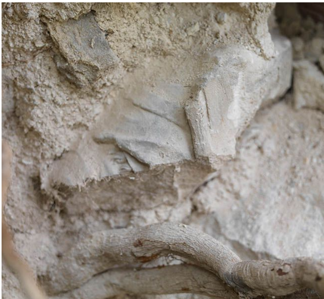
Détail du remploi de sculpture dans la mise en oeuvre du mur perpendiculaire au mur de clôture.
