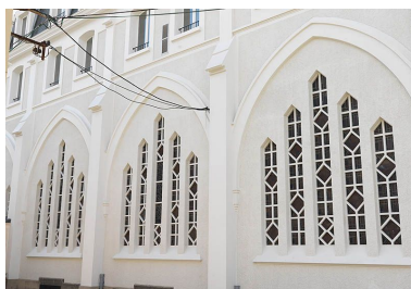
Vue latérale de la chapelle de 1936. Phot. Stéphane Asseline IVR11_20097700803NUC4A
