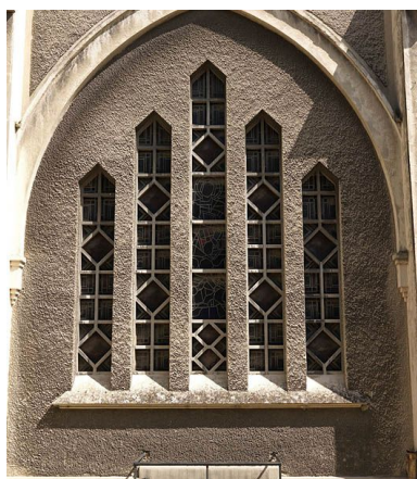
Baie côté sud de la nouvelle chapelle.
