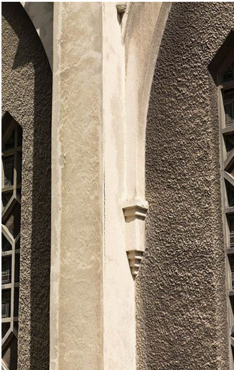
Détail de la mise en oeuvre d'une baie côté sud de la nouvelle chapelle.
