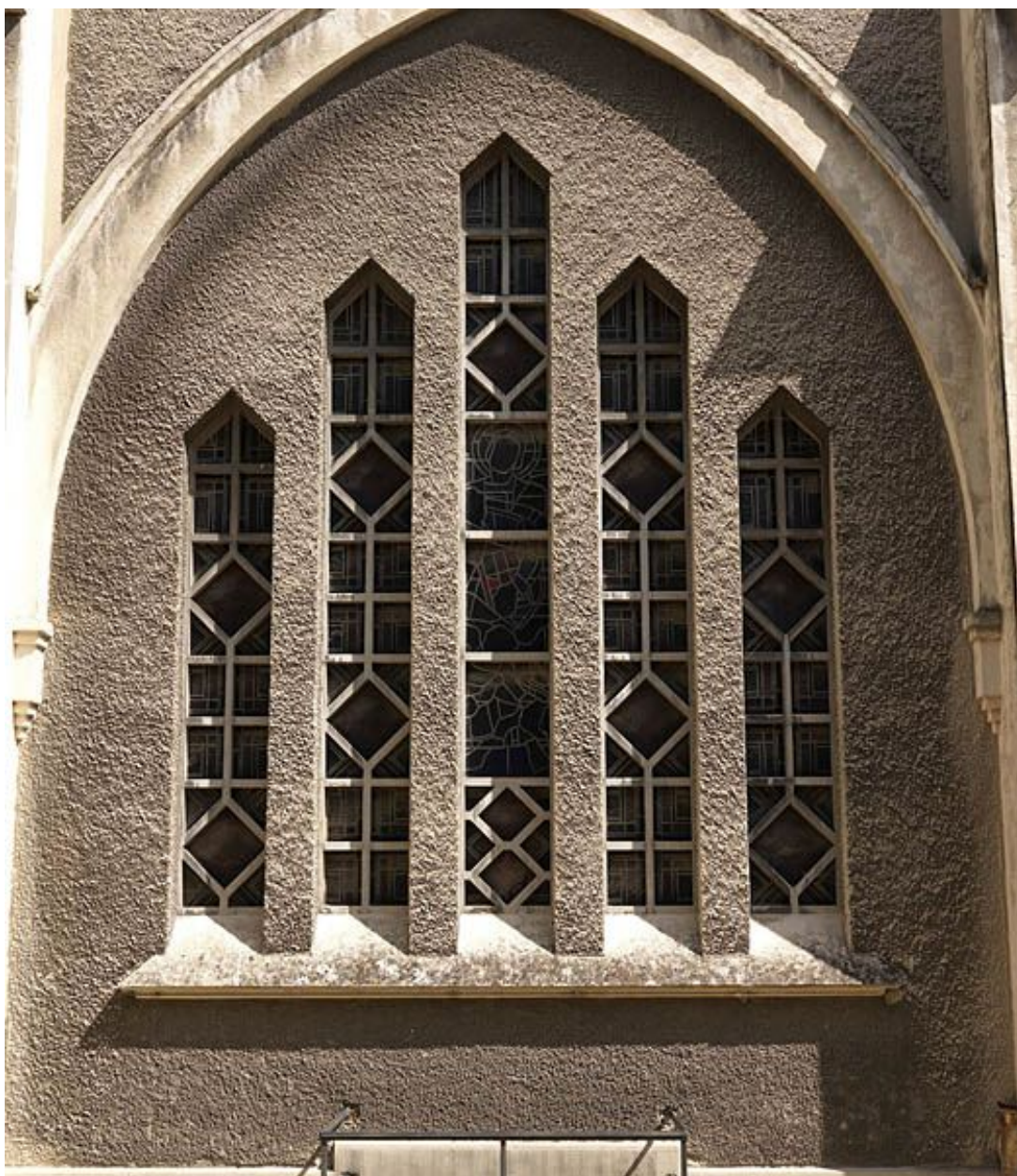
Baie côté sud de la nouvelle chapelle.
