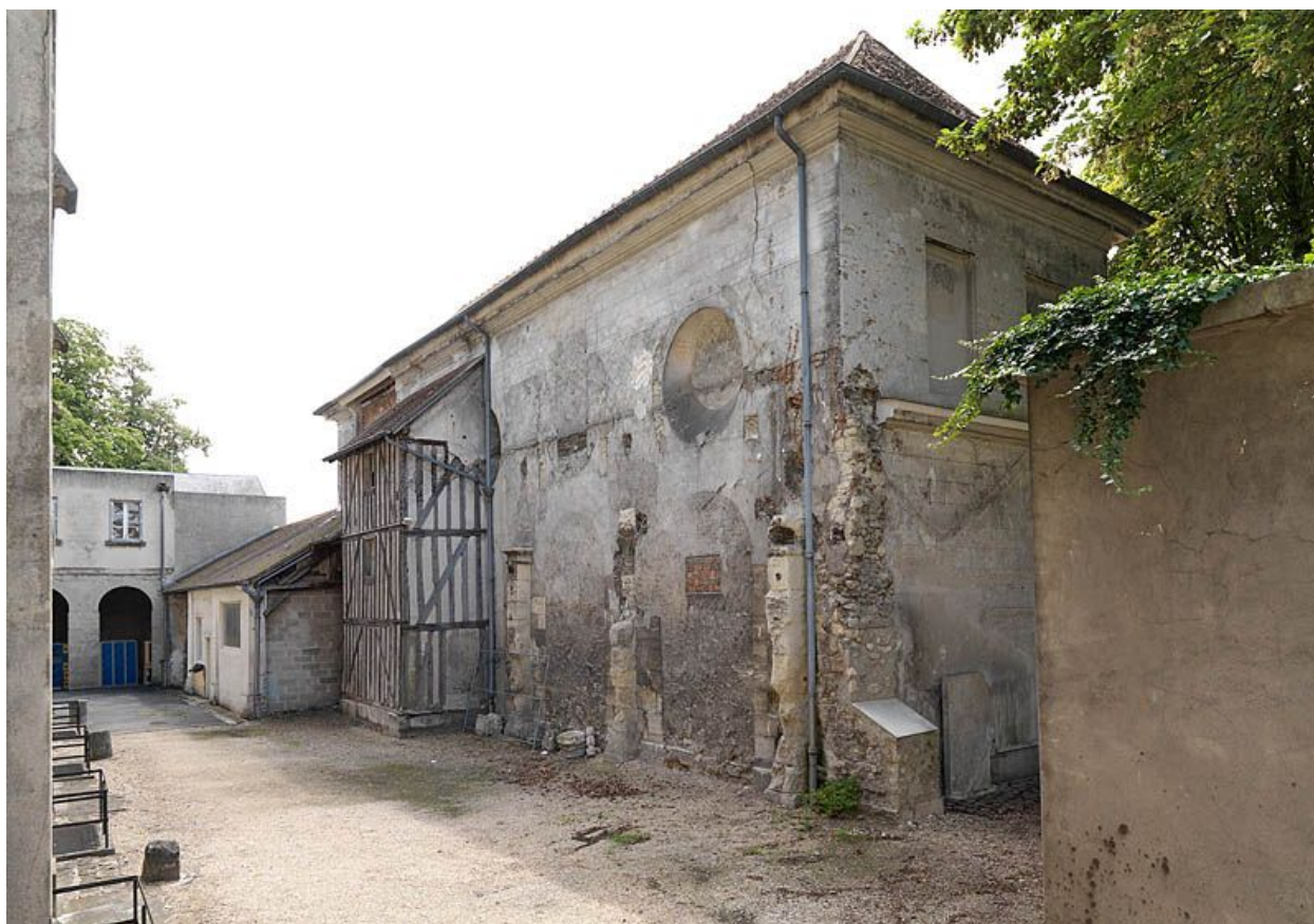
Ex-chapelle du Rosaire reconstruite au début du XVIIIe siècle, puis Orangerie Dassy. face nord avec oculi apparents et escalier hors oeuvre à pans de bois daté de 1820 environ.
