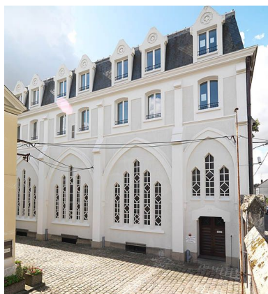
Vue latérale de la chapelle de 1936 Phot. Stéphane Asseline IVR11_20097700802NUC4A
