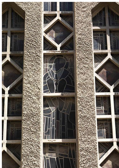
Détail de la mise en oeuvre et du vitrail d'une baie côté sud de la nouvelle chapelle. Phot. Stéphane Asseline IVR11_20097700839NUC4A
