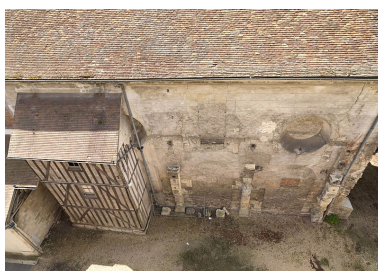
Ex-chapelle du Rosaire reconstruite au début du XVIIe siècle, puis Orangerie Dassy. face nord avec oculi apparents et escalier hors oeuvre à pans de bois daté de 1820 environ.
