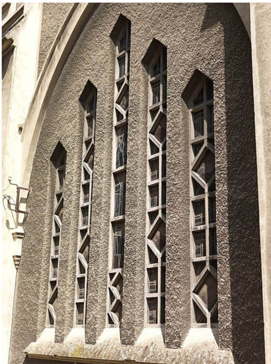
Baie côté sud de la nouvelle chapelle.
