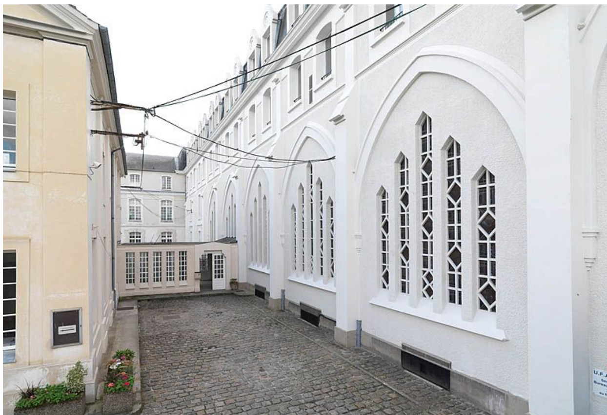
Couloir reliant l'ancienne chapelle à la nouvelle.
