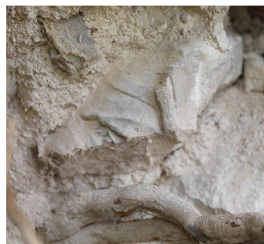
Détail du remploi de sculpture dans la mise en oeuvre du mur perpendiculaire au mur de clôture. Phot. Stéphane Asseline IVR11_20097700846NUC4A
