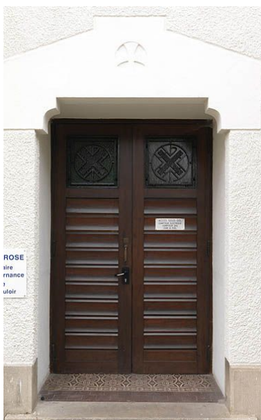
Porte avec décor de fer forgé. Phot. Stéphane Asseline IVR11_20097700850NUC4A
