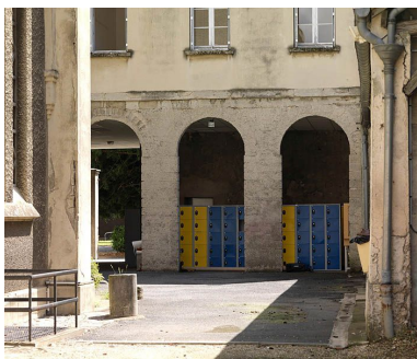
Arrière de l'ancienne sacristie. Phot. Stéphane Asseline IVR11_20097700840NUC4A
