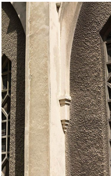
Détail de la mise en oeuvre d'une baie côté sud de la nouvelle chapelle. Phot. Stéphane Asseline IVR11_20097700838NUC4A
