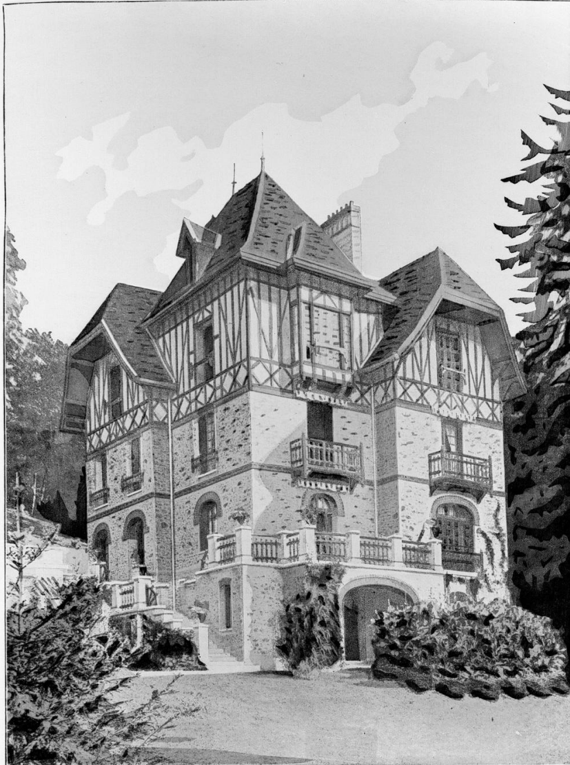
VILLA A JOUY-EN-JOSAS. — ARCHITECTE : M. BERTSCH-PROUST. MUSÉE DE L'ÎLE DE FRANCE SCEAUX
