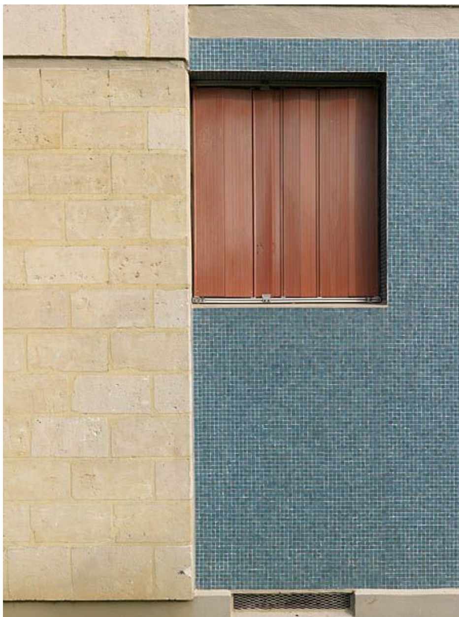
Détail de deux panneaux de façade : parpaings de pierre de Saint-Maximin et mosaïque de grès cérame bleu marqués par une discontinuité horizontale.
