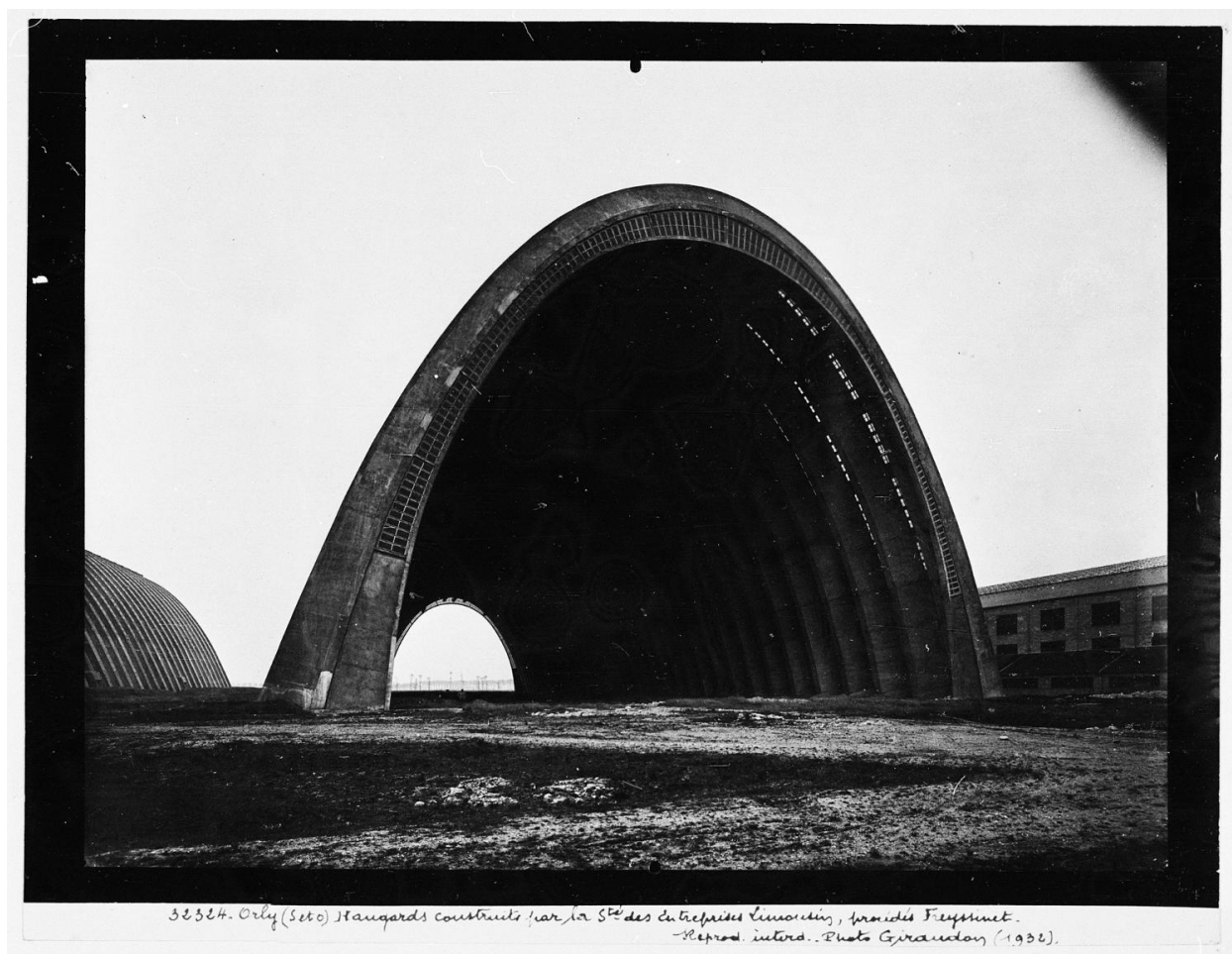
1932, les hangars à dirigeables d'Orly, vue prise depuis le sud ouest.
