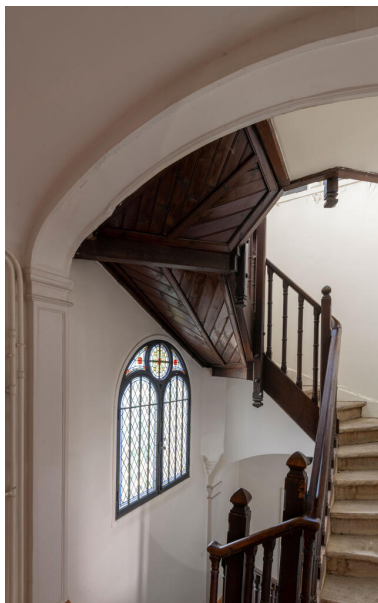
L'escalier principal "en charpente de chêne, à limon plein, à la française. Les différents morceaux du limon sont reliés entre eux aux angles par des poteaux carrés avec lesquels ils sont boulonnés dans les deux sens, et qui servent aussi à maintenir la rampe composée de barreaux tournés en chêne." Jules Saulnier, Encyclopédie d'architecture, 1879, p. 91. Phot. Kruszyk Laurent IVR11_20247800261NUC4A
