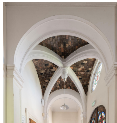
Dans le vestibule, détail de la voûte à croisée d'ogives. Phot. Kruszyk Laurent IVR11_20247800257NUC4A
