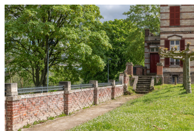
Le mur de clôture qui surplombe le chemin de halage et l'escalier d'accès à la "terrasse extérieure, accessible des pièces du rez-de-chaussée et en vue de la Seine" (Jules Saulnier, Encyclopédie d'architecture, 1879, p. 90). Phot. Kruszyk Laurent IVR11_20247800236NUC4A
