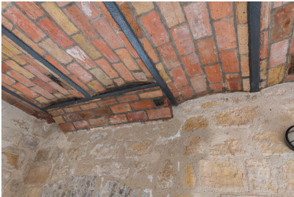
Voûtains de couverture dans la remise aux bateaux.
