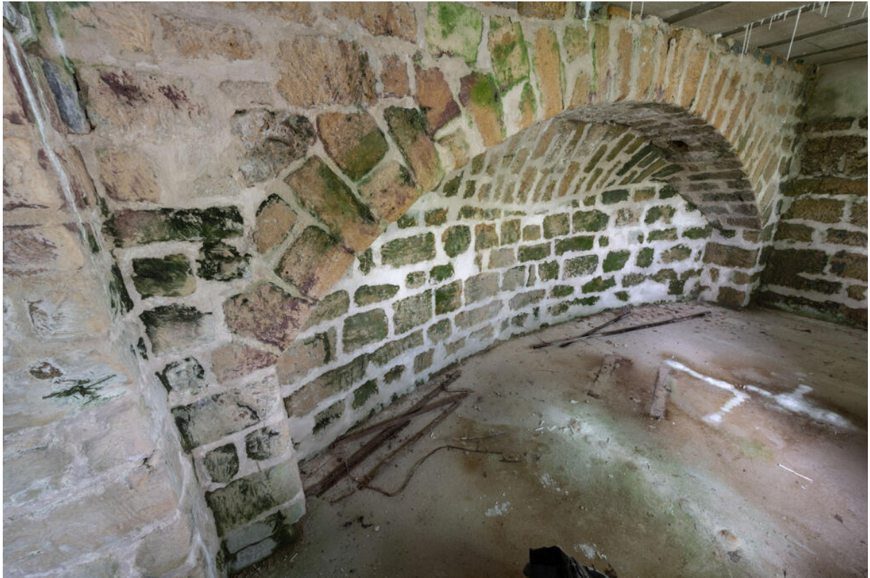
Au sous-sol, départ de voûte de décharge dans l'atelier ouvrant sur le chemin de halage.
