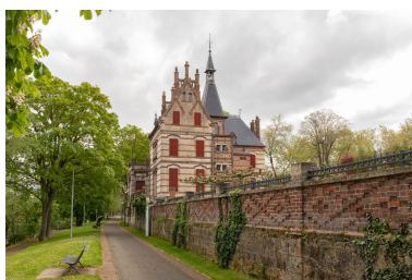
Vue du chemin de halage, du mur de soutènement de la propriété et de la façade ouest. Le motif du damier, qui se retrouve sur les façades de la maison, est créé sur le mur par le jeu de retrait des briques. Phot. Kruszyk Laurent IVR11_20247800237NUC4A
