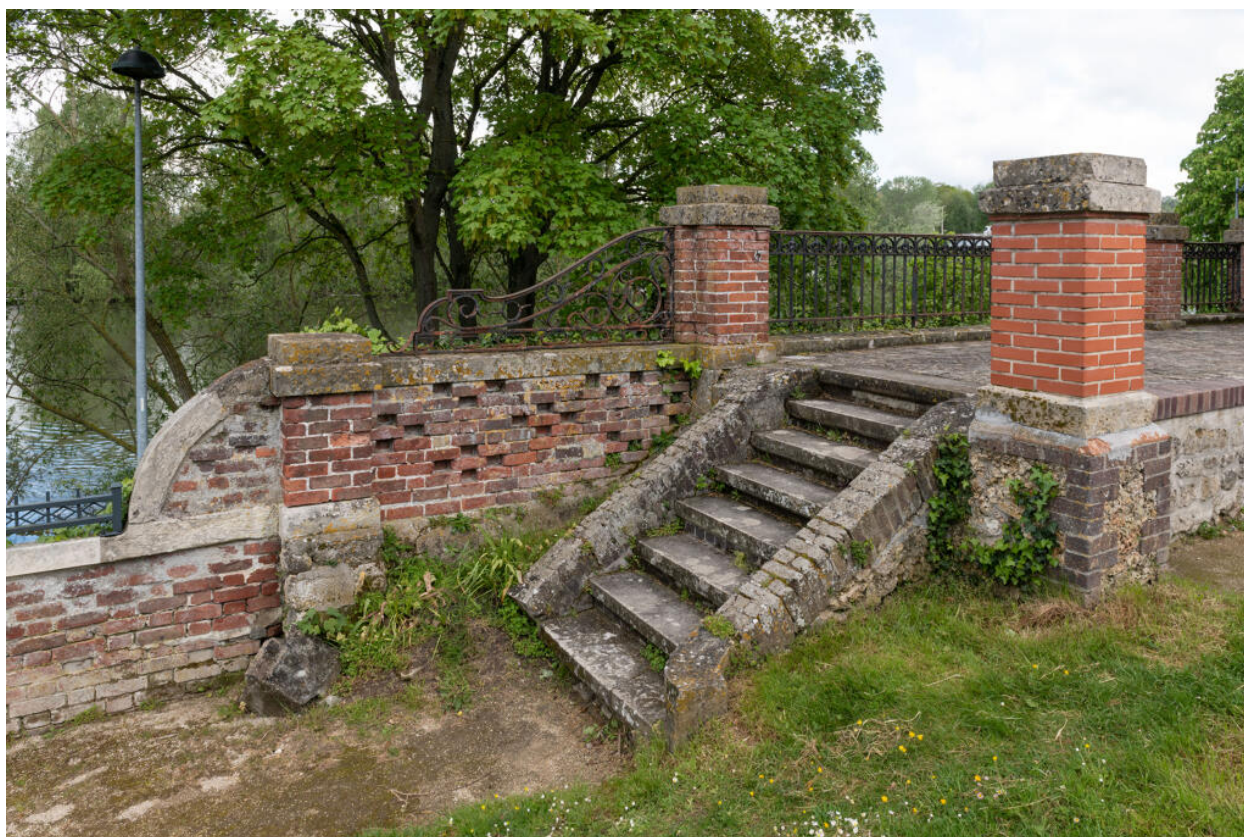
Détail de l'escalier d'accès à la terrasse et de son garde-corps en fer forgé.
