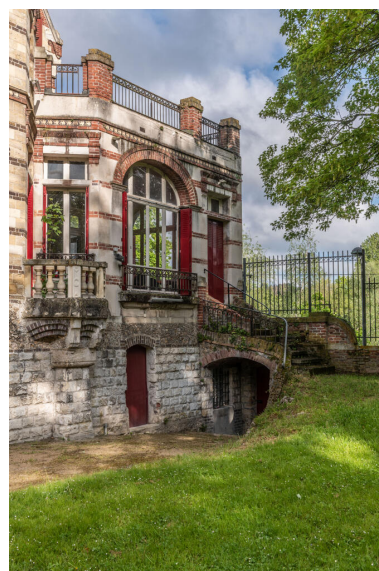
L'ancienne terrasse aujourd'hui fermée et l'accès vers le chemin de halage. La petite porte de gauche ménagée dans le soubassement donne accès à la remise à bateaux. Phot. Kruszyk Laurent IVR11_20247800251NUC4A
