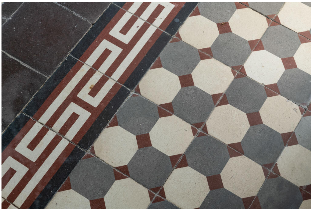
Détail des carreaux de ciment du côté de l'office et de la cuisine.
