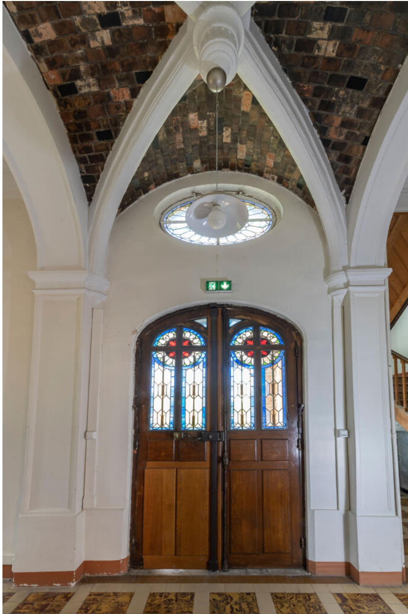
Le vestibule et la porte d'entrée.
