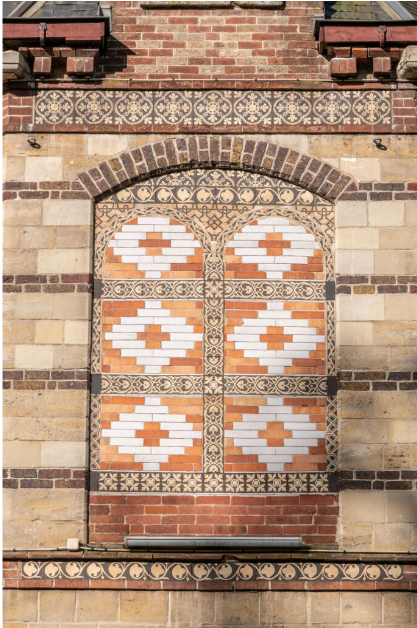
Détail de la fenêtre du premier étage en façade est, prévu et publié par Jules Saulnier (Encyclopédie d'architecture, 1879).
