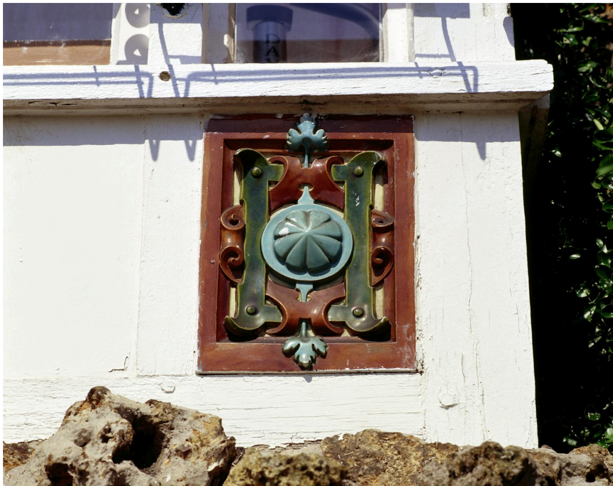
Détail d'un des cabochons de céramique qui ornent le bow-window.
