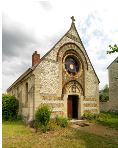
Vue d'ensemble. La façade se signale par l'emploi de divers matériaux : meulière, silex, calcaire, brique.
