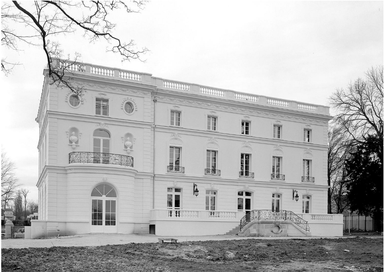
Vue d'ensemble de la façade postérieure après restauration.
