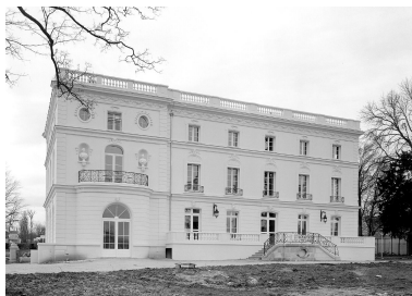
Vue d'ensemble de la façade postérieure après restauration. Phot. Christian Décamps IVR11_20007800753V
