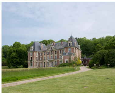
La façade sud-ouest sur jardin. A l'arrière plan, le bâtiment de la bibliothèque. Phot. Ayrault Philippe IVR11_20239500077NUC4A
