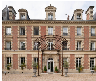
L'impressionnante marquise a été ajoutée dans les années 2010. Phot. Ayrault Philippe IVR11_20239500049NUC4A
