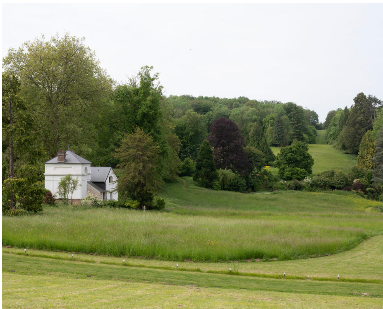
Le pavillon dit du moulin, construit sur l'un des bâtiments de l'ancienne ferme.
