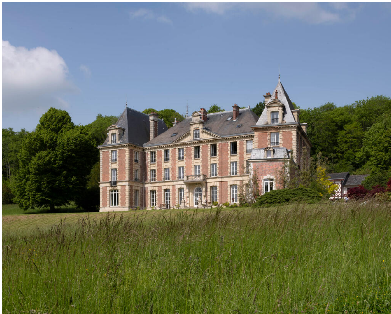
La façade sud-ouest sur jardin. On aperçoit le bâtiment de la bibliothèque sur la droite.
