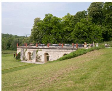
Le belvédère, dont la terrasse surmonte une vaste pièce voûtée, est construit sur les vestiges de l'ancienne ferme. Phot. Ayrault Philippe IVR11_20239500071NUC4A
