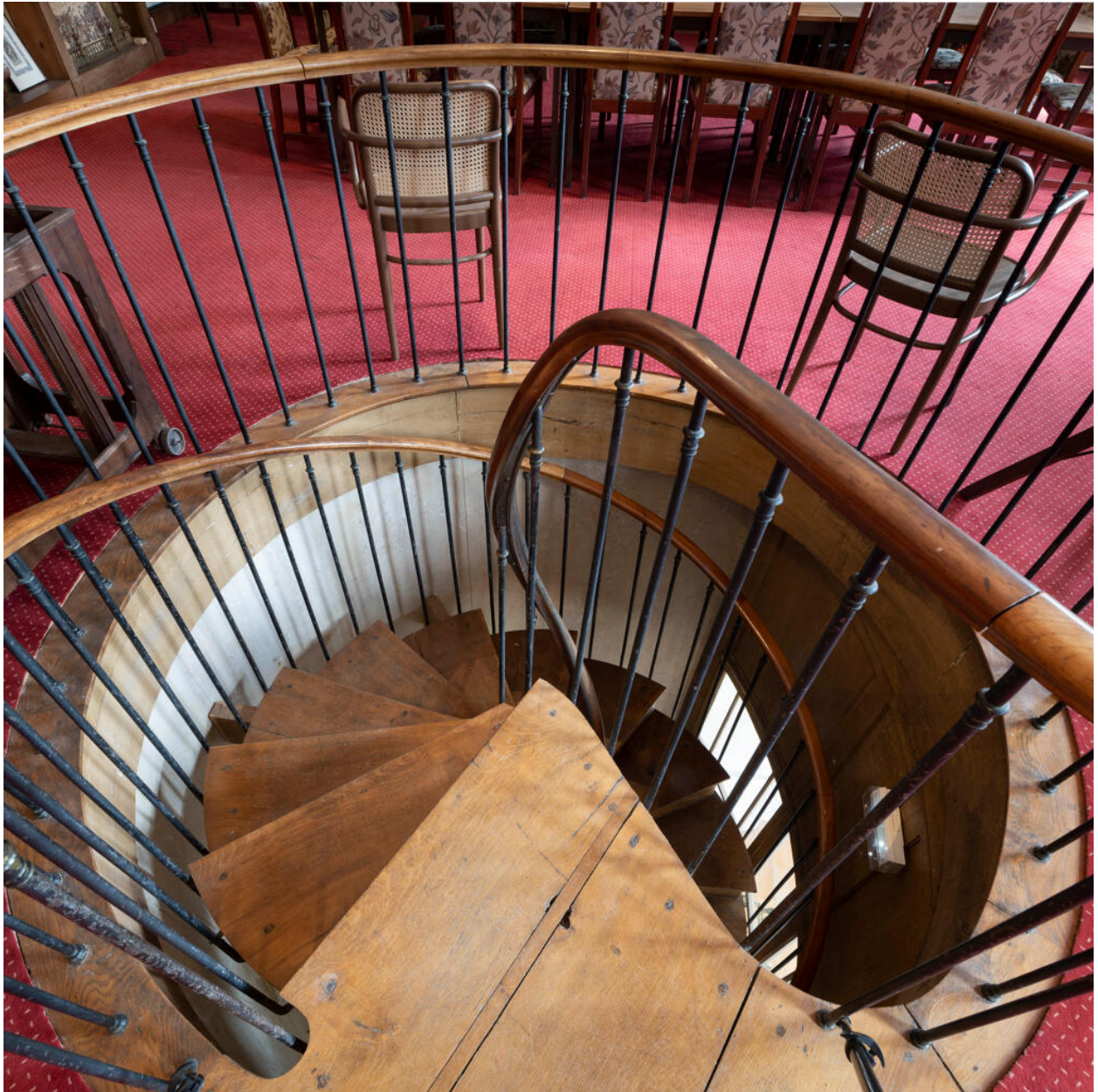
Détail de l'escalier de la bibliothèque.
