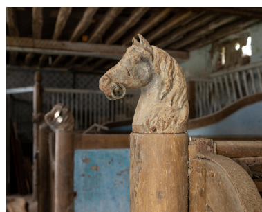
Les colonnes, comme les stalles, sont en bois mais la traditionnelle boule qui les surmonte est remplacée par un protomé de cheval en fonte. Phot. Ayrault Philippe IVR11_20239500117NUC4A
