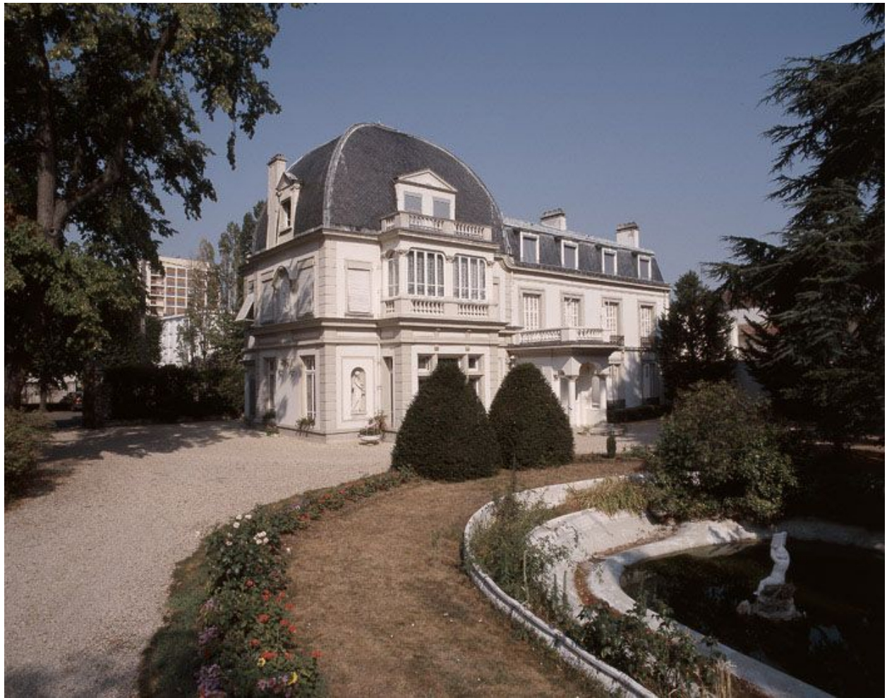
Façade côté parc.
