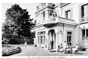
Façade principale, côté parc. Carte postale, vers 1930. (Collection particulière) Phot. Philippe Ayrault, Autr. Louis Rémy Sabattier IVR11_20059100461XB
