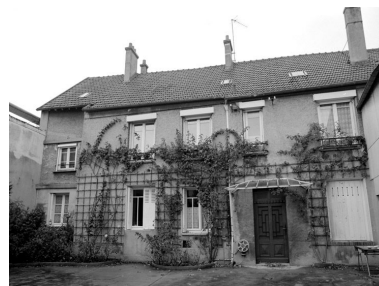
Elévation sur cour. Phot. Stéphane Asseline IVR11_20047700031X
