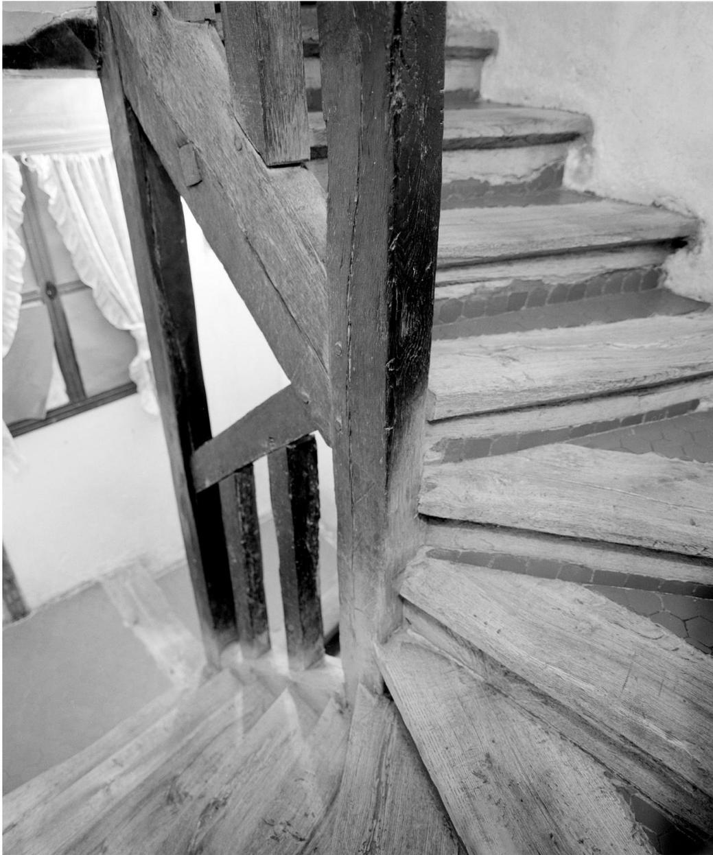
Vue de l'escalier en charpente, rampe sur rampe, dont les marches sont pavées de tomettes avec le nez en menuiserie. Il est daté par dendrochronologie des années 1670-1690.
