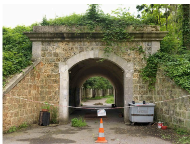
Vue du passage sous voûte de la batterie sud, de l'extérieur vers l'intérieur, cette fois en direction du fort (du nord vers le sud). Phot. Stéphane Asseline IVR11_20129300023NUC4A
