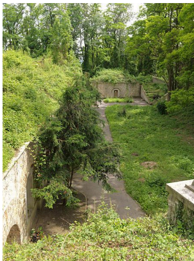
Vue de la batterie sud, depuis sa partie supérieure. Phot. Stéphane Asseline IVR11_20129300026NUC4A
