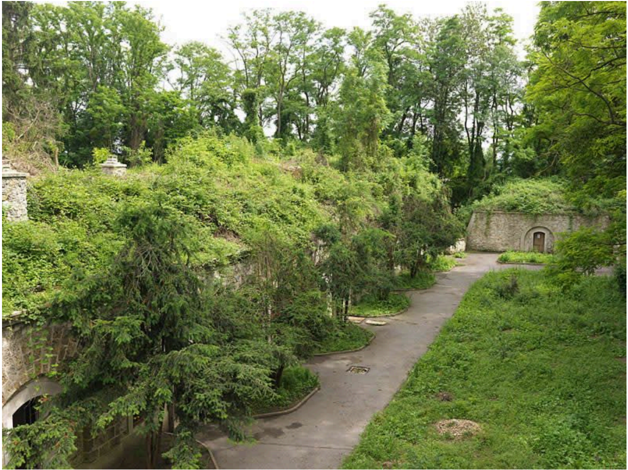
Vue générale de la partie intérieure de la batterie sud depuis sa partie supérieure.
