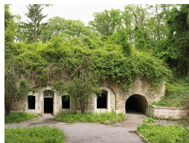
Vue de la partie intérieure de la batterie sud. Phot. Stéphane Asseline IVR11_2012930015NUC4A
