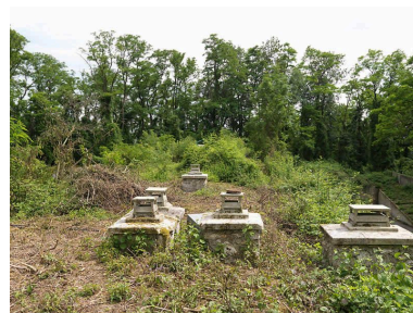
Vue de la partie supérieure de la batterie sud (bouches d'aération des casemates). Phot. Stéphane Asseline IVR11_20129300027NUC4A
