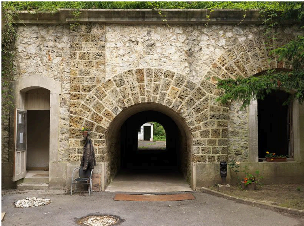
Vue du passage sous voûte de la batterie sud, de l'intérieur vers l'extérieur cette fois en direction du fort (du sud vers le nord).
