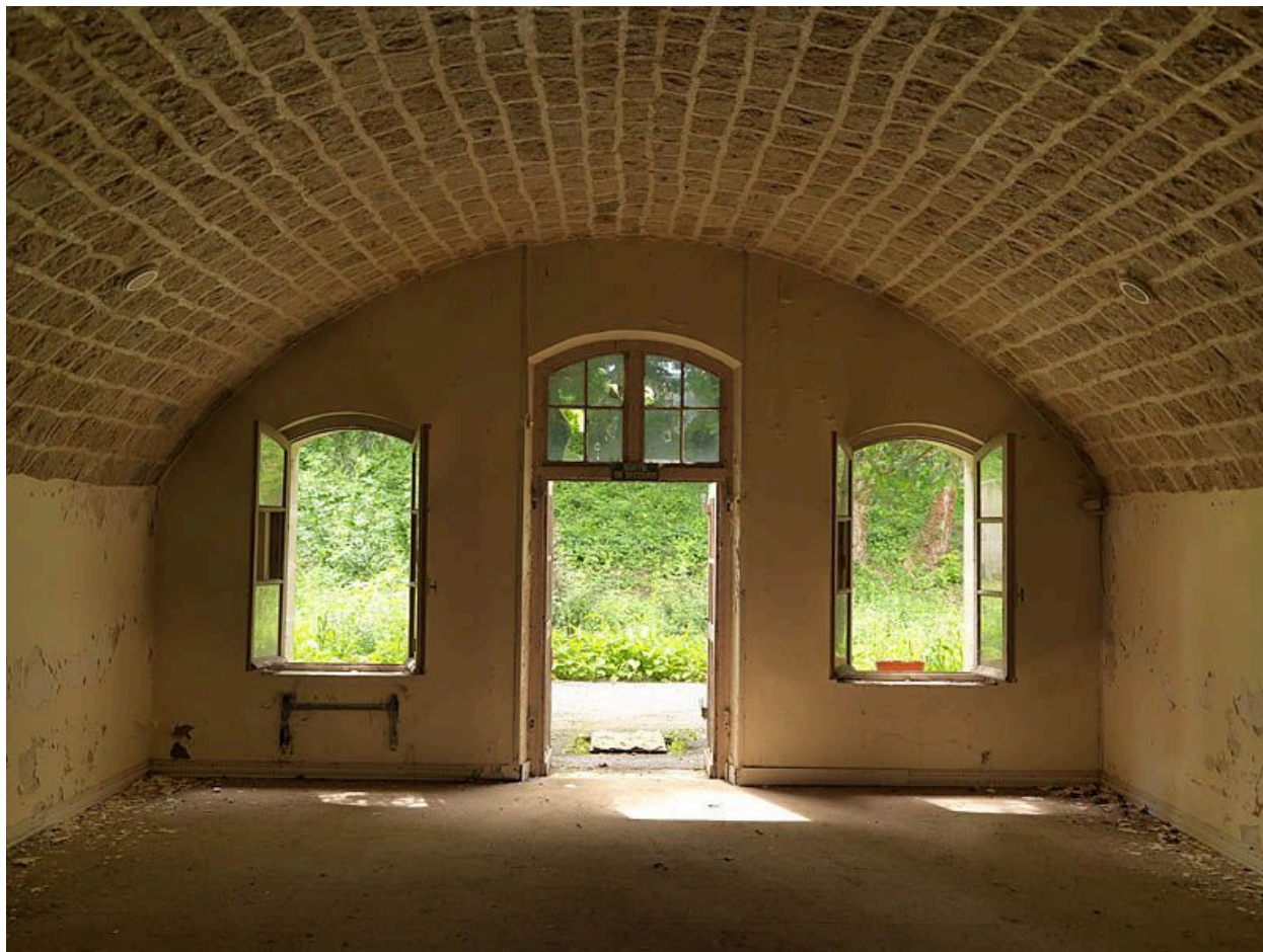
Vue intérieure d'une casemate de la batterie sud.
