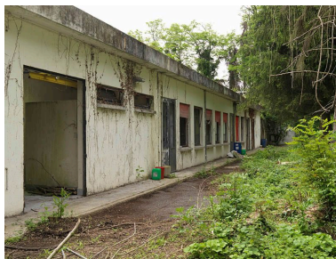
Vue des locaux techniques du CEA adossés à la partie extérieure de la batterie sud du fort. Phot. Stéphane Asseline IVR11_2012930005NUC4A
