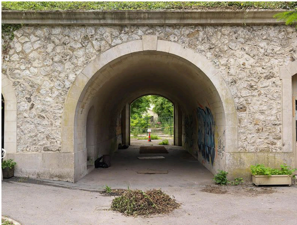
Vue du passage sous voûte de la batterie sud, de l'intérieur vers l'extérieur de celle-ci (de l'ouest vers l'est).
