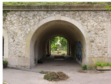
Vue du passage sous voûte de la batterie sud, de l'intérieur vers l'extérieur de celle- ci (de l'ouest vers l'est). Phot. Stéphane Asseline IVR11_20129300021NUC4A
