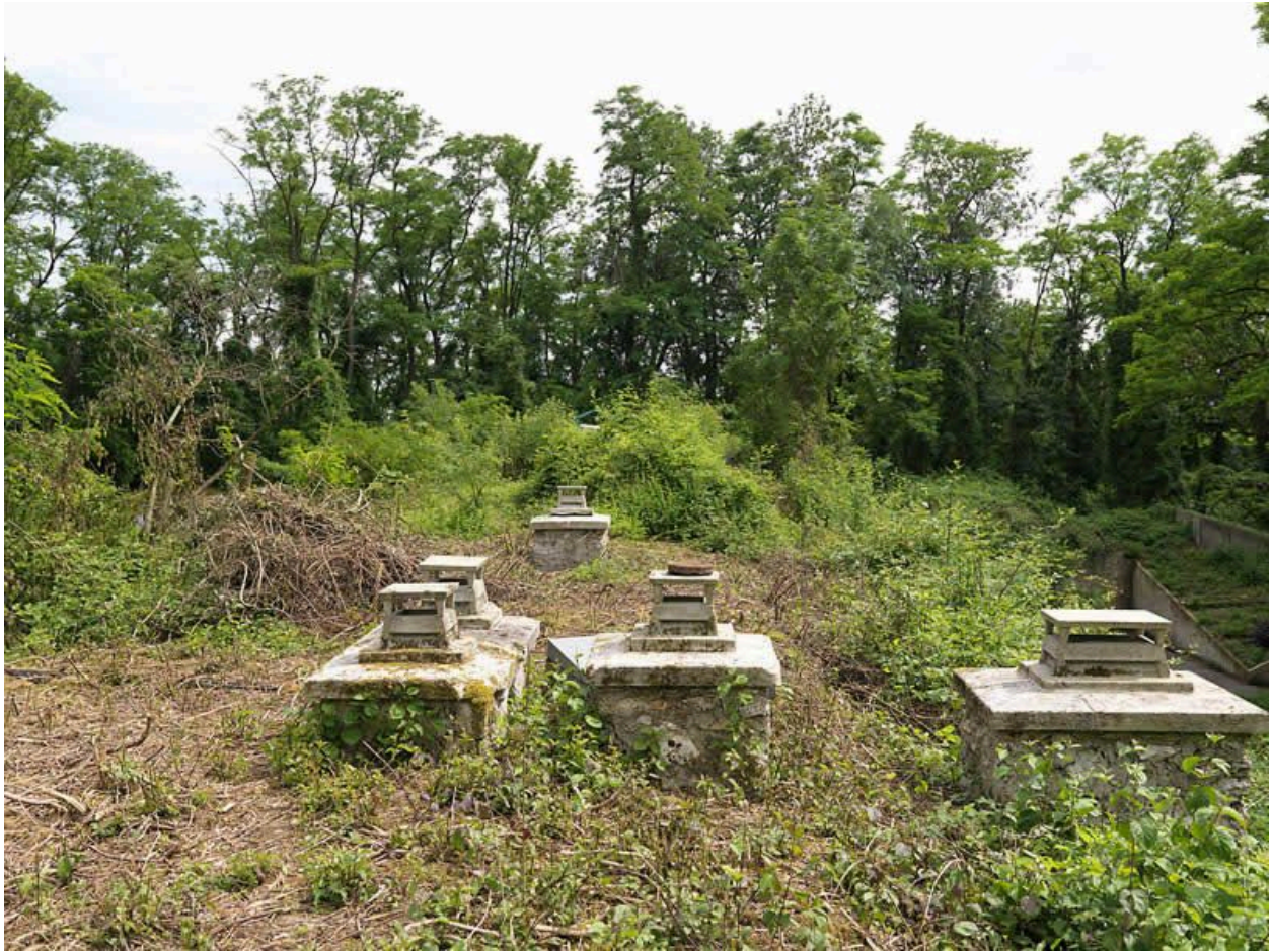
Vue de la partie supérieure de la batterie sud (bouches d'aération des casemates).
