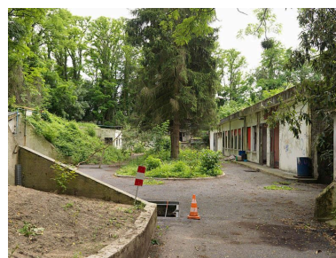
Vue des locaux techniques du CEA adossés à la partie extérieure de la batterie sud du fort.
