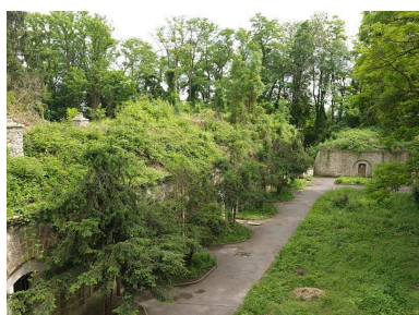
Vue générale de la partie intérieure de la batterie sud depuis sa partie supérieure. Phot. Stéphane Asseline IVR11_2012930010NUC4A
