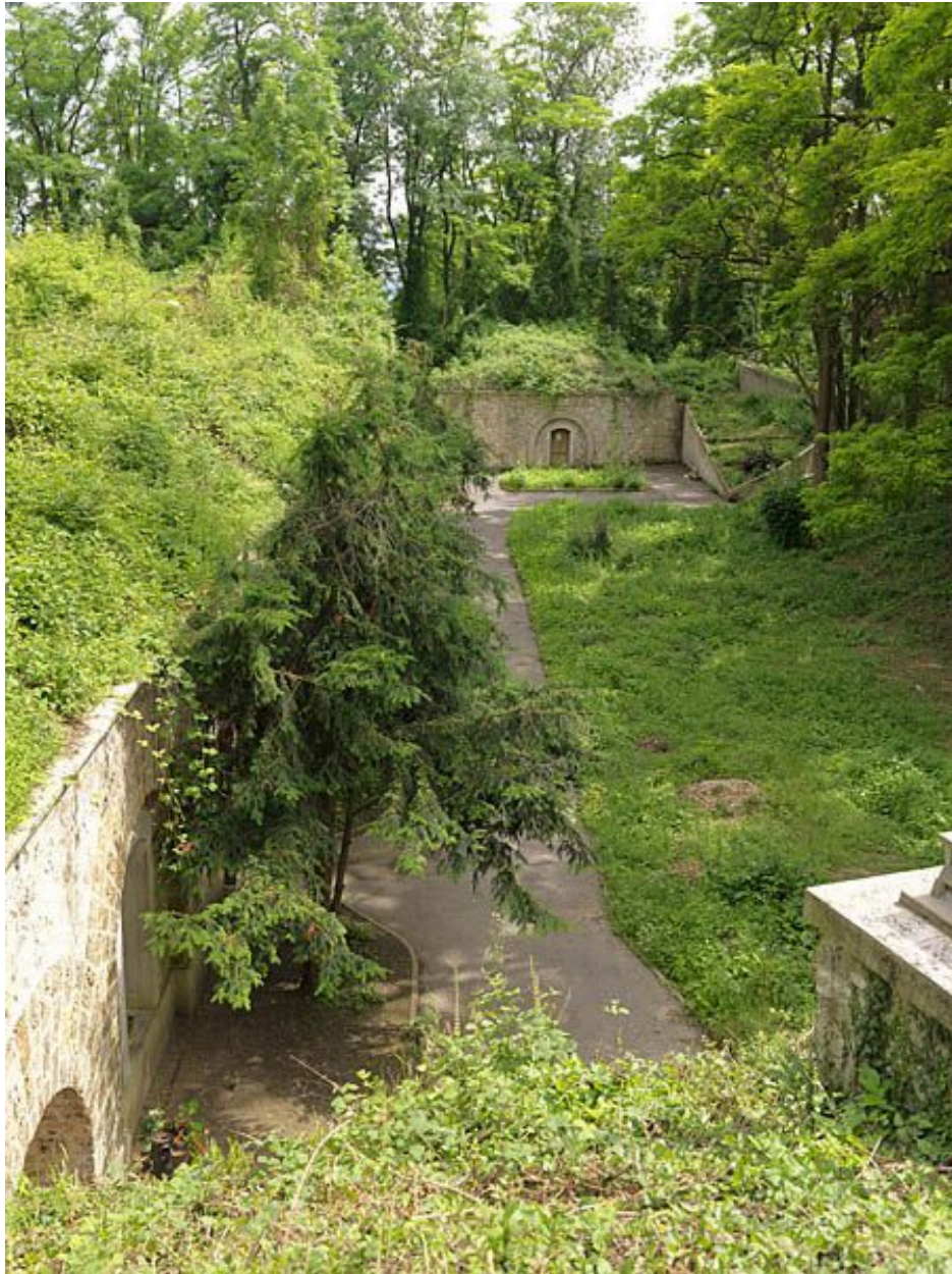
Vue de la batterie sud, depuis sa partie supérieure.
