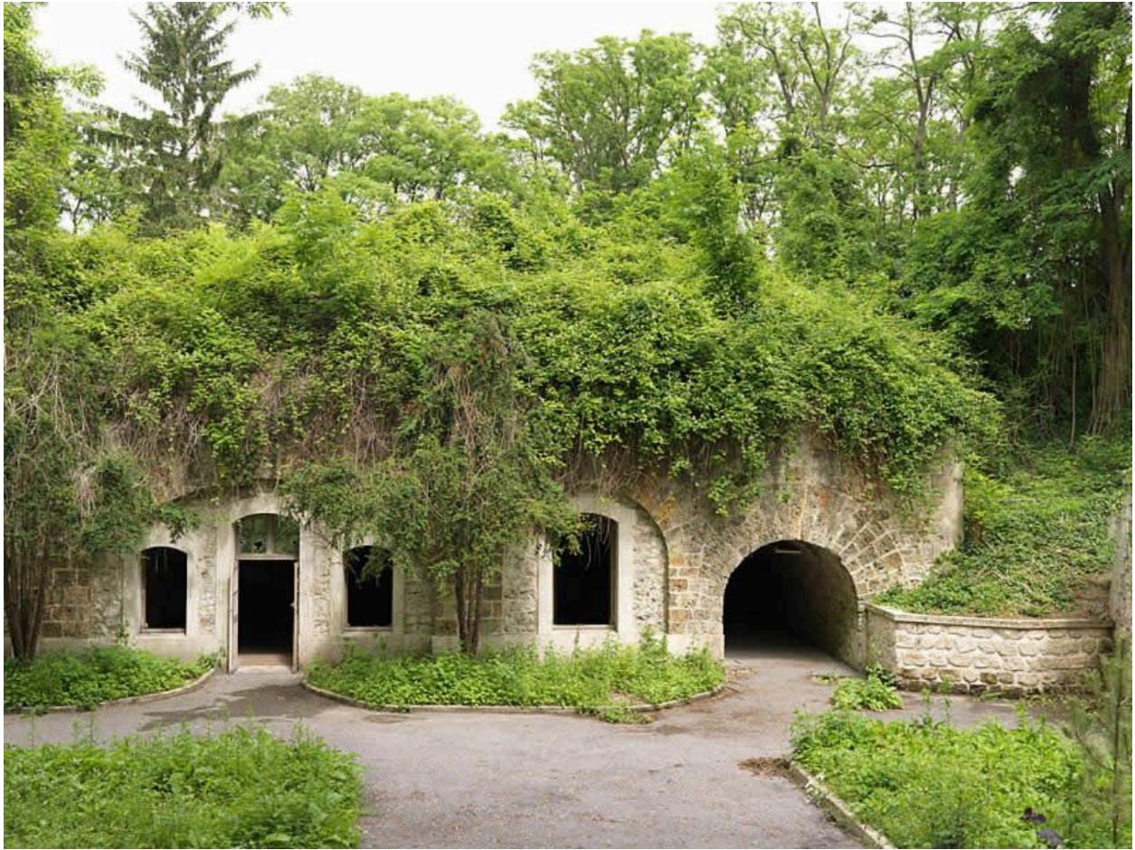
Vue de la partie intérieure de la batterie sud.
