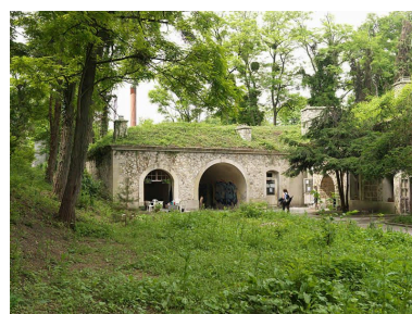
Vue de la partie intérieure de la batterie sud. Phot. Stéphane Asseline IVR11_2012930012NUC4A
