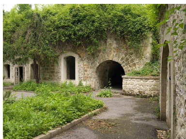
Vue de la partie intérieure de la batterie sud. Phot. Stéphane Asseline IVR11_2012930013NUC4A
