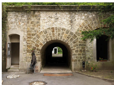
Vue du passage sous voûte de la batterie sud, de l'intérieur vers l'extérieur cette fois en direction du fort (du sud vers le nord). Phot. Stéphane Asseline IVR11_20129300022NUC4A
