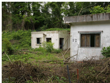
Vue des locaux techniques du CEA adossés à la partie extérieure de la batterie sud du fort. Phot. Stéphane Asseline IVR11_2012930004NUC4A
