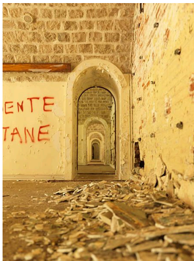
Vue intérieure de l'enfilade des portes communicantes entre les casemates de la batterie sud. Phot. Stéphane Asseline IVR11_20129300017NUC4A
