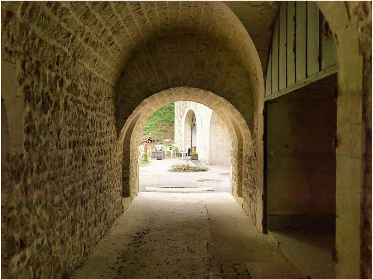
Passage sous voûte de la batterie sud, de l'extérieur vers l'intérieur de celle-ci (de l'ouest vers l'est).
