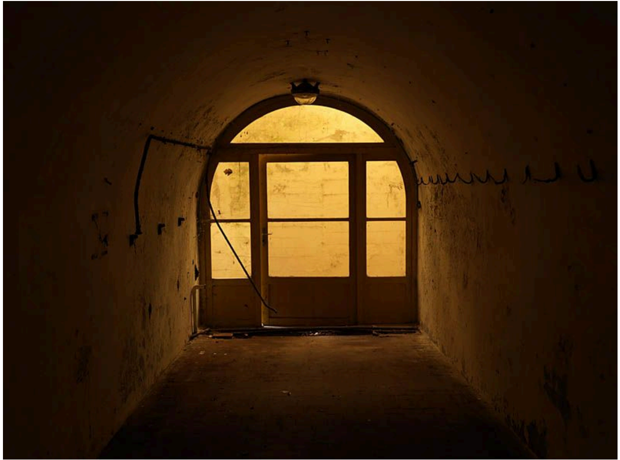
Vue intérieure de la batterie sud, casemate principale de la partie nord de la batterie.
