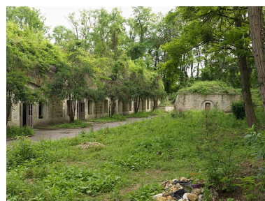
Vue générale de la partie intérieure de la batterie sud. Phot. Stéphane Asseline IVR11_2012930009NUC4A
