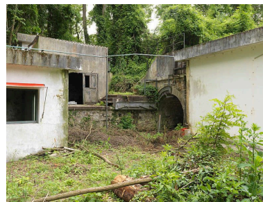
Vue des locaux techniques du CEA adossés à la partie extérieure de la batterie sud du fort. Phot. Stéphane Asseline IVR11_2012930006NUC4A
