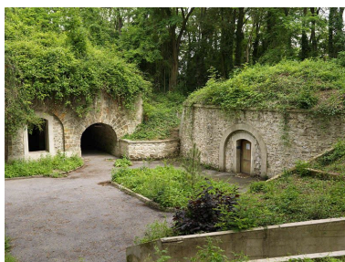
Vue de la partie intérieure de la batterie sud. Phot. Stéphane Asseline IVR11_2012930014NUC4A
