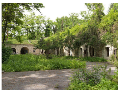
Vue générale de la partie intérieure de la batterie sud. Phot. Stéphane Asseline IVR11_2012930011NUC4A
