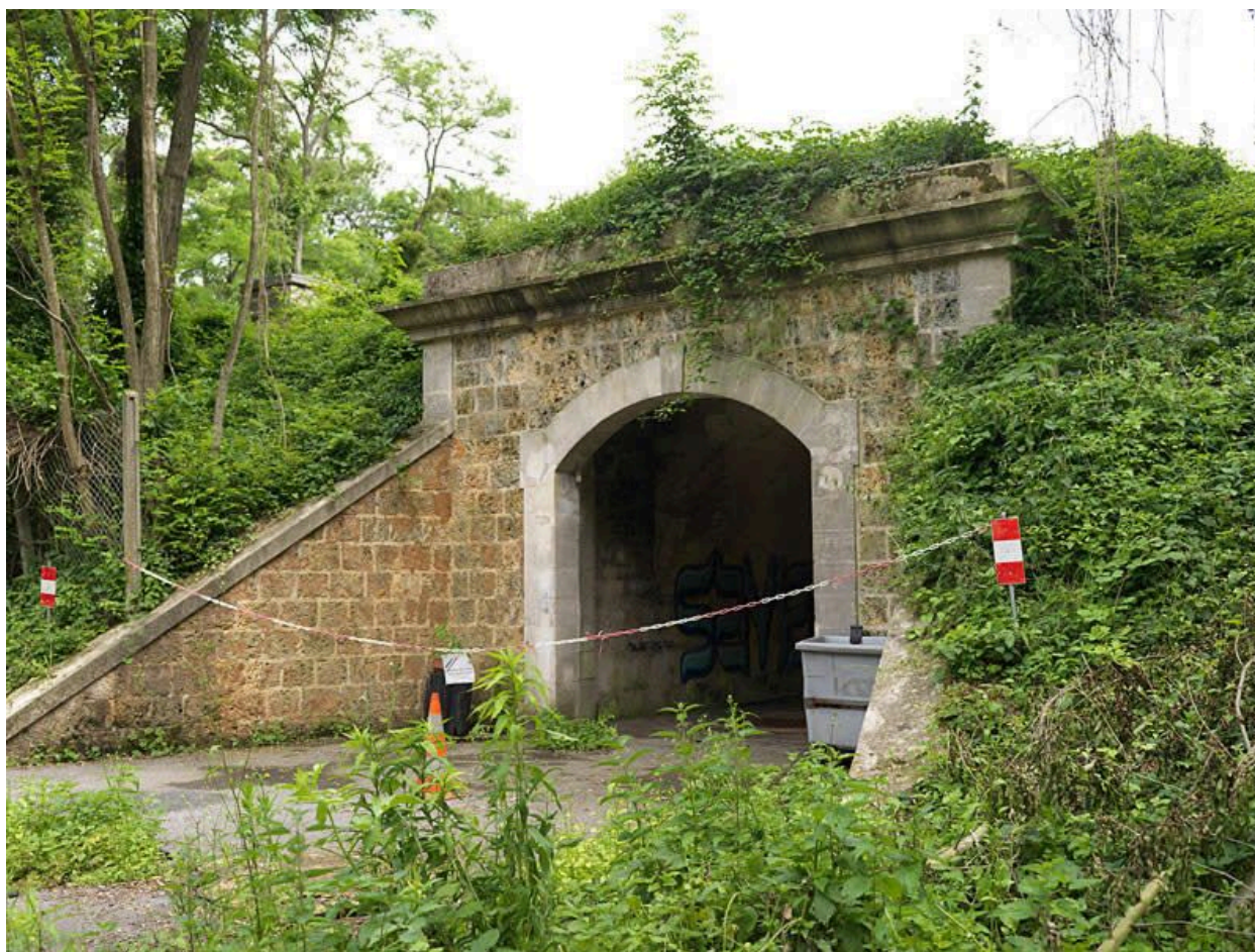
Vue du passage sous voûte de la batterie sud, de l'extérieur vers l'intérieur, cette fois en direction du fort (du nord vers le sud).
