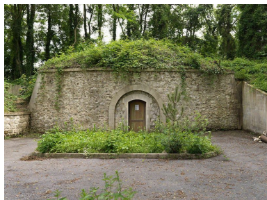
Vue de la partie intérieure de la batterie sud. Phot. Stéphane Asseline IVR11_20129300016NUC4A
