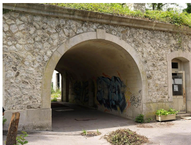
Vue du passage sous voûte de la batterie sud, de l'intérieur vers l'extérieur de celle- ci (de l'ouest vers l'est). Phot. Stéphane Asseline IVR11_20129300020NUC4A
