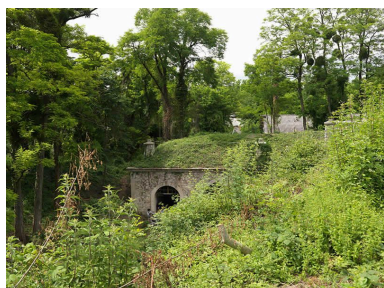
Vue de la batterie sud, depuis la partie supérieure. Phot. Stéphane Asseline IVR11_20129300028NUC4A
