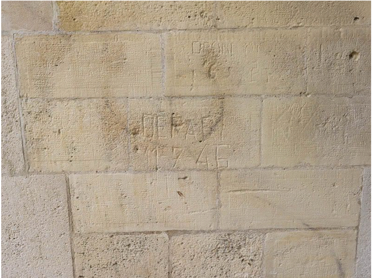
Vue de détail de graffiti sous le passage sous voûte de la batterie sud, de l'extérieur vers l'intérieur, en direction du fort.
