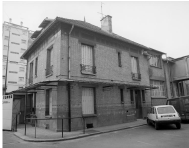
Vue du pavillon de l'entrée. Photographie. (AD Seine- Saint-Denis. A NB 118) Phot. Jean-Bernard Vialles IVR11_20029300123NUC
