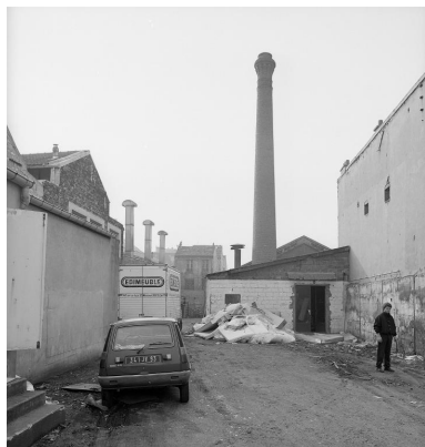
Vue de la cheminée. Photographie. (AD Seine-Saint-Denis. A NB 118) Phot. Jean-Bernard Vialles IVR11_20029300128NUC
