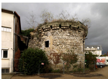
Vue latérale de la tour Saint-Martin Phot. Laurent Kruszyk IVR11_20167800682NUC4A
