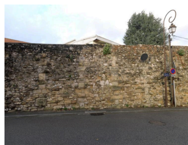
Détail de l'enceinte fortifiée, bas de la rue des Martraits. Phot. Laurent Kruszyk IVR11_20167800688NUC4A
