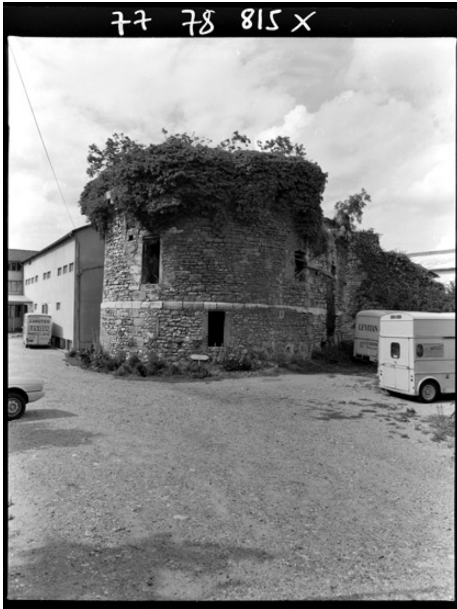
Vue de la tour Saint-Martin en 1977.
