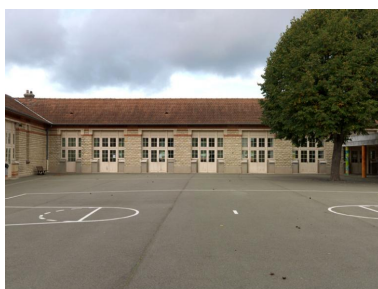
Les classes de l'aile nord de la cour. Cette aile est en rez-de- chaussée sur la cour et repose sur un étage de soubassement. Phot. Laurent Kruszyk IVR11_20167800584NUC4A
