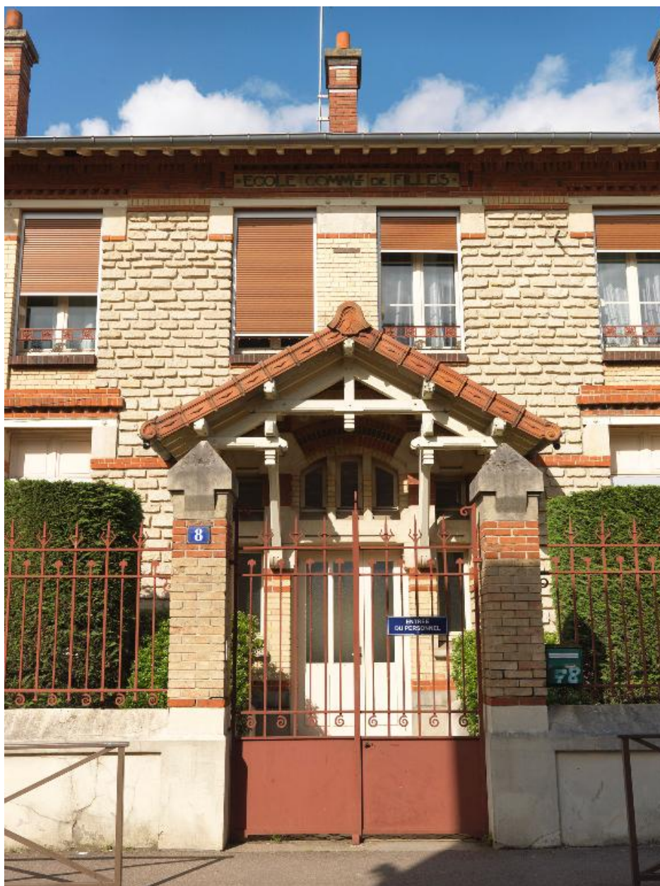
Vue de l'entrée principale.
