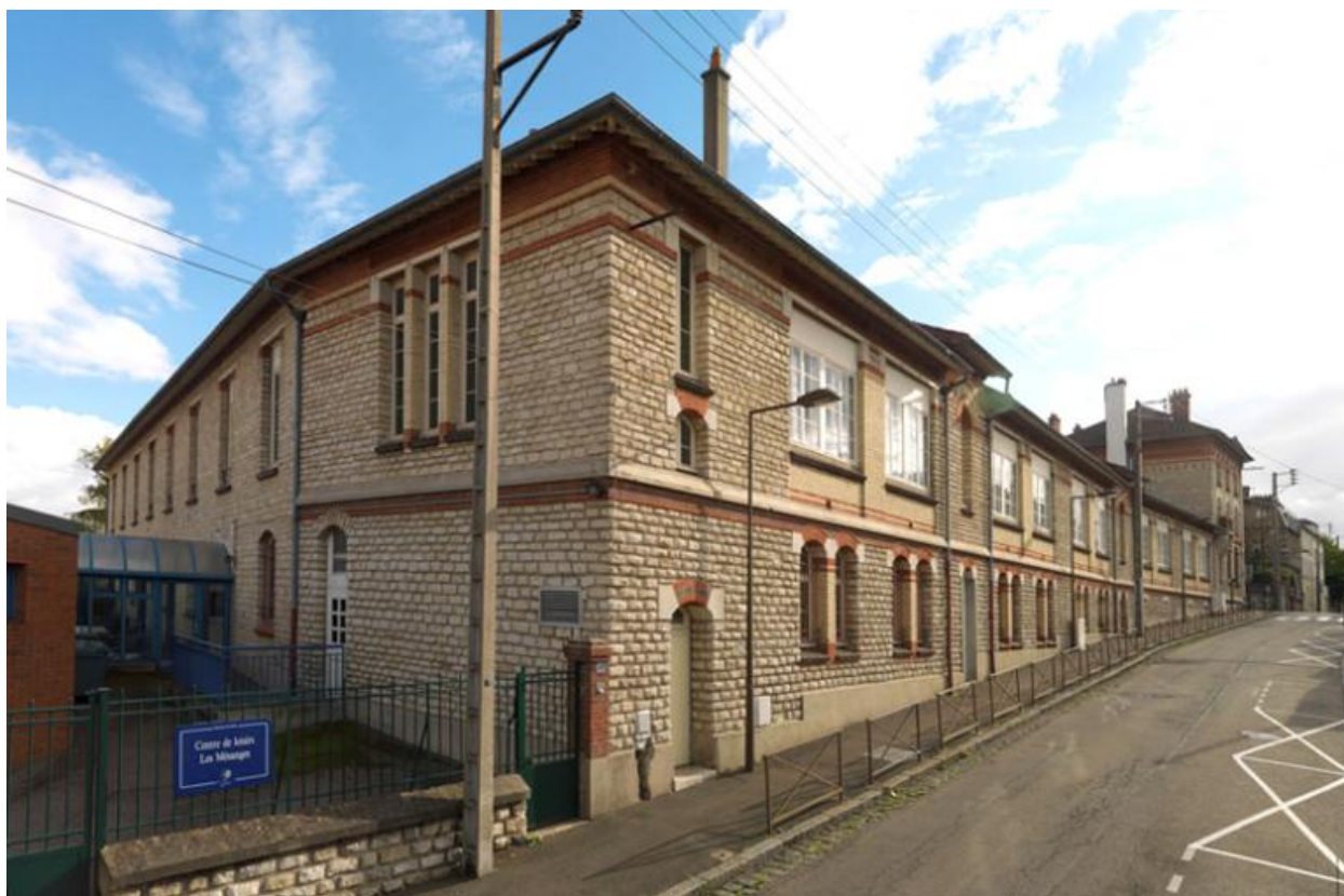
La façade rue Castor vue depuis le nord. C'est de ce côté que se trouvait l'entrée du "musée Mesnil" et du cinéma.
