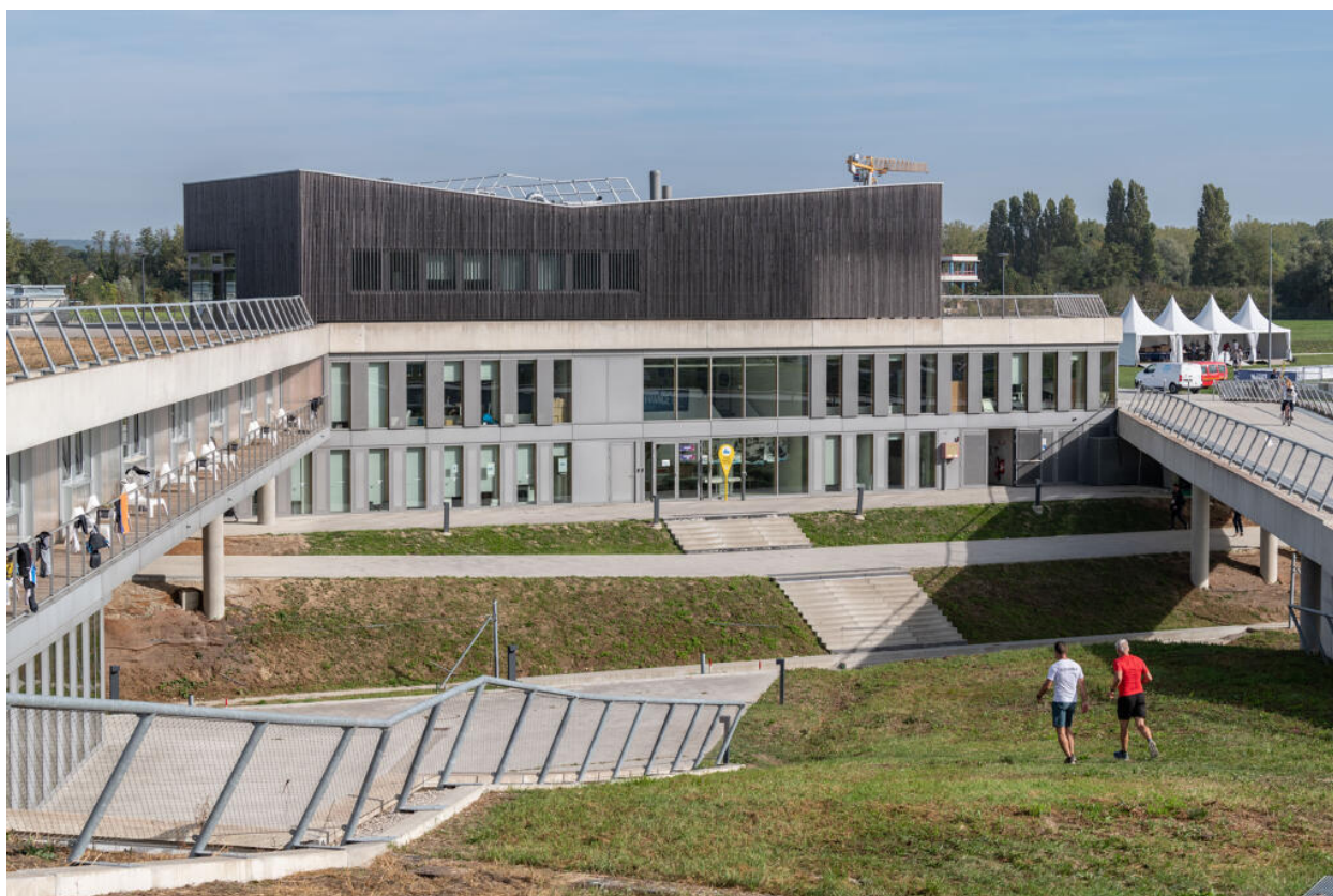
Stade nautique olympique. Vue sur le bâtiment d'hébergement et d'accueil.
