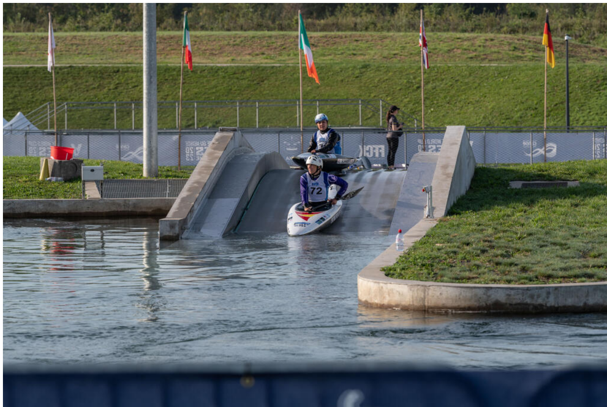
Stade nautique olympique. Vue sur la rivière de compétition du stade d'eau vive et l'arrivée de canoës-kayaks sur le tapis roulant.
