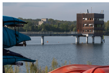
Stade nautique olympique. Vue sur le plan d'eau et la tour d'arrivée. IVR11_20237700856NUC4A
