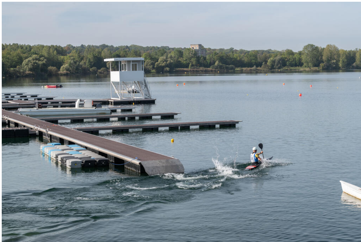
Stade nautique olympique. Vue sur le plan d'eau et ses pontons.
