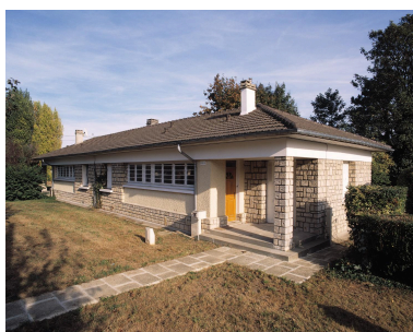
Vue d'ensemble des pavillons jumelés situés 14 et 16, rue Alexandre-Pichaudou (type J 3C). Phot. Philippe Ayrault IVR11_20029101495XA
