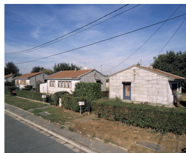
Vue d'ensemble des pavillons Phénix situés 2, 4 et 6, impasse Jean-Le-Stradic ; dix pavillons de ce type ont été construits en 1962 pour le relogement des fonctionnaires rapatriés d'Algérie. Phot. Philippe Ayrault IVR11_20029101507XA
