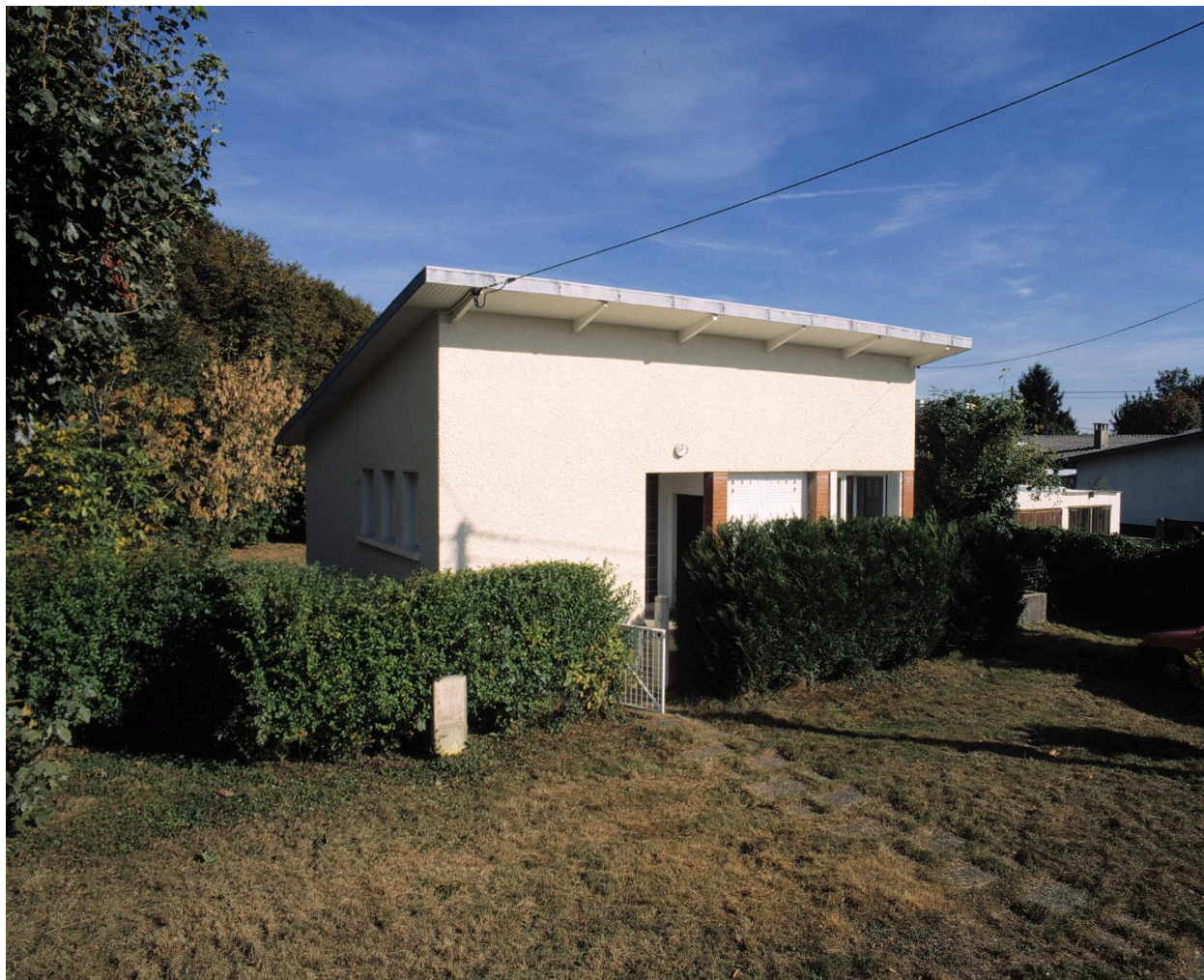
Vue d'ensemble du pavillon situé au 22, rue André-Launay.
