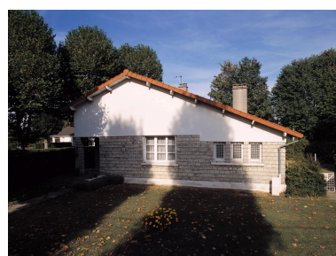
Vue d'ensemble du pavillon situé 16, rue Nungesser-et-Coli. Phot. Philippe Ayrault IVR11_20029101530XA
