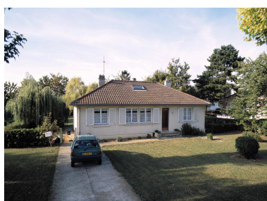
Vue d'ensemble du pavillon situé au 15ter, rue Alexandre-Pichaudou. Phot. Philippe Ayrault IVR11_20029101492XA
