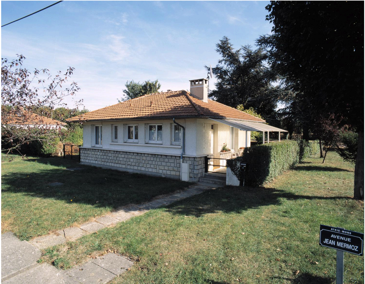
Vue d'ensemble du pavillon situé 8, avenue Jean-Mermoz.
