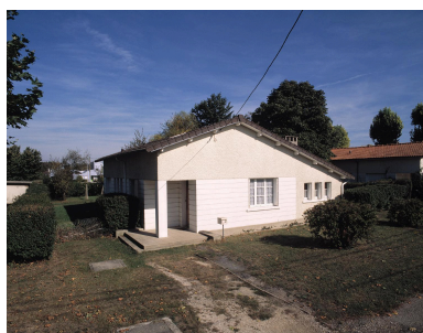
Vue d'ensemble du pavillon situé 4, rue Emile-Lécrivain (type I 4D). Phot. Philippe Ayrault IVR11_20029101504XA
