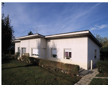
Vue d'ensemble des pavillons jumelés situés aux 5 et 7, rue Alexandre-Pichodou. Phot. Philippe Ayrault IVR11_20029101612XA
