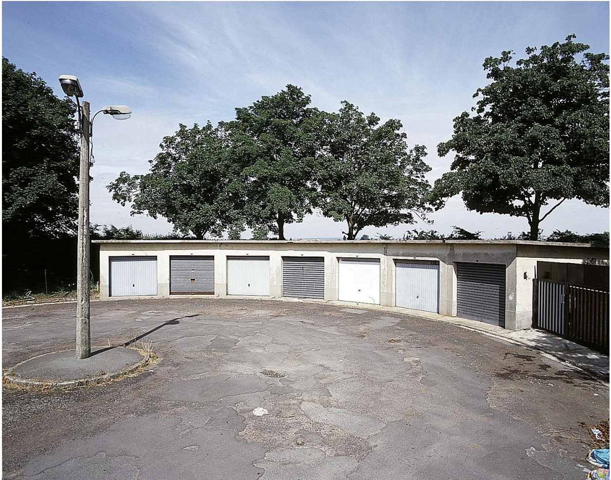
Vue des garages disposés en arc de cercle à l'extrémité de la rue Lavidalie.
