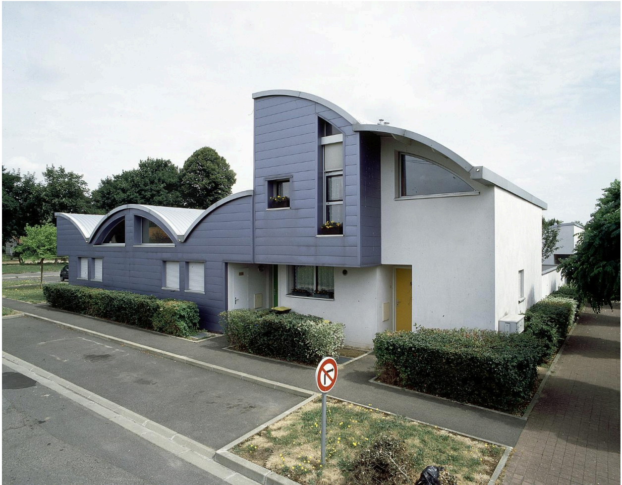
Vue d'un groupe de logements construits en 1994 pour la gendarmerie des transports aériens le long de la rue Robert-Bajac.
