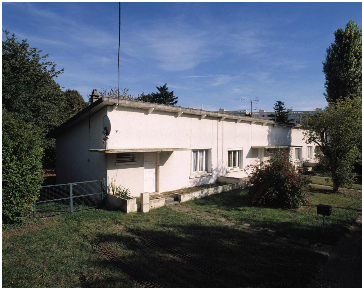
Vue d'ensemble des pavillons en bande situés 2-12, rue Fernand-Clavère.
