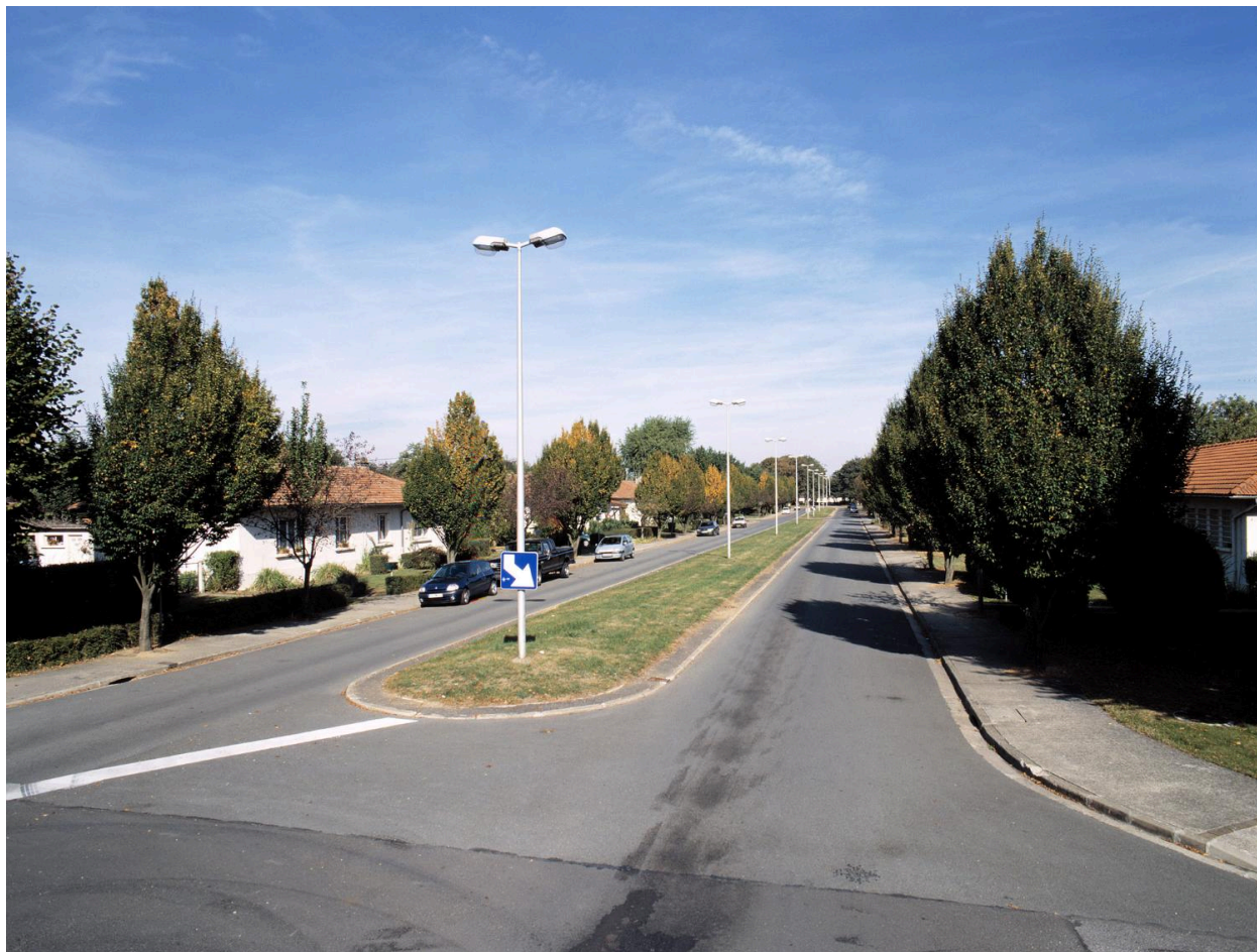
Vue perspective de l'avenue Maurice Noguès, axe principal de composition de la Cité dans sa partie ouest (deux chaussées séparées par un terre-plein central).
