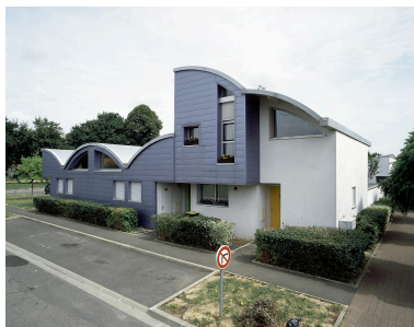
Vue d'un groupe de logements construits en 1994 pour la gendarmerie des transports aériens le long de la rue Robert-Bajac.
