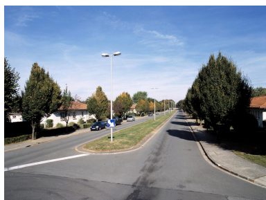
Vue perspective de l'avenue Maurice Noguès, axe principal de composition de la Cité dans sa partie ouest (deux chaussées séparées par un terre-plein central).
