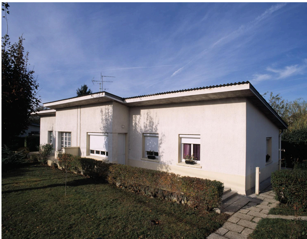
Vue d'ensemble des pavillons jumelés situés aux 5 et 7, rue Alexandre-Pichodou.
