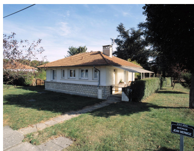
Vue d'ensemble du pavillon situé 8, avenue Jean-Mermoz.
