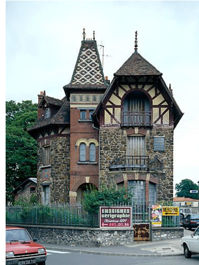
Façade antérieure. Phot. Christian Décamps IVR11_19859401017VA
