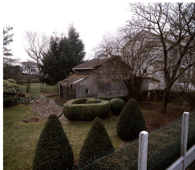
Vue d'ensemble. Phot. Philippe Ayrault IVR11_20059100190XA
