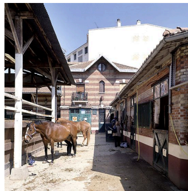
Vue d'ensemble, à gauche le manège couvert, à droite et au fond les écuries. Phot. Stéphane Asseline IVR11_20049400118VA
