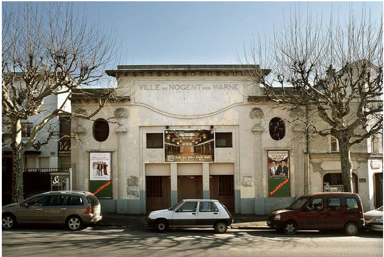
Vue de la façade de la salle des fêtes, boulevard de Strasbourg. Ancienne usine transformée par T. Hillion en gymnase vers 1930.
