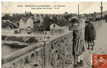
Carte postale, vue vers le viaduc (le tirage de la carte postale est inversé). Le pont a été reconstruit après la seconde guerre mondiale. (Musée Nogent-sur-Marne) IVR11_20049400693NUCAB
