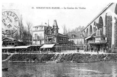
Vue du casino sur les bords de Marne, en aval du viaduc. Bâtiments aujourd'hui démolis. Carte postale. (AD Val-de-Marne) IVR11_19859400252XB
