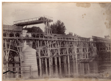
Vue du pont de Nogent en construction entre 1895 et 1899 et qui n'existe plus aujourd'hui. Photographie. (Musée Nogent-sur-Marne) IVR11_20049400593NUCAB
