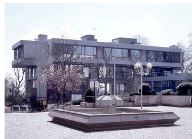
Vue d'ensemble de la sous-préfecture qui domine le square Watteau, 4 avenue de Lattre de Tassigny. Phot. Stéphane Asseline IVR11_20059400183XA
