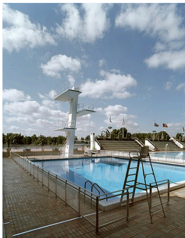
Piscine, 8 rue du Port. Vue d'ensemble du bassin extérieur du complexe construit en 1970 par les architectes Claude Guillemain et Paul-Erasme Koch. IVR11_20059400238VA
