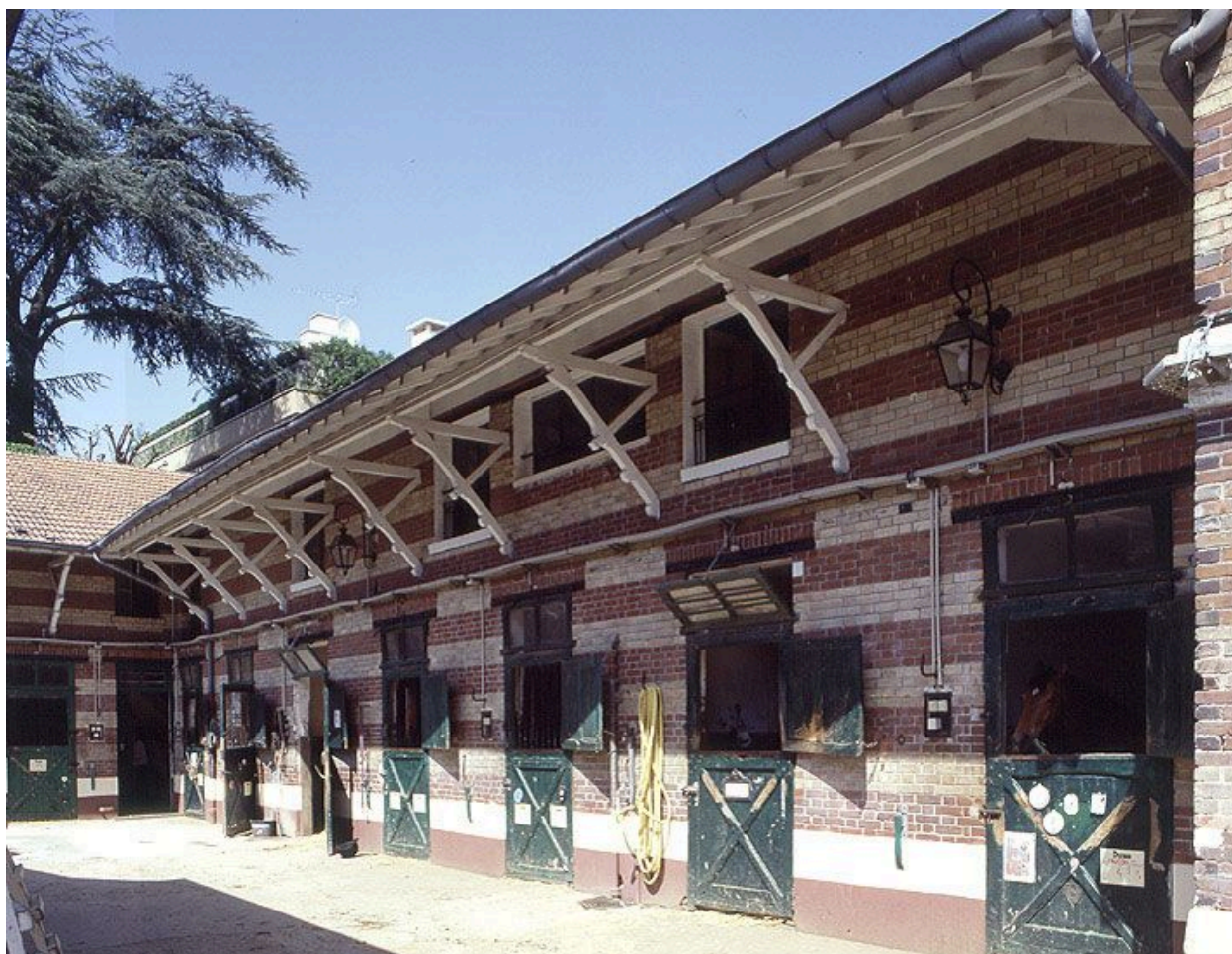
Cercle hippique du bois de Vincennes, , 8 rue de Fontenay. Vue des écuries.
