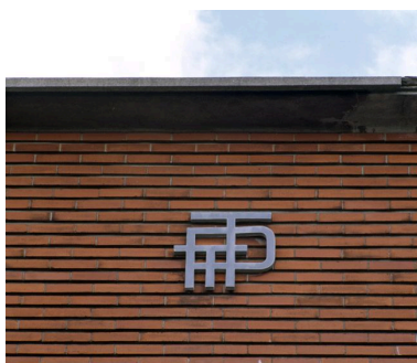
Détail du sigle PTT en façade de la poste, 48 rue du général Chanzy. Phot. Laurent Kruszyk IVR11_20049400244XA
