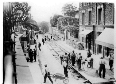
Vue de travaux du doublement des voies du tramway dans la Grande-Rue. Tirage photographique, circa 1925. Tiré de : Nogent-sur-Marne : étude de l'évolution d'une commune de banlieue. Thèse d'urbanisme, université d'urbanisme de Paris / Maurice Salabert, 1928. (Musée Nogent-sur-Marne) IVR11_20059400127NUCB
