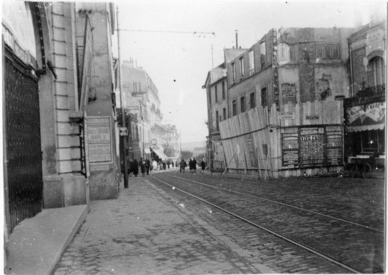
Vue de travaux d'élargissement de la Grande-Rue. Tirage photographique, circa 1925. Tiré de : Nogent-sur-Marne : étude de l'évolution d'une commune de banlieue. Thèse d'urbanisme, université d'urbanisme de Paris / Maurice Salabert, 1928. (Musée Nogent-sur-Marne)
