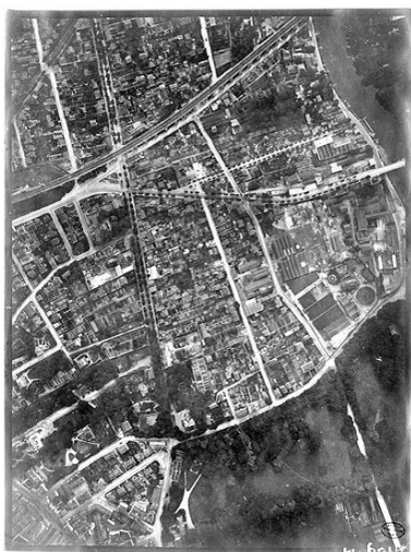
Vue aérienne du viaduc et de la zone industrielle (aujourd'hui le port). Tirage photographique, circa 1925. Tiré de : Nogent-sur-Marne : étude de l'évolution d'une commune de banlieue. Thèse d'urbanisme, université d'urbanisme de Paris / Maurice Salabert, 1928. (Musée Nogent-sur-Marne) IVR11_20059400131NUCB
