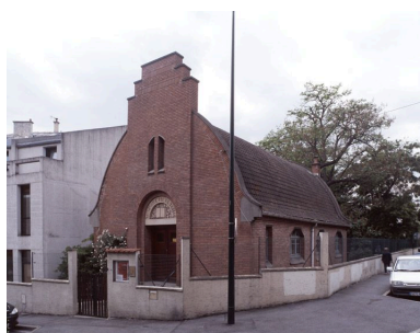
Vue du temple, 39 Grande rue Charles de Gaulle. Phot. Stéphane Asseline IVR11_20059400266VA
