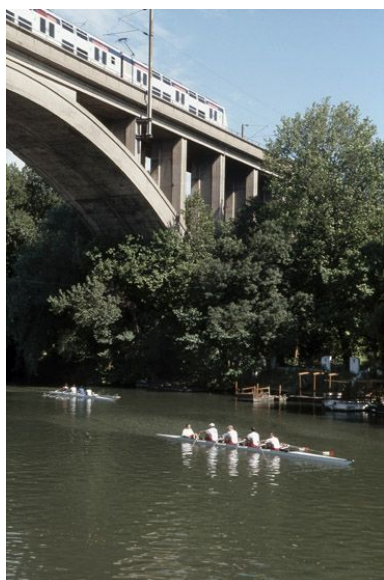
Vue depuis la rive de Nogent vers la pile du viaduc sur l'île des Loups durant une compétition d'aviron.
