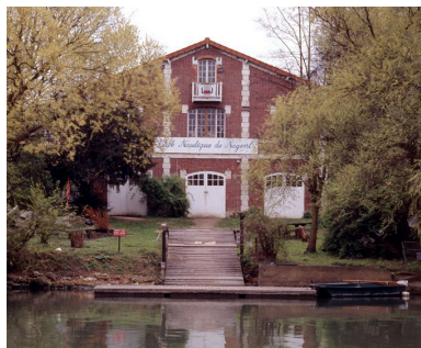
Vue des locaux du Club nautique de Nogent, club d'aviron. Phot. Stéphane Asseline IVR11_20059400229XA
