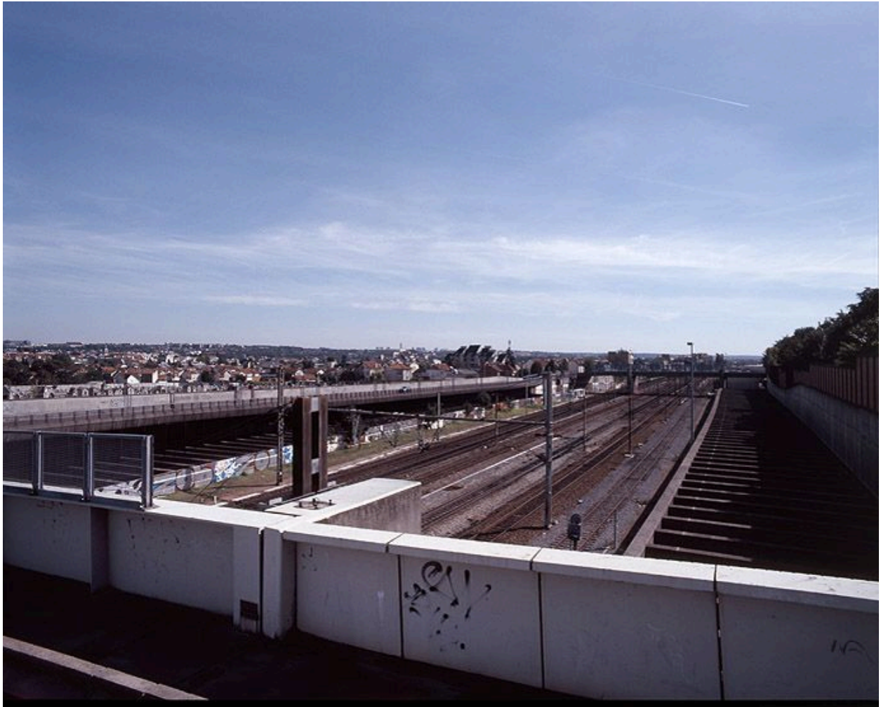
Vue depuis le pont franchissant les voies de chemin de fer et de l'autoroute, rue des Marlière.
