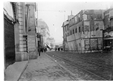
Vue de travaux d'élargissement de la Grande-Rue. Tirage photographique, circa 1925. Tiré de : Nogent-sur-Marne : étude de l'évolution d'une commune de banlieue. Thèse d'urbanisme, université d'urbanisme de Paris / Maurice Salabert, 1928. (Musée Nogent-sur-Marne) IVR11_20059400126NUCB
