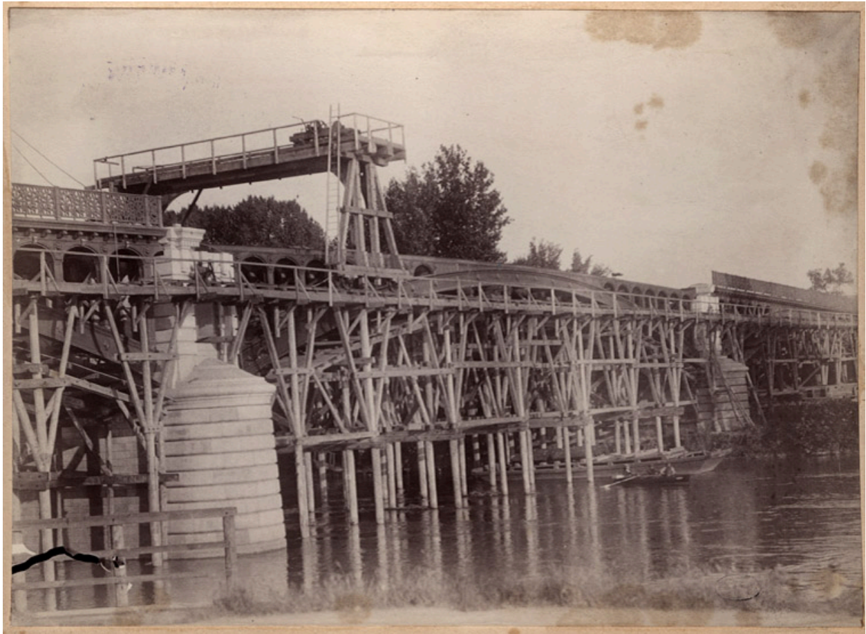
Vue du pont de Nogent en construction entre 1895 et 1899 et qui n'existe plus aujourd'hui. Photographie. (Musée Nogent-sur-Marne)
