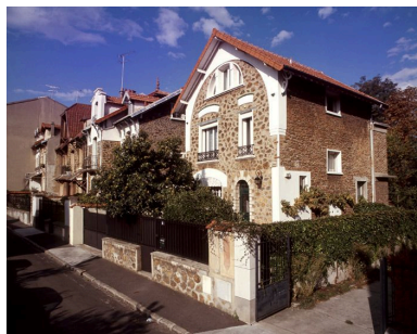
Vue de la rue de Pont Noyelles. Phot. Stéphane Asseline IVR11_20049400834XA
