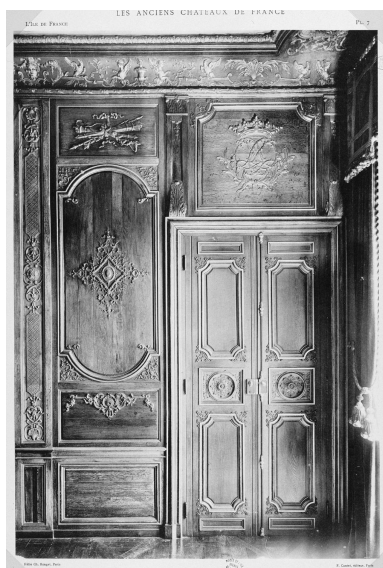
Le petit salon d'apparat du château avant sa transformation en établissement scolaire : détail des boiseries (un panneau et une porte). IVR11_20039101194XA
