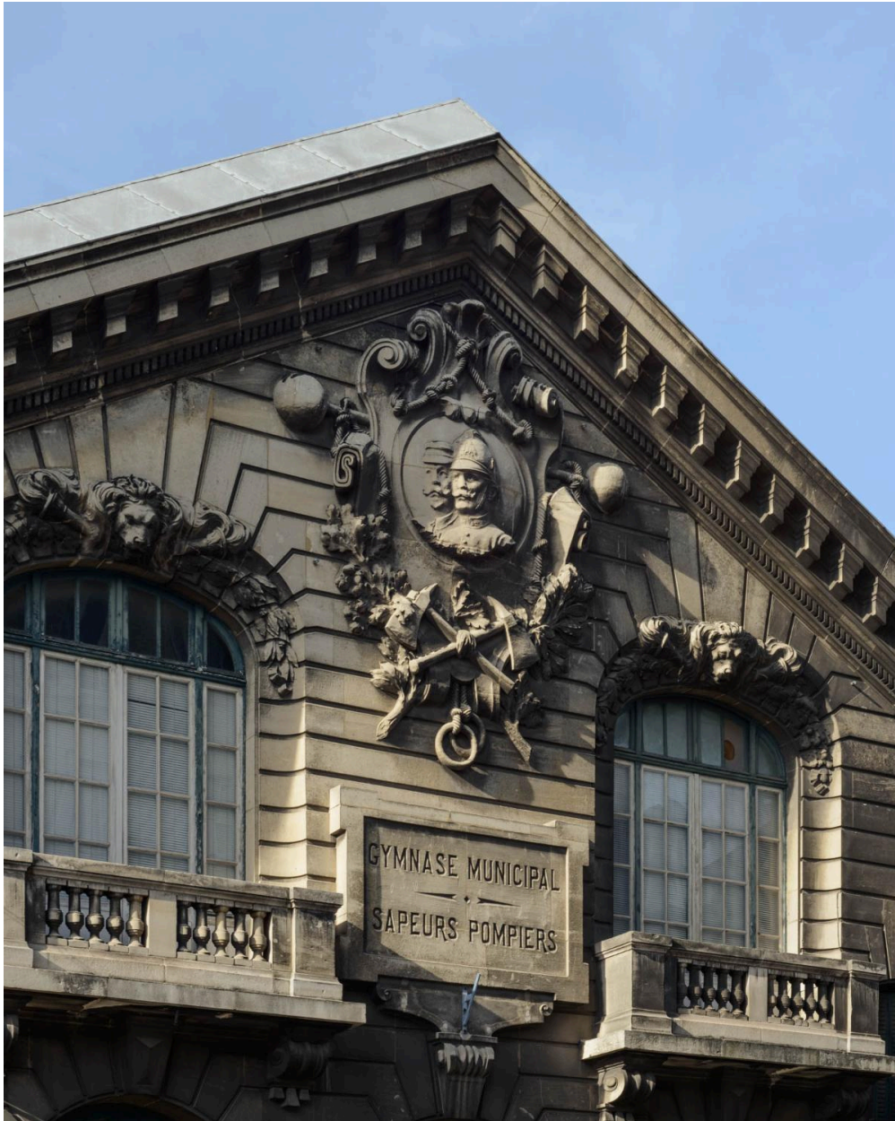
Détail de la façade sculptée du gymnase-caserne et du cartouche portant sa destination.
