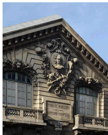
Détail de la façade sculptée du gymnase-caserne et du cartouche portant sa destination. Phot. Augustin Dupuid IVR11_20219300839NUC4A
