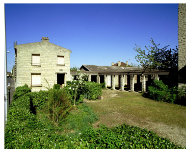
Vue de la façade latérale du presbytère et du portique de liaison avec l'église ; à l'arrière plan, la chapelle provisoire de la Reconstruction.
