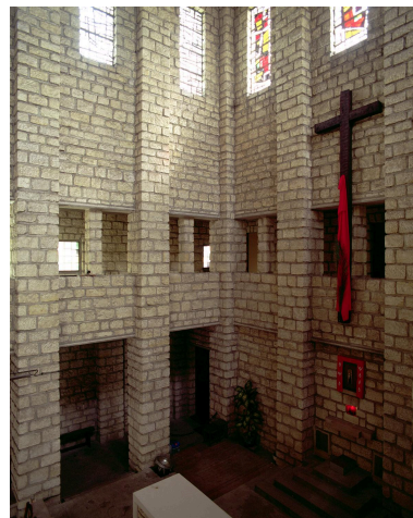
Vue intérieure du chœur. Phot. Philippe Ayrault IVR11_20039100549XA
