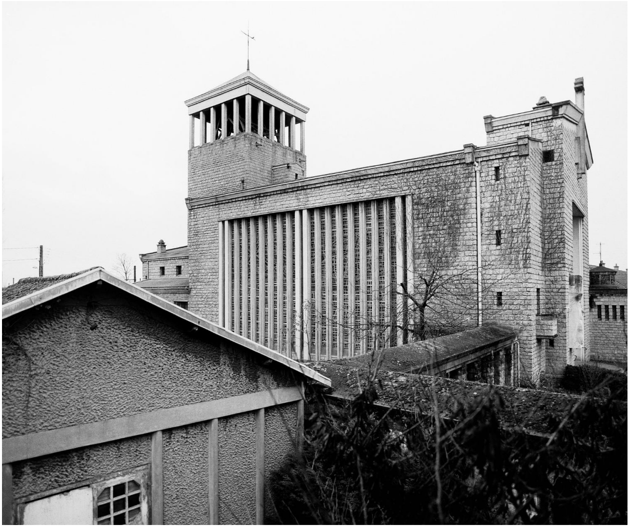
Vue latérale ; au premier plan, le fronton de la chapelle provisoire de la Reconstruction.
