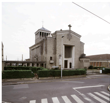
Vue d'ensemble. Phot. Philippe Ayrault IVR11_20039100432XA
