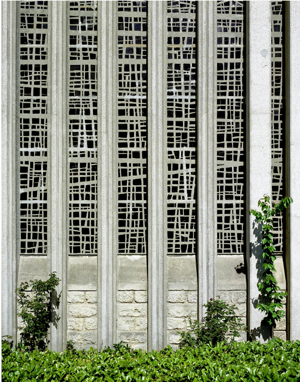
Détail des baies à claustra de la façade latérale ouest.
