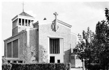
Vue d'ensemble. IVR11_20019100075XB
