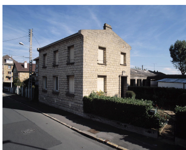
Vue d'ensemble du presbytère. Phot. Philippe Ayrault IVR11_20029101480XA
