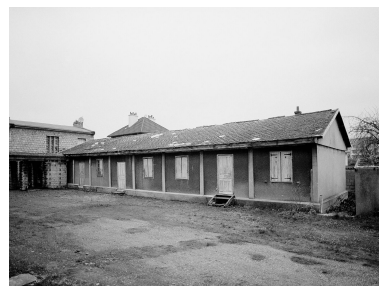
Vue latérale de la chapelle provisoire de la Reconstruction. Phot. Philippe Ayrault IVR11_20029101829X
