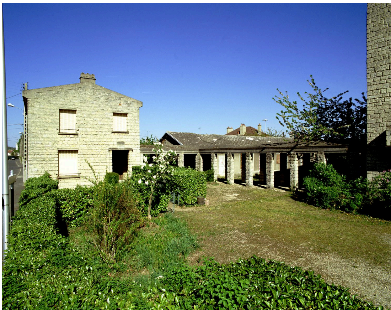
Vue de la façade latérale du presbytère et du portique de liaison avec l'église ; à l'arrière plan, la chapelle provisoire de la Reconstruction.
