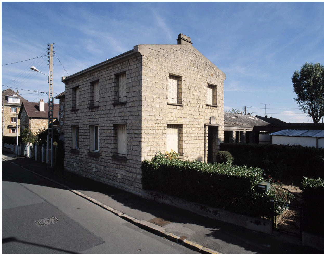
Vue d'ensemble du presbytère.
