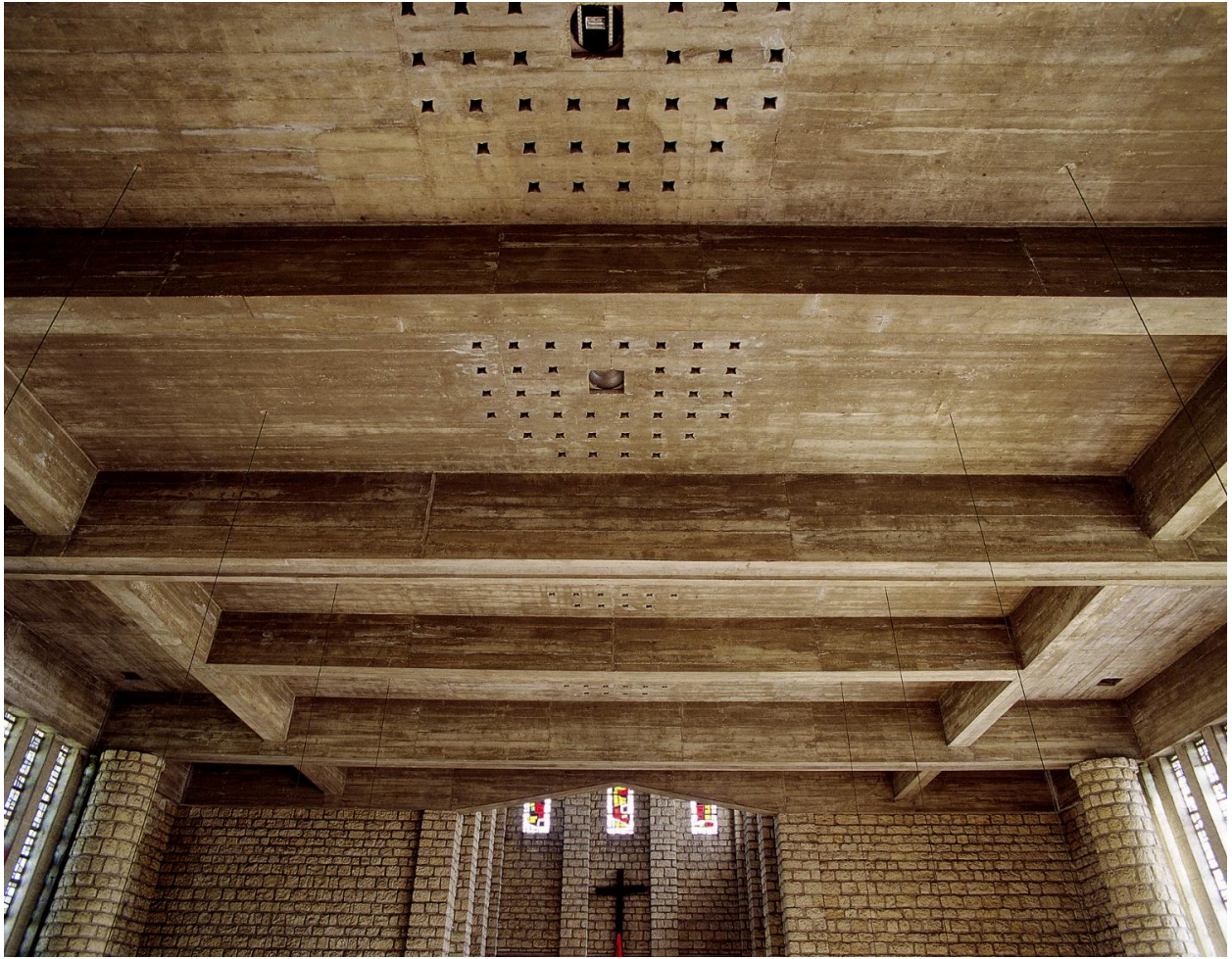
Vue du plafond caissonné avec dalles centrales perforées.
